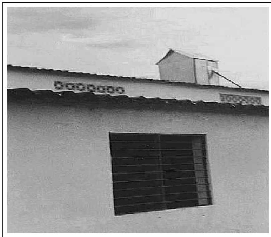
FOTO N° 4 Vista Lateral derecha instalaciones; ventana sala de oreo.
