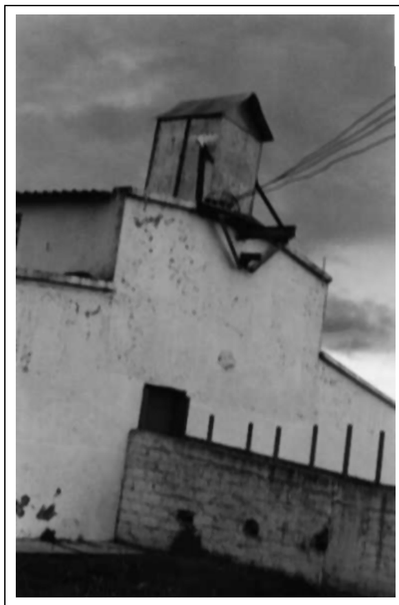
FOTO N° 3 Vista posterior de instalaciones; patios, entrada zona sacrificio
