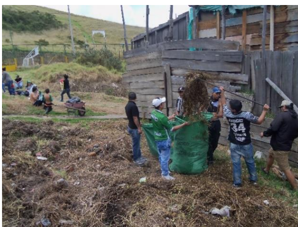
Ilustración 70 Adecuación y limpieza de lotes baldíos.
