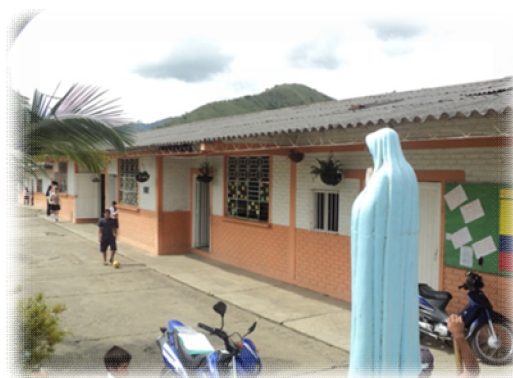
Imagen 2. Fachada instalaciones Pos primaria Puente Umbría.
