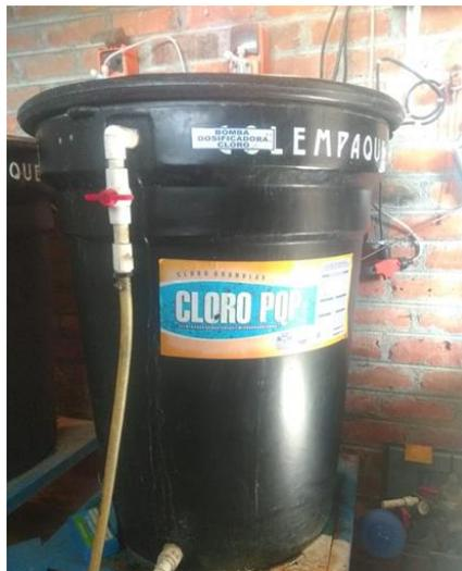
*Ilustración 6 Tanque dosificador de Cloro*
