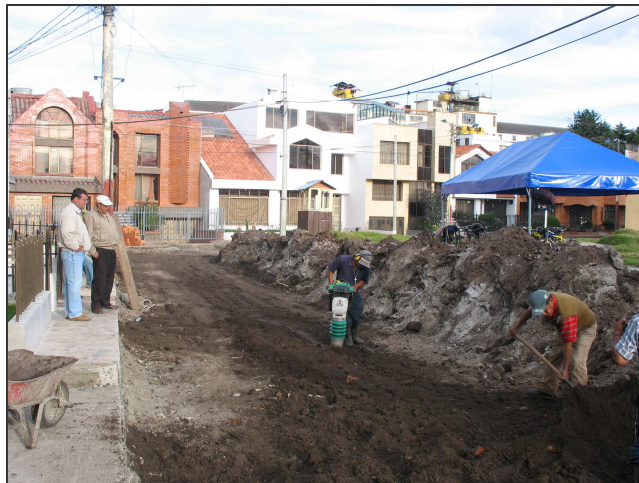
Figura 64.- Relleno y compactación de excavación.
