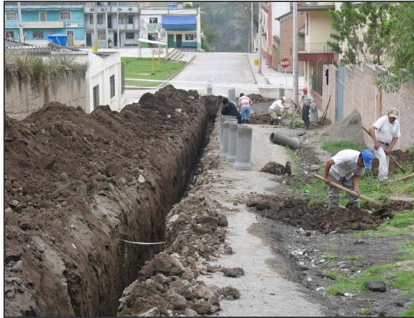
Figura 67.- Excavación a mano para acometidas.
