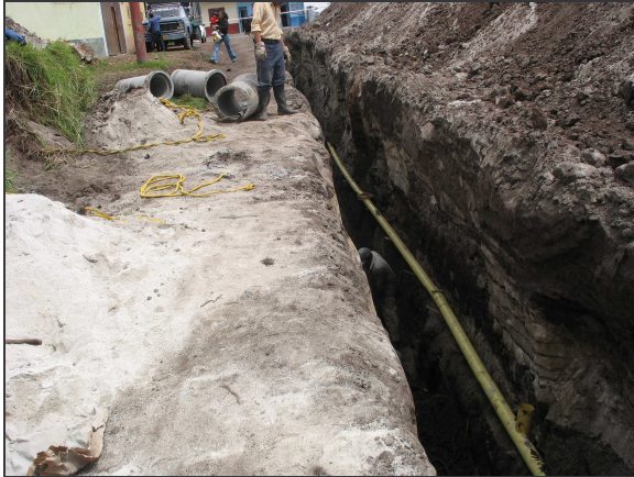
Figura 76.- Tubería provisional.
