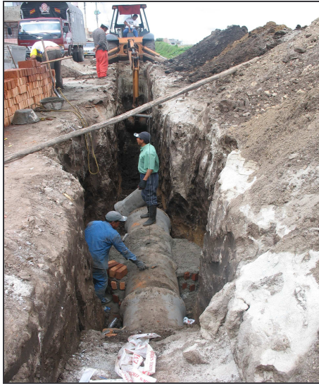
Figura 73.- Excavación de zanja.
