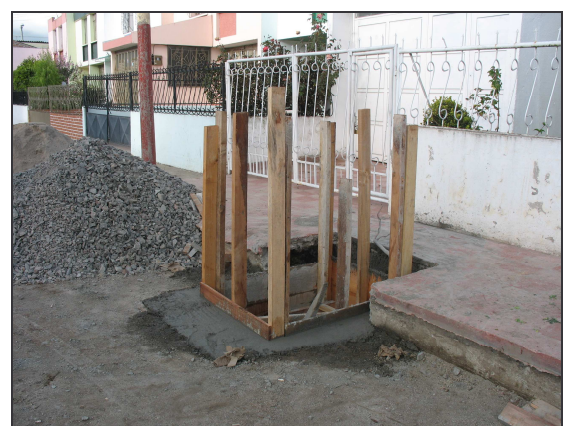
Figura 48.- Fundición de sumidero.
