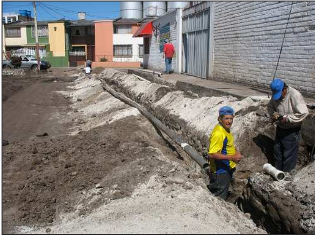
Figura 50.- Profundización de tubería.
