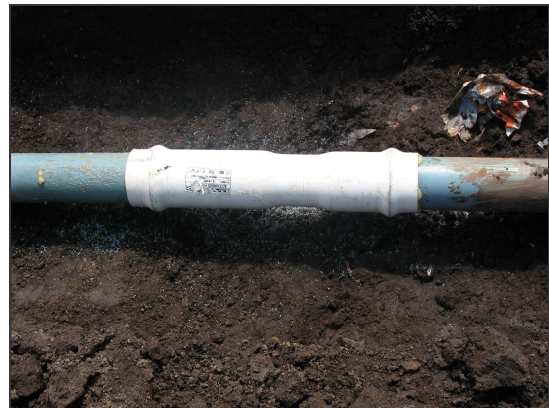
Figura 10.- Unión de tubería antigua.
