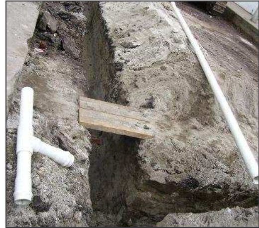
Figura 26.- Instalación y unión de tubería. Figura 27.- Tee en los cruces.
