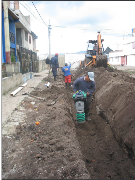
Figura 87.- Relleno y compactación
