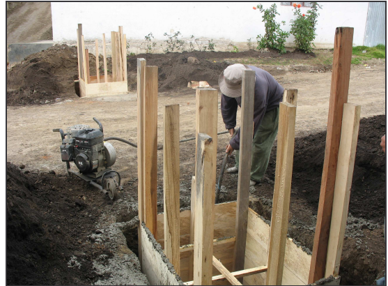
Figura 5.- Vibrado de concreto.
