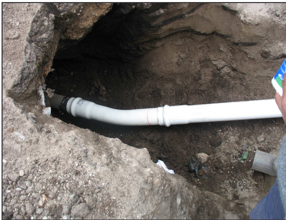
Figura 28.- Empate con tubería existente. Figura 29.- instalación de válvula.
