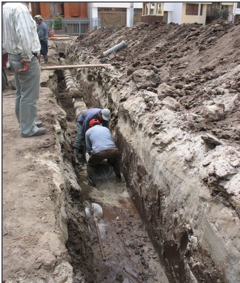
Figura 59.- Instalación de tubería de cemento. Figura 60.- Tubería instalada.
