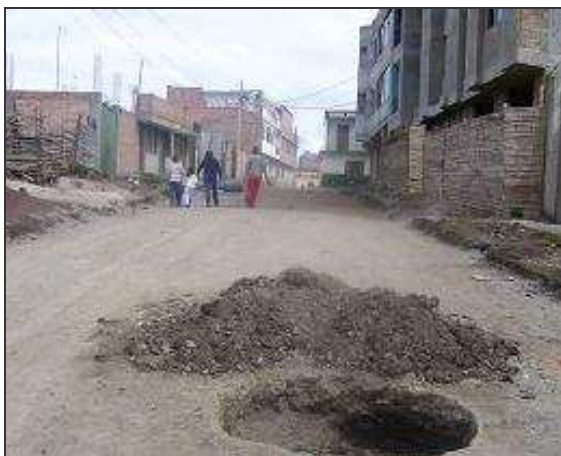
Figura 21.- Excavación y ubicación de cámaras.
