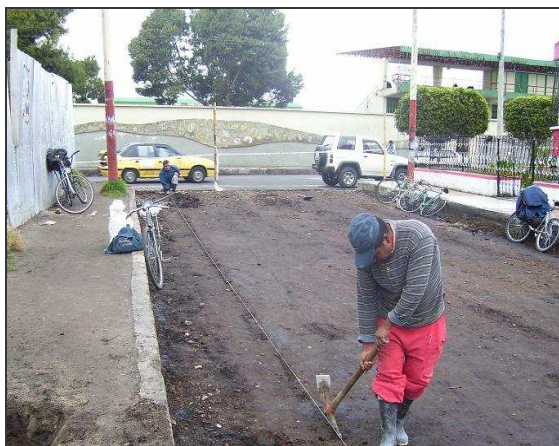
Figura 24.- Trazado para excavación.
