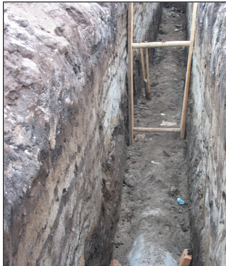
Figura 89.- Zanja apuntalada para evitar derrumbes.
