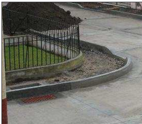
Figura 49.- Sumidero con rejilla.
