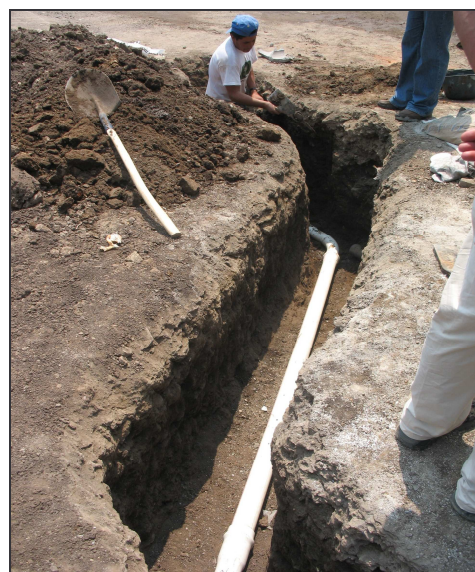
Figura 70.- Instalación de tubería.
