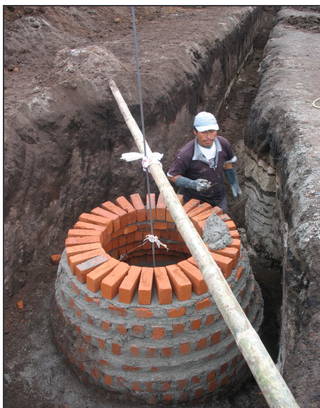
Figura 78.- Cámara con cono de reducción.
