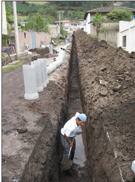
Figura 66.- Excavación y adecuación de piso de excavación.
