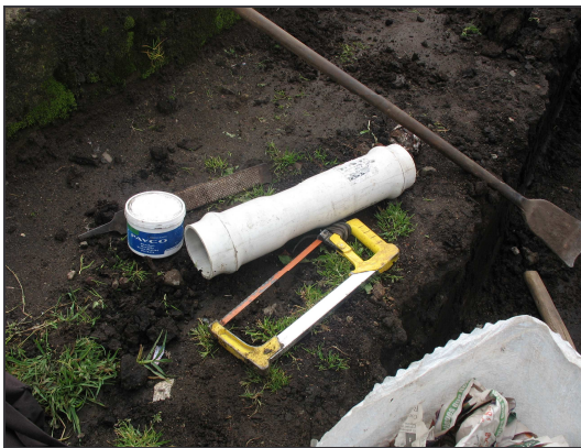
Figura 9.- Unión rápida y lubricante.
