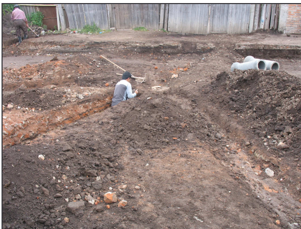
Figura 16.- Excavación a mano.
