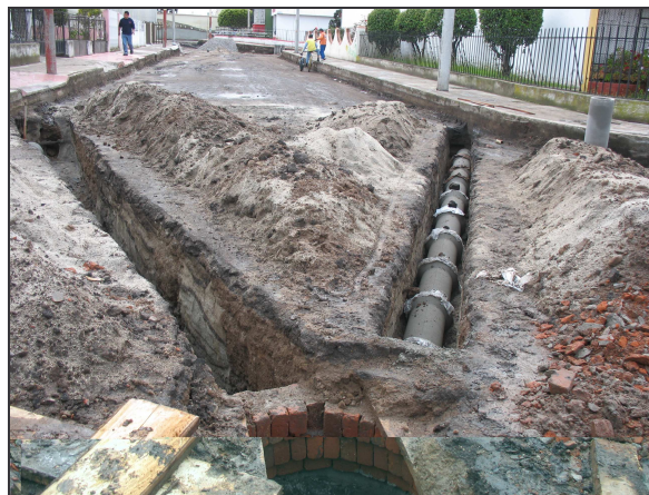
Figura 44.- Excavación y tubería instalada para desagüe de sumideros.
