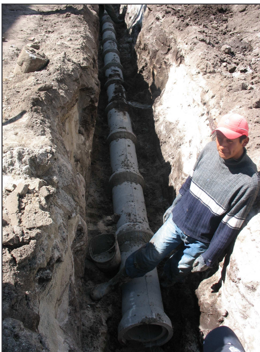
Figura 18.- Instalación de tubería.
