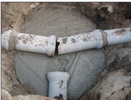
Figura 40.- Base de concreto.
