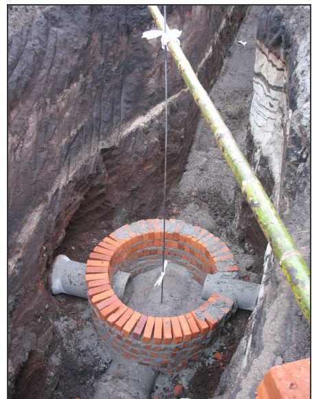
Figura 79.- Cámara para cruce.
