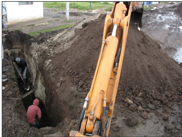
Figura 75.- Excavación para domiciliaria.
