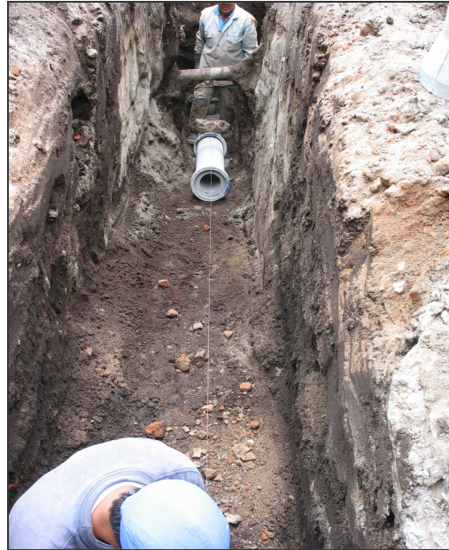
Figura 81.- Instalación de tubería de 6".
