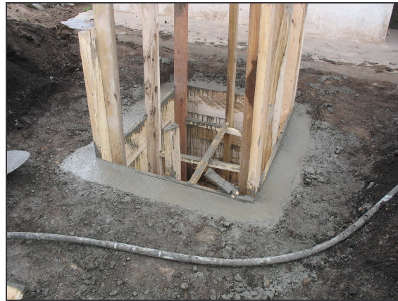
Figura 6.- Fundición de sumidero en concreto
