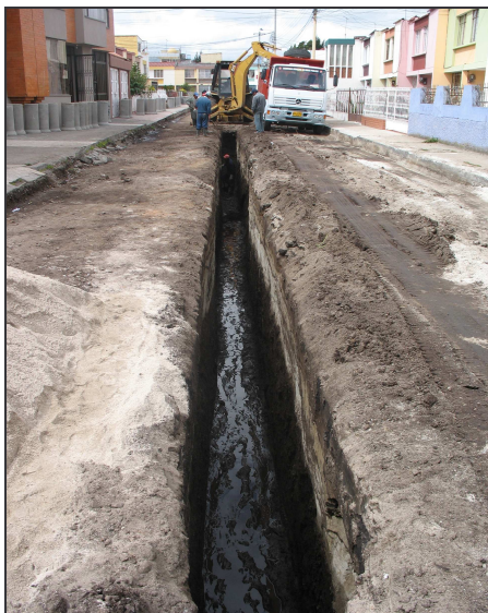
Figura 36.- Excavación a maquina.
