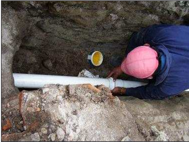
Figura 26.- Instalación y unión de tubería. Figura 27.- Tee en los cruces.
