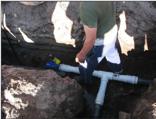
Figura 52.- Empate e instalación de Válvula.
