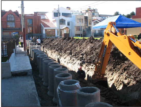
Figura 57.- Excavación a maquina.
