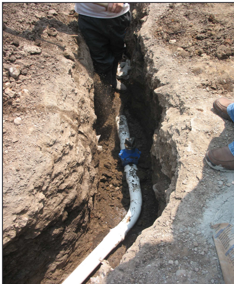
Figura 69.- Instalación de válvula.
