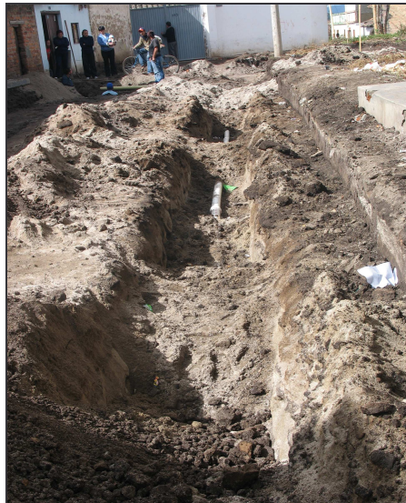
Figura 8.- Excavación y tubería de acueducto.
