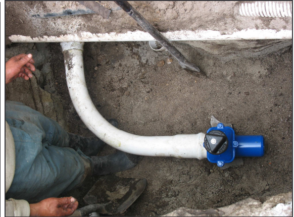
Figura 28.- Empate con tubería existente. Figura 29.- instalación de válvula.
