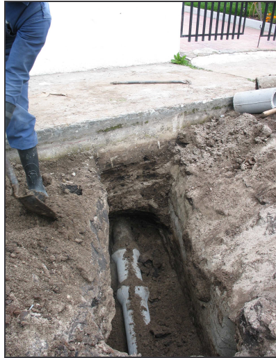
Figura 42.- Acometida desde andén. Figura 43.- Conexión con colector central.
