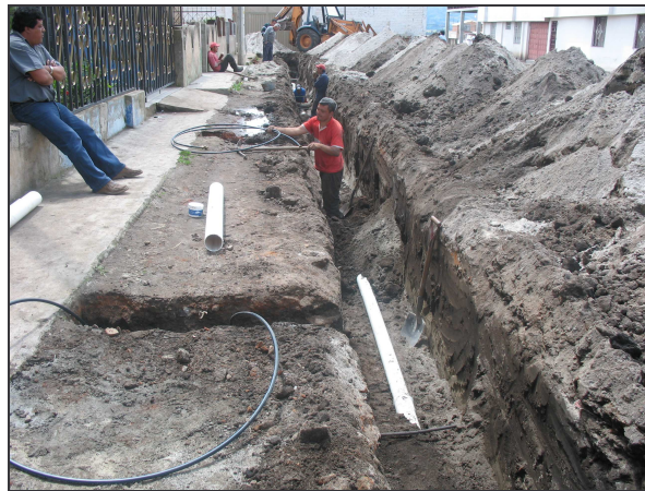
Figura 86.- Excavación y conexión de domiciliarias de acueducto.
