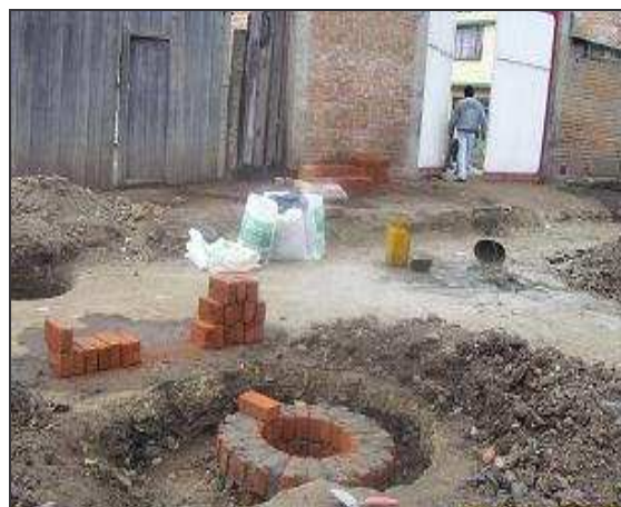
Figura 22.- Terminado de cámara.
