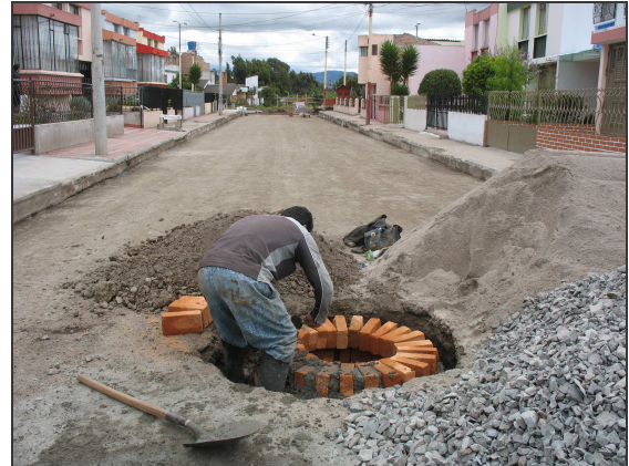
Figura 46.- Remate de cámara.
