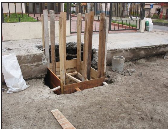
Figura 47.- Excavación y formaleta de sumidero.
