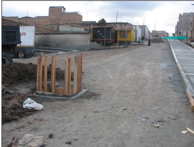
Figura 23.- Construcción de sumideros.
