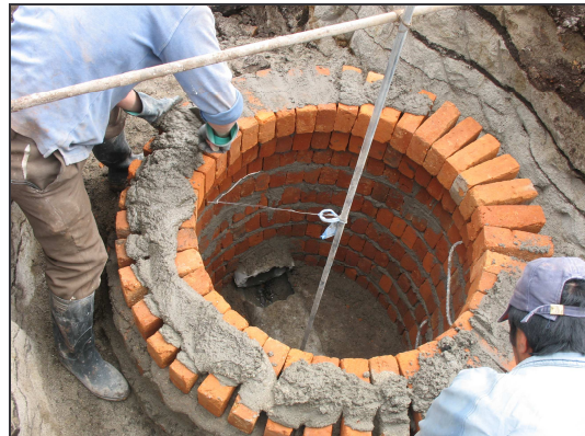
Figura 41.- Eje de cámara y pegue de ladrillo.
