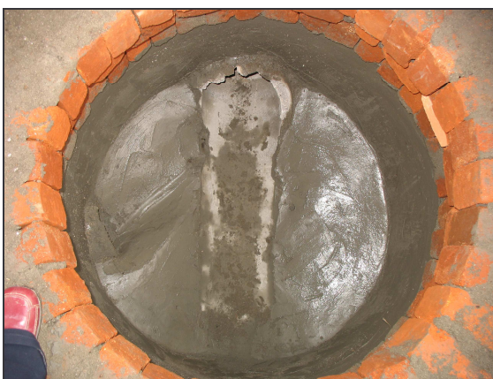
Figura 62.- Esmaltado de cámara y cañuela. Figura 63.- Cámara terminada.
