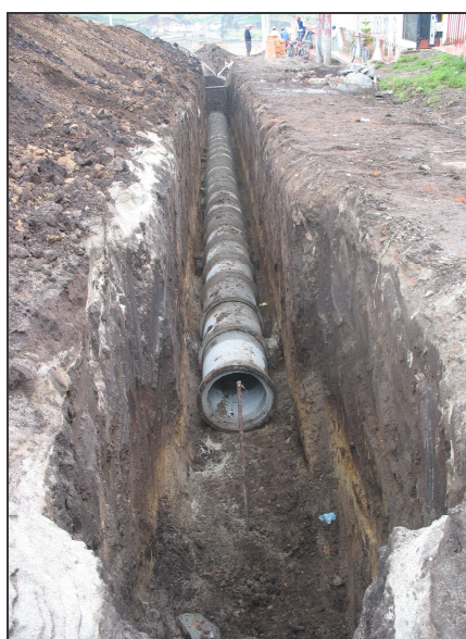
Figura 91.- Colector instalado.
