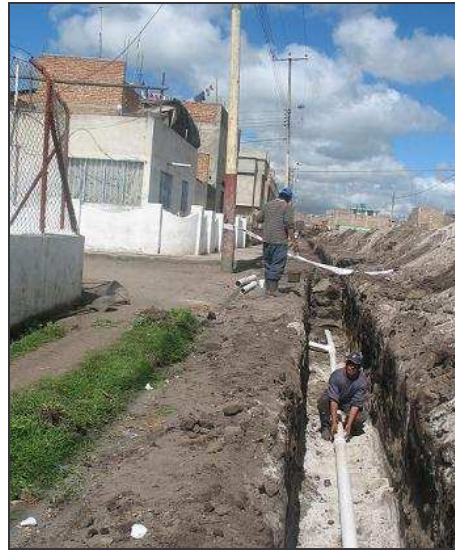
Figura 85.- Instalación de tubería y tee
