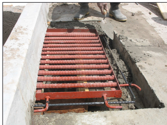
Figura 7.- Instalación de rejilla.
