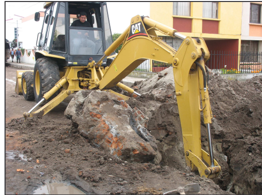
Figura 34.- Trazado de alineamiento. Figura 35.- Destrucción de la red antigua.
