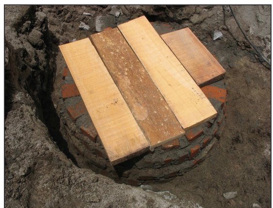
Figura 62.- Esmaltado de cámara y cañuela. Figura 63.- Cámara terminada.
