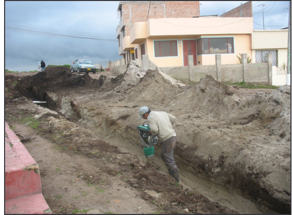
Figura 88.- Compactación mecánica.
