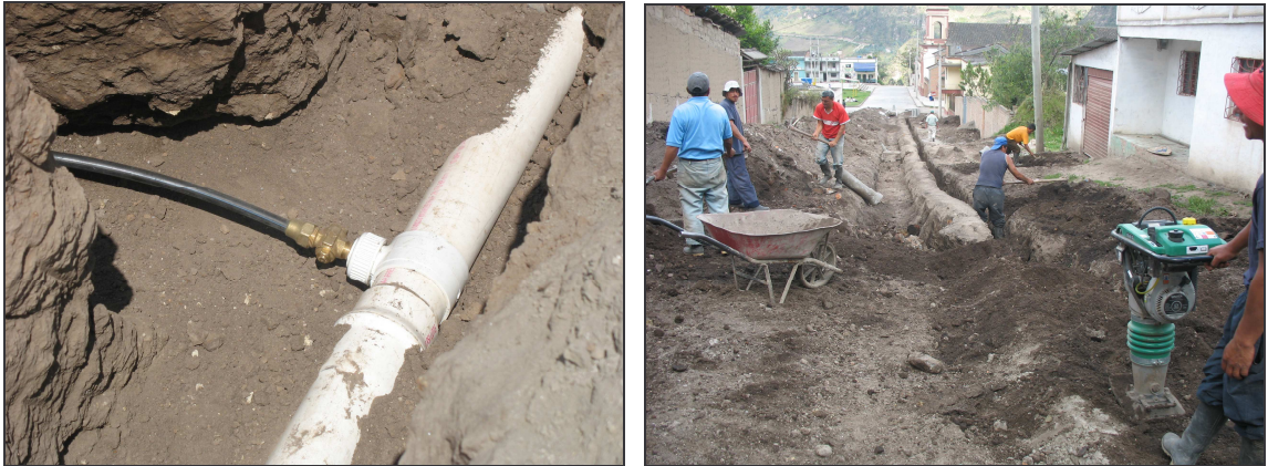
Figura 71.- Galápagu, llave y manguera PF. Figura 72.- Relleno y compactación.
