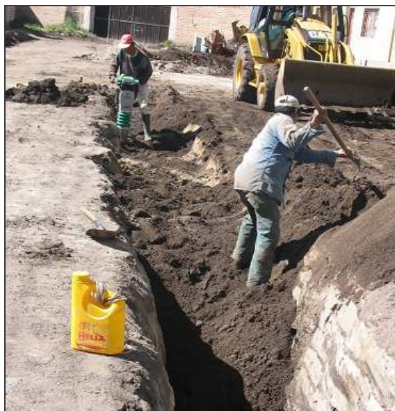
Figura 20.- Relleno y compactación.
