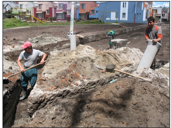
Figura 58.- Excavación a mano.
