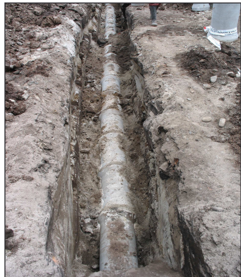
Figura 59.- Instalación de tubería de cemento. Figura 60.- Tubería instalada.
