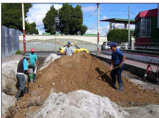
Figura 32.- Relleno y compactación.
