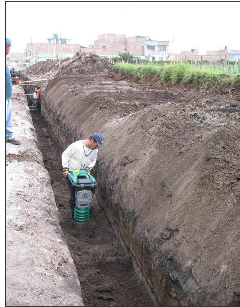
Figura 83.- Compactación mecánica.
