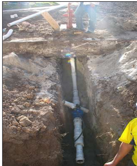
Figura 54.- Instalación de hidrante.
