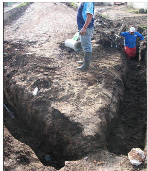
Figura 17.- Excavación a mano.
