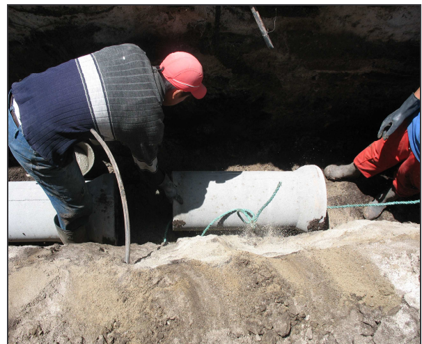
Figura 19.- Instalación de tubería.
