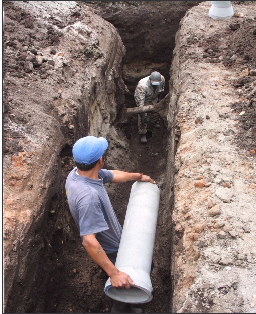
Figura 80.- suministro de tubería.
