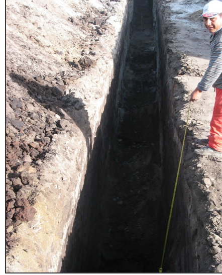
Figura 74.- Medida de profundidad.
