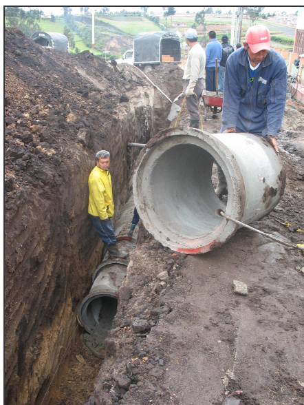
Figura 90.- Suministro de tubería.
