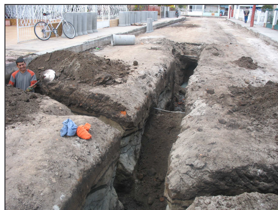
Figura 37.- Excavación a mano.
