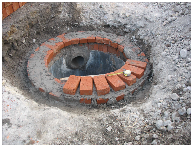
Figura 3.- Terminado de cámara.
