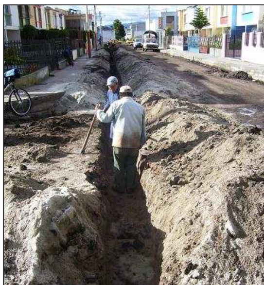
Figura 25.- Excavación a mano.
