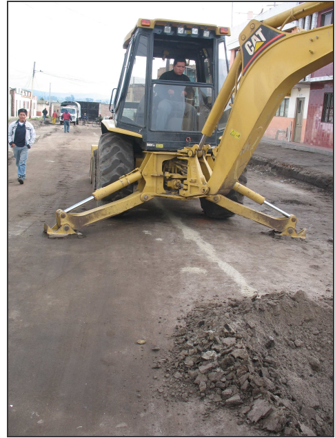
Figura 15.- Excavación a máquina.
