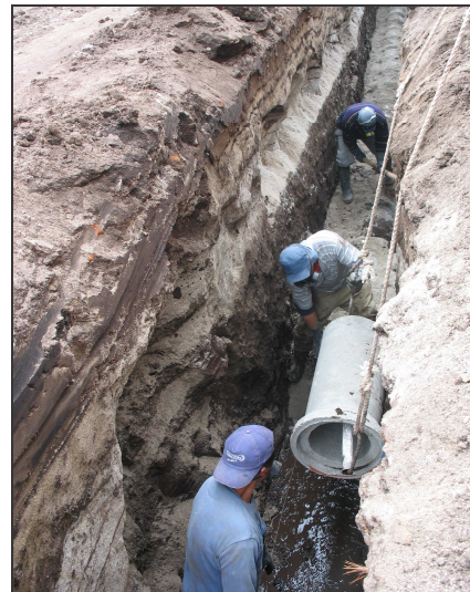
Figura 39.- Instalación de tubería.
