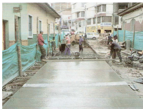
Fotografía No 112. Acabado del concreto con tela de lona
