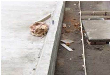
Fotografía No 45. Sardinel descimbrado y acabado
