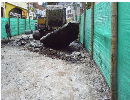
Fotografías No 67 y No 68. Demolición de concreto hidráulico
