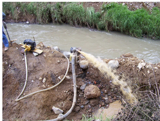
Fotografía No 128. Bombeo de agua filtrada
