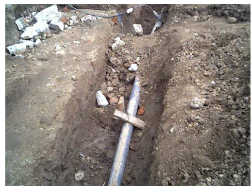
Fotografía No 215 y No 216. Tubería de acueducto superficial
