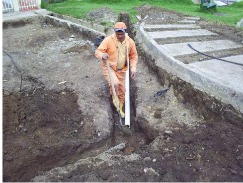
Fotografía No 9. Prolongaciones calle 16 a
