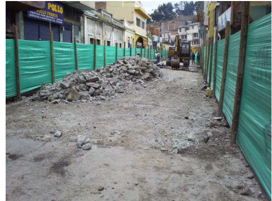
Fotografías No 67 y No 68. Demolición de concreto hidráulico
