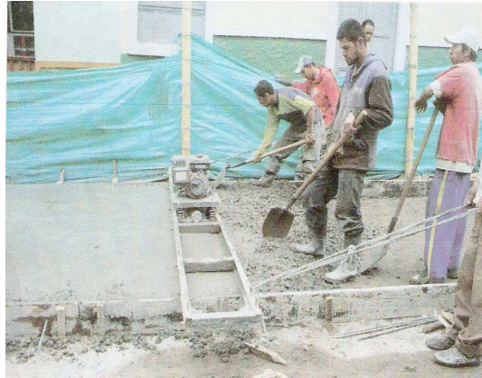
Fotografía No 111. Vibración externa con regla vibratoria
