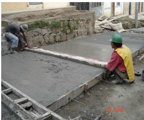
Fotografía No 204 y No 205. Acabado con tela de lona y texturizado
