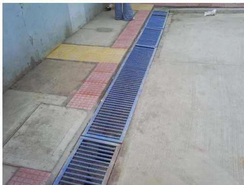
Fotografía No 56. Rejillas después de adecuación
