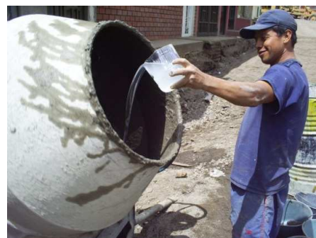
Fotografías No 15 y No 16. Aplicación y dosis de acelerante
