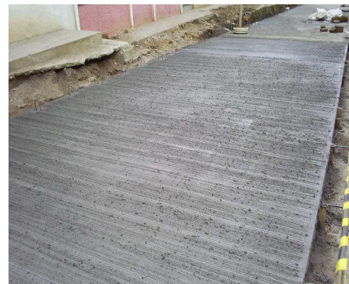
Fotografía No 204 y No 205. Acabado con tela de lona y texturizado
