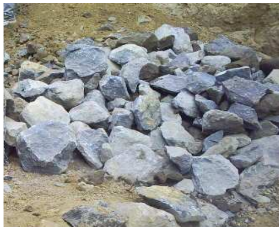
Fotografía No 131. Rajón para construcción de Gaviones
