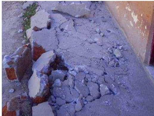
Fotografía No 3. Demolición de andenes
