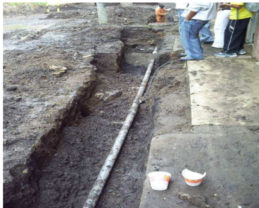
Fotografía No 10. Excavación para movimiento de tubería
