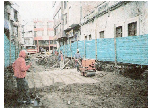
Fotografía No 93 No 94. Mezclado y sellado de suelo-cemento
