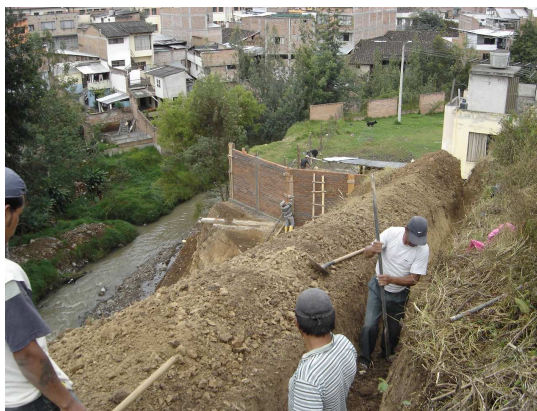
Fotografía No 169. Zanja de coronación
