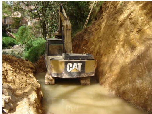
Fotografía No 124. Cajeo hecho a máquina
