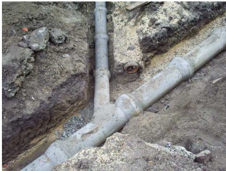
Fotografía No 88. Empalme con tubería principal de alcantarillado
