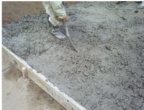
Fotografía No 40. Vibrado interno de inmersión
