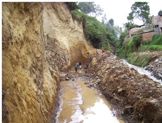
Fotografía No 124. Cajeo hecho a máquina
