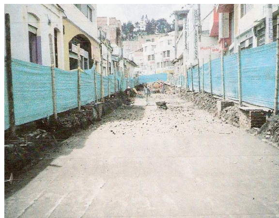
Fotografía No 95. Capa de suelo-cemento terminada
