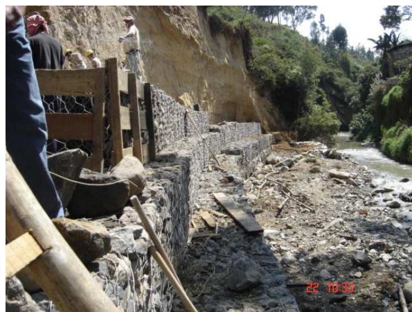
Fotografía No 150. Construcción de quinto nivel
