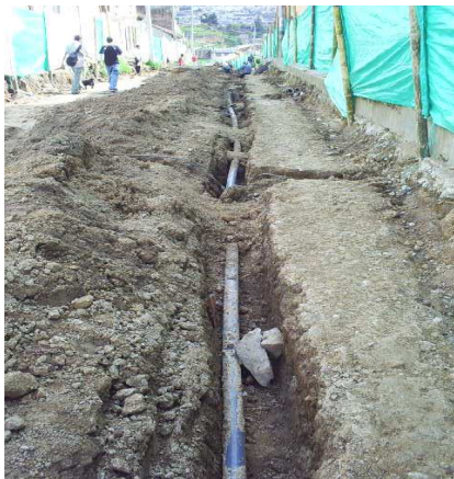
Fotografía No 217 y No 218. Descubrimiento de tubería y Profundización
