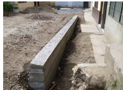
Fotografías No 22 y No 23. Armado de formaleta y muro descimbrado.
