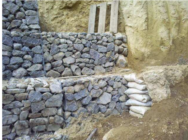
Fotografía No 149. Cuña para encausar el río
