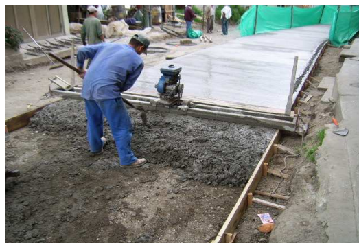
Fotografía 41. Vibración externa con regla vibratoria
