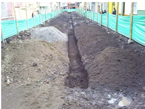
Fotografías No 84 y No 85. Excavación para tubería de 10" y nivelación de superficie
