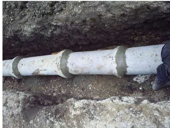
Fotografía No 86. Instalación de tubería 10"
