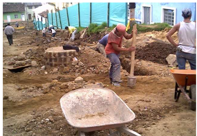
Fotografía No 217 y No 218. Descubrimiento de tubería y Profundización
