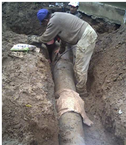
Fotografía No 185. Instalación de tubería
