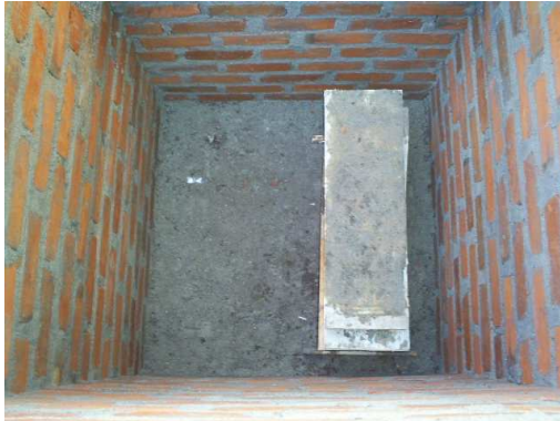
Fotografía No 183 Y No 184. Mampostería e impermeabilizado de Sumidero
