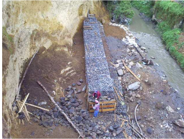
Fotografía No 147. Obra vista desde parte superior
