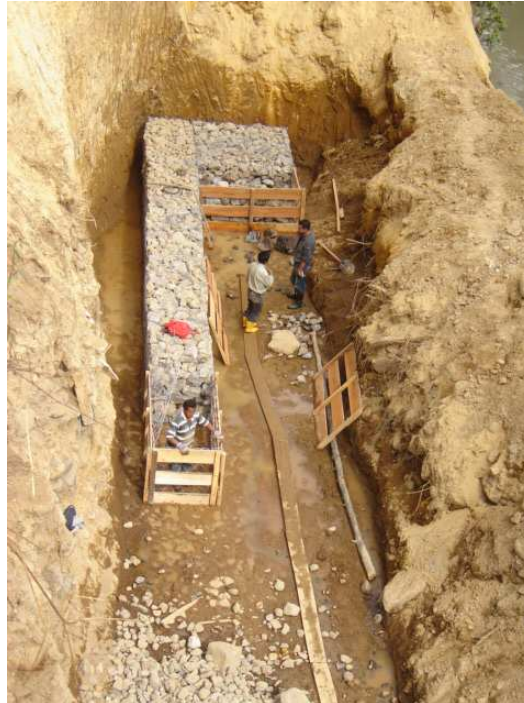
Fotografía No 137. Construcción de primer nivel
