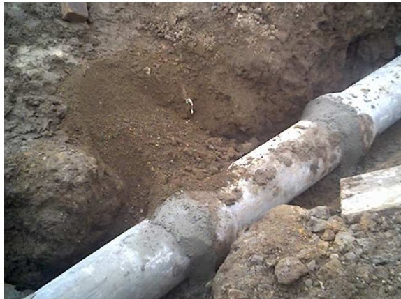
Fotografía No 186. Pega de tubería con mortero 1:3
