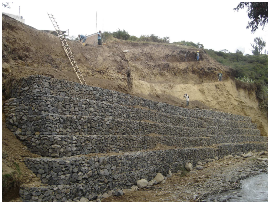
Fotografía No 174. Muro de contención en gaviones totalmente ejecutado
