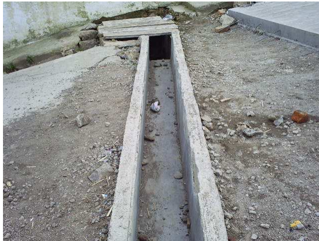
Fotografía No 225. Canal del sumidero
