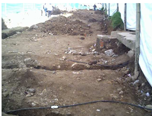
Fotografías No 219 y No 220. Acometidas de acueducto manguera pf 1/2"
