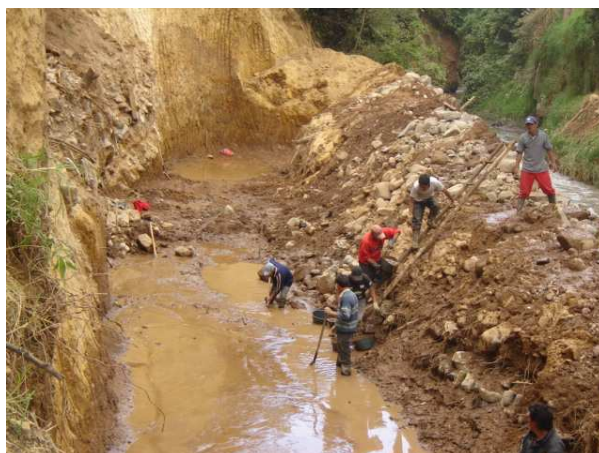
Fotografía No 126. Evacuación de lodo hacia el lecho del rio
