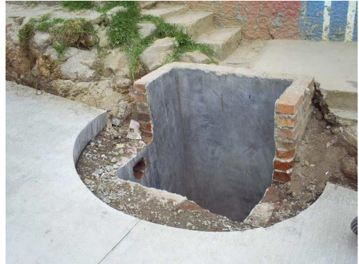
Fotografía No 183 Y No 184. Mampostería e impermeabilizado de Sumidero
