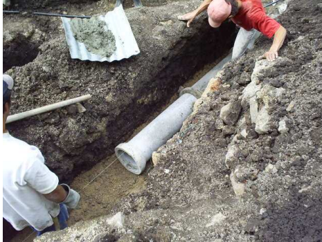
Fotografía No 88. Empalme con tubería principal de alcantarillado
