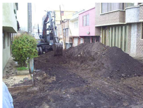
Fotografías No 4 y No 5. Excavación a máquina
