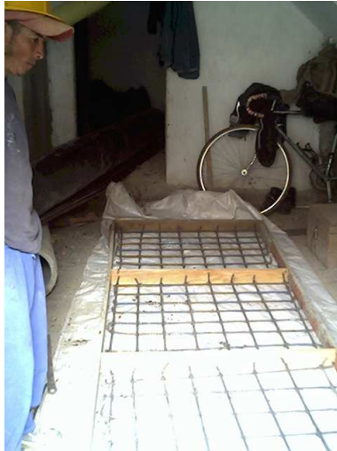
Fotografía No 214. Construcción de tapas para cajillas
