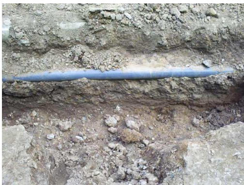
Fotografía No 215 y No 216. Tubería de acueducto superficial
