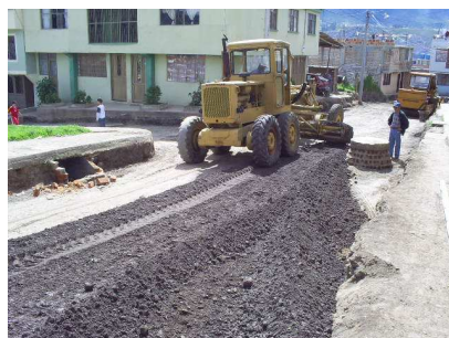
Fotografías No 30 y No 31. Extensión y homogenización de base granular.
