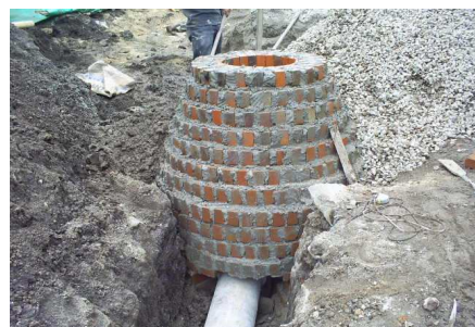
Fotografías No 89 y No 90. Construcción cámaras de inspección
