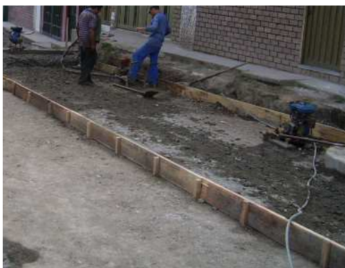
Fotografía No 37. Formaleta lista para fundición
