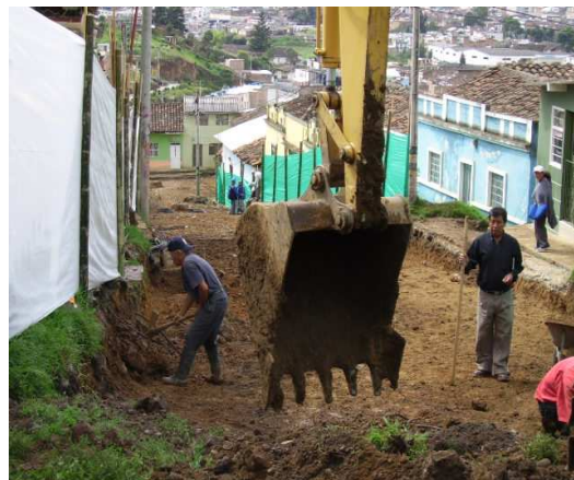
Fotografía No 176 y 177. Excavación a maquina y material orgánico
