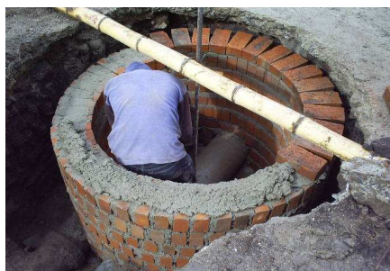
Fotografías No 89 y No 90. Construcción cámaras de inspección
