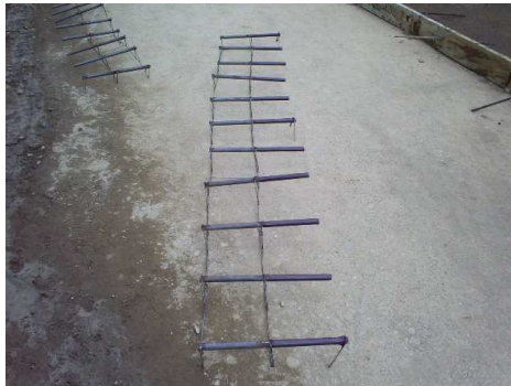
Fotografía No 38. Canastilla y pasadores de transferencia engrasados
