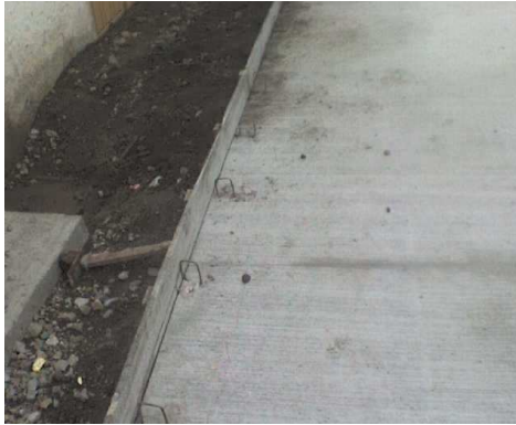
Fotografía No 43. Flejes para sardinel incrustados en la placa
