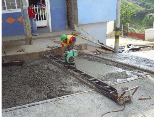
Fotografía No 203. Vibración superficial con regla vibratoria
