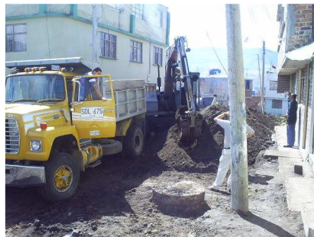
Fotografías No 12 Y No 13. Cargue de material sobrante.
