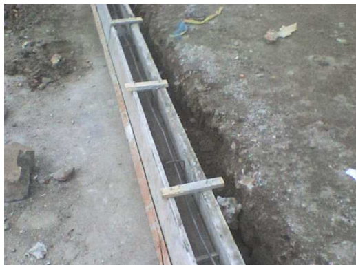
Fotografía No 44. Refuerzo y formaleta lista para el vaseado
