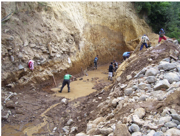
Fotografía No 125. Trabajos de excavación a mano bajo agua
