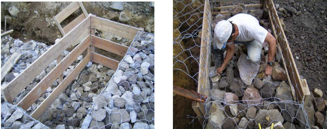
Fotografía No 135 y No 136. Construcción de formaleta y llenado de malla
