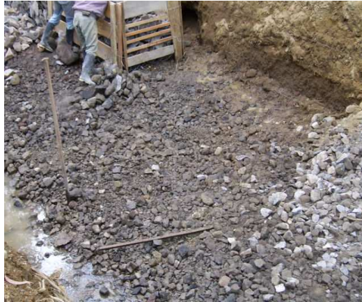
Fotografía No 130. Mejoramiento de suelo
