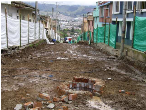
Fotografías No 187 y No 188. Realce de cámaras de alcantarillado, antes y después
