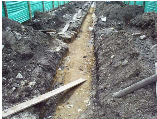
Fotografía No 92. Relleno de excavaciones para tuberías
