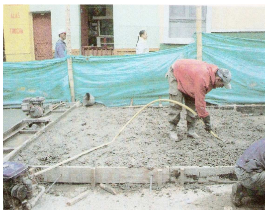
Fotografía No 110. Vibrado interno de inmersión
