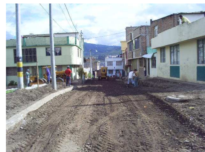
Fotografías No 30 y No 31. Extensión y homogenización de base granular.
