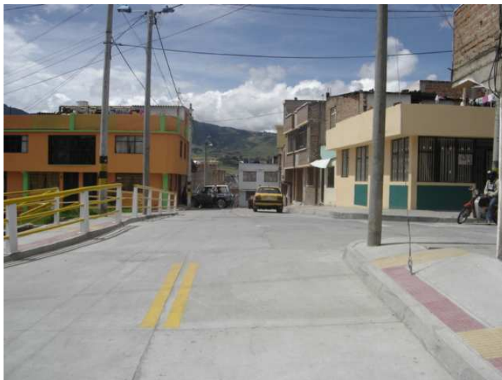
Fotografía 61. Calle 16A terminada
