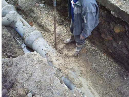
Fotografía No 92. Relleno de excavaciones para tuberías
