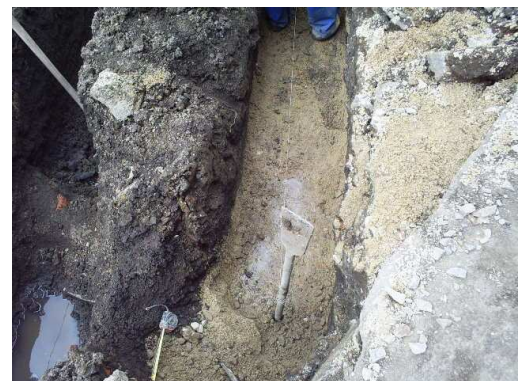
Fotografías No 84 y No 85. Excavación para tubería de 10" y nivelación de superficie
