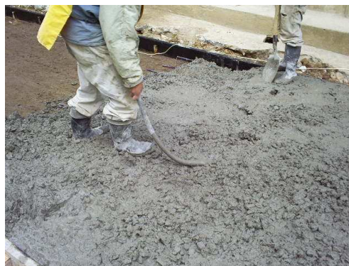
Fotografía No 202. Vibrado interno de inmersión
