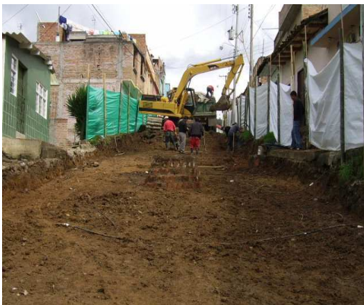
Fotografía No 176 y 177. Excavación a maquina y material orgánico
