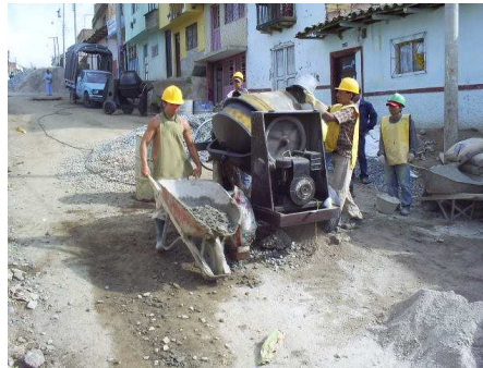
Fotografía No 201. Mezcla de materiales
