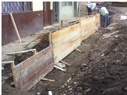
Fotografías No 22 y No 23. Armado de formaleta y muro descimbrado.
