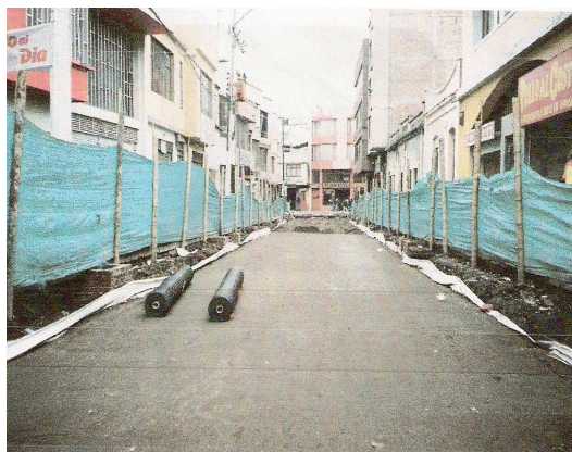
Fotografía No 102. Instalación de geomalla
