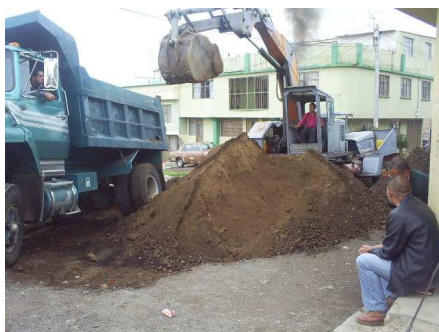
Fotografías No 12 Y No 13. Cargue de material sobrante.
