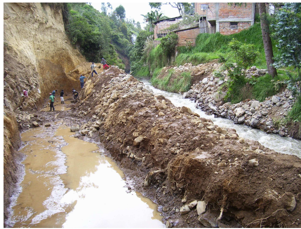
Fotografía No 127. Base de muro ya perfilada
