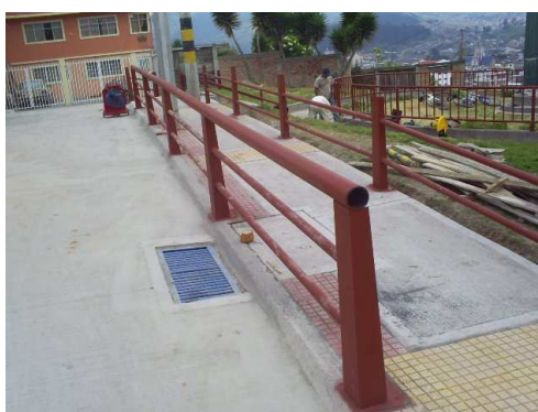
Fotografía No 57. Pasamanos ya montado
