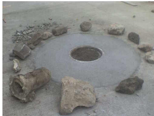
Fotografías No 187 y No 188. Realce de cámaras de alcantarillado, antes y después
