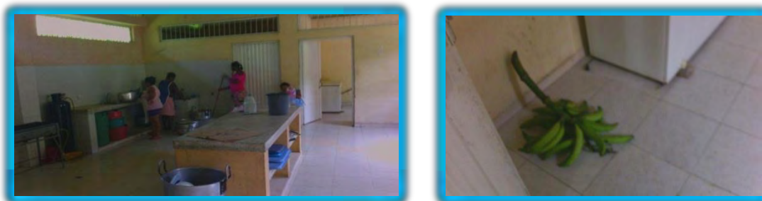
Figura 11. Puerta a la derecha refrigeradores y Ubicación inadecuada de un racimo de platanos (ITA)
