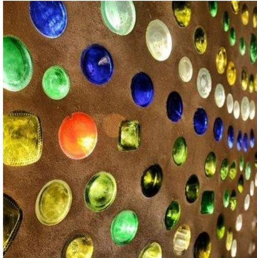
Imagen 53. Muro de tierra con técnica de Botedillo
