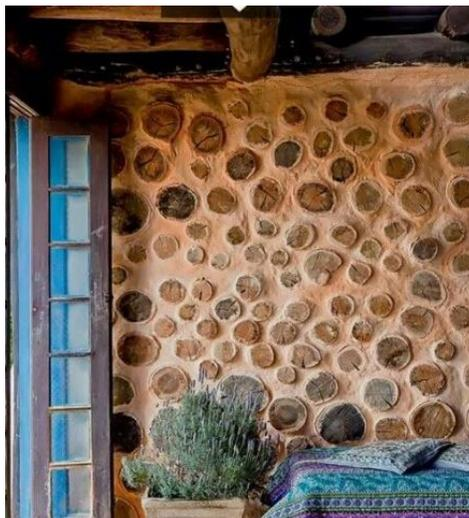
Imagen 54. Técnica troncos de madera en muros de tierra.
