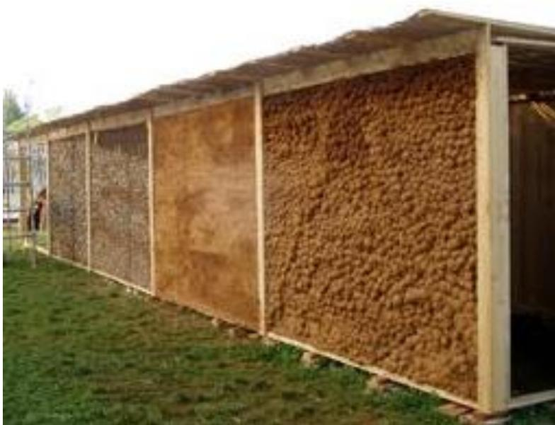
Imagen 52. Muros realizados con la técnica del Bahareque
