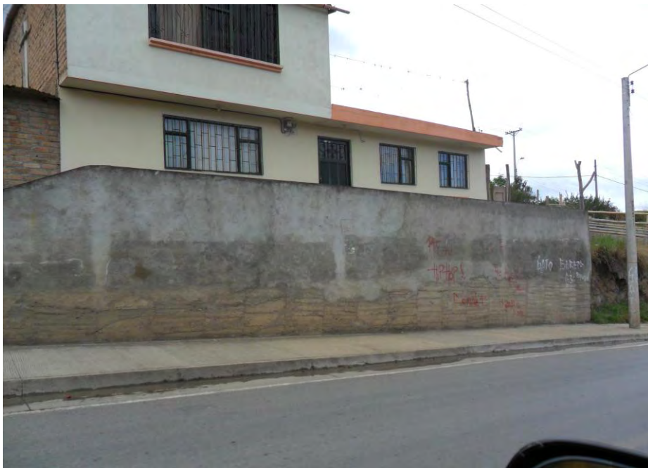
Fotografía 8. Muro de contención, corregimiento de Jongovito.
