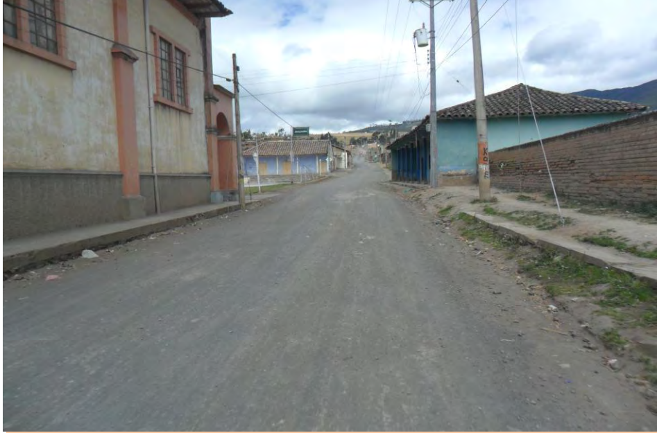
Fotografía 5. Estructura de afirmado corregimiento de Jongovito
