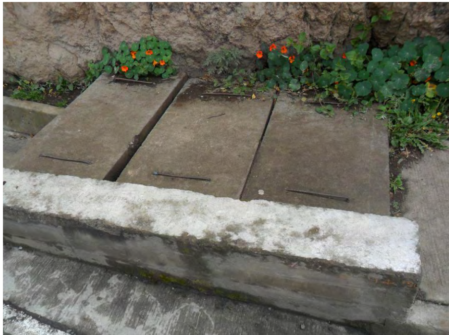
Fotografía 7. Alcantarilla, corregimiento de Jongovito K0+290
