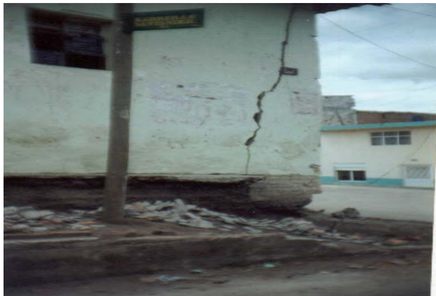
Imagen N° 4 Infraestructura de la Escuela
