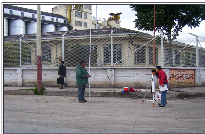
Figura 25. Localización y replanteo
