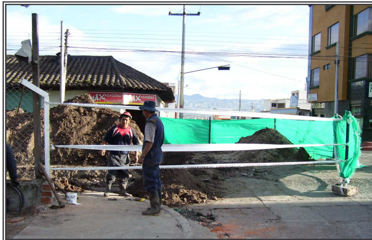
Figura 52. Señalización con cinta
