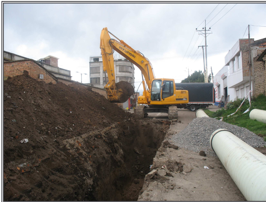
Figura 72. Excavación a máquina (retroexcavadora de oruga)
