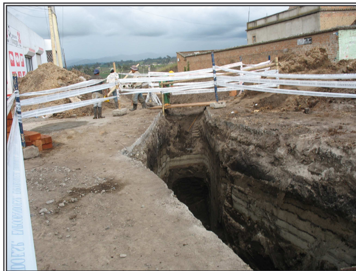
Figura 88. Señalización con cinta.
