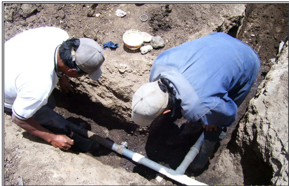
Figura 16. Reparación de redes de acueducto.
