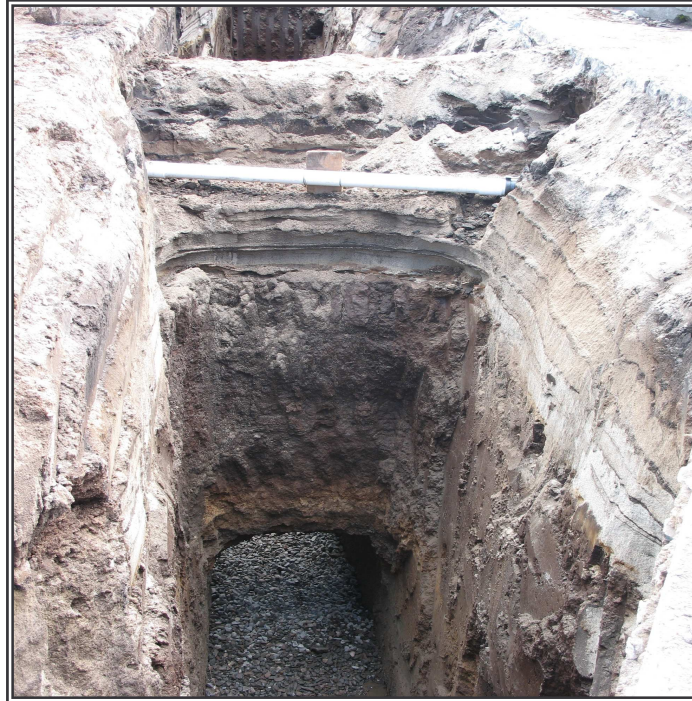
Figura 87. Túneles y puentes de estabilización
