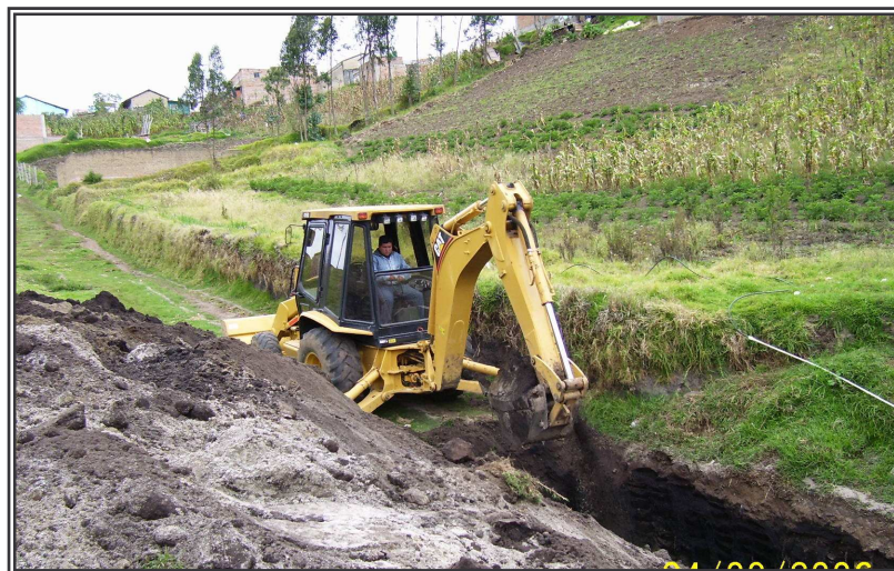
Figura 4. Excavación a máquina (retroexcavadora pajarita)
