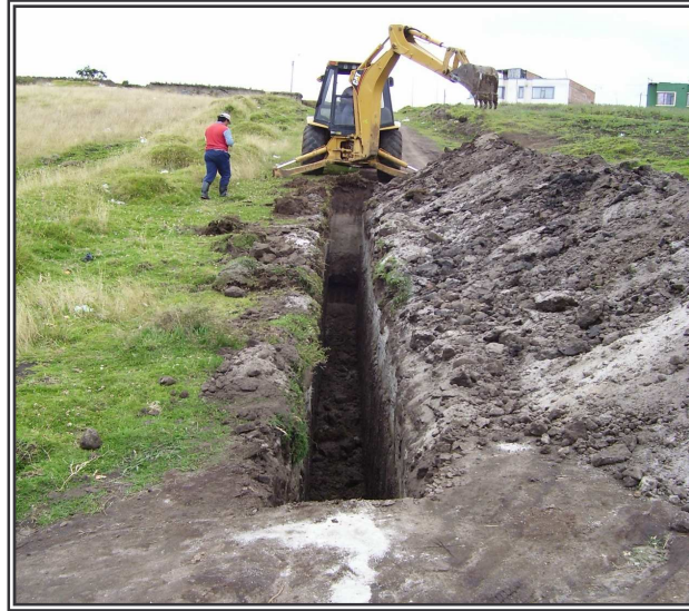
Figura 55. Excavación a máquina (retroexcavadora tipo pajarita)
