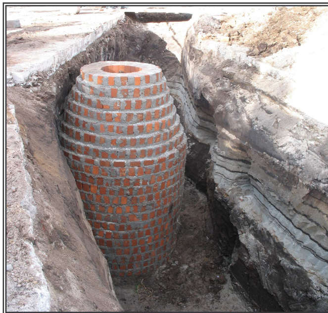
Figura 80. Cámara de inspección terminada
