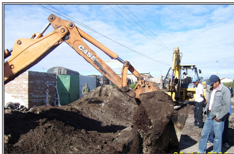
Figura 45. Uso de maquinaria para relleno final de la chamba
