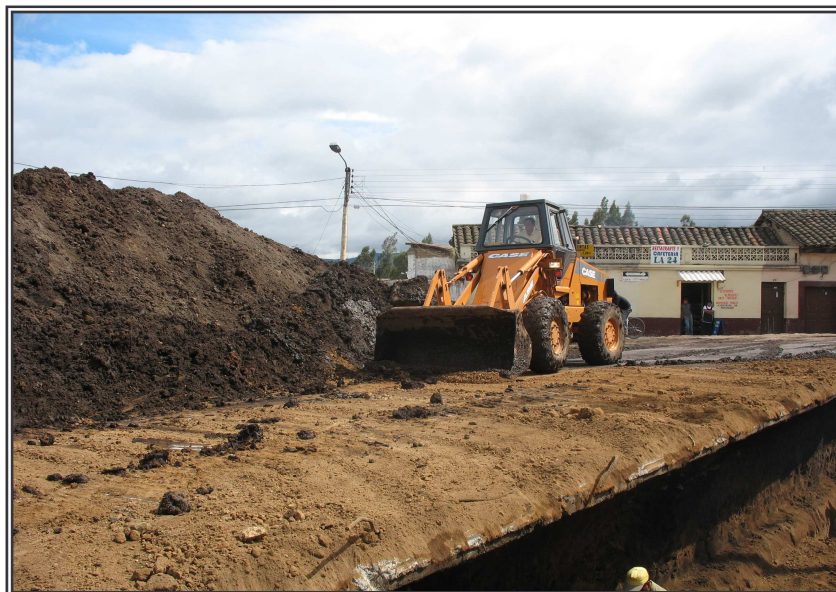
Figura 85. Maquinaria usada en el retiro y desalojo de sobrantes
