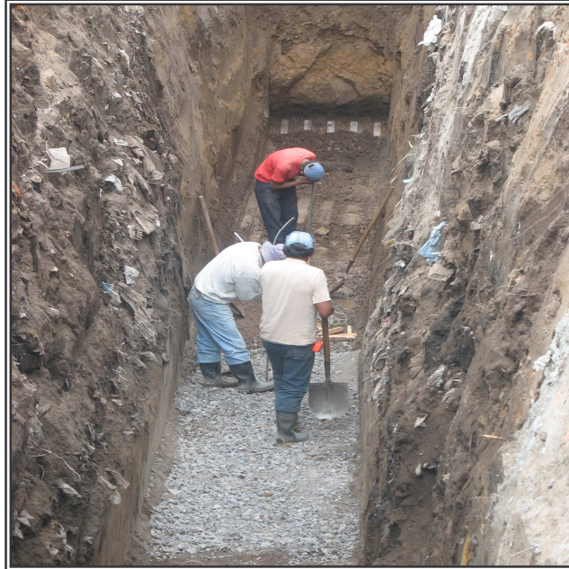
Figura 74. Cimentación en triturado
