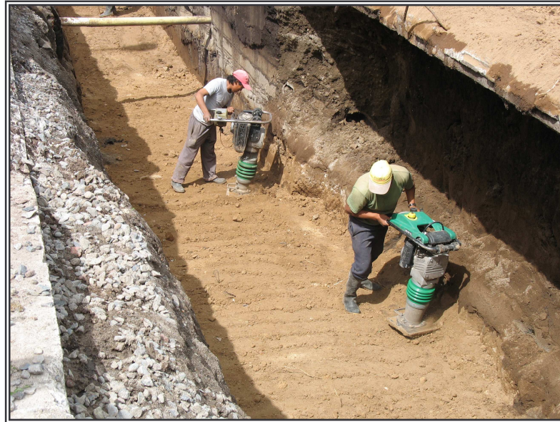
Figura 83. Uso de maquinaria para relleno final de la chamba
