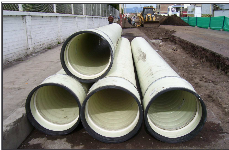
Figura 34. Tubería NOVALOC de 27 y 24 pulgadas de diámetro y uniones acopladas a la misma.
