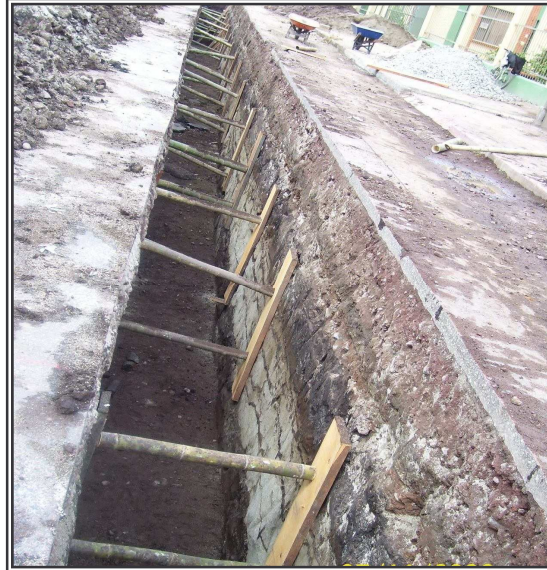
Figura 50. Entibado de chamba
