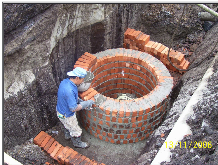
Figura 42. Construcción de cámara de inspección
