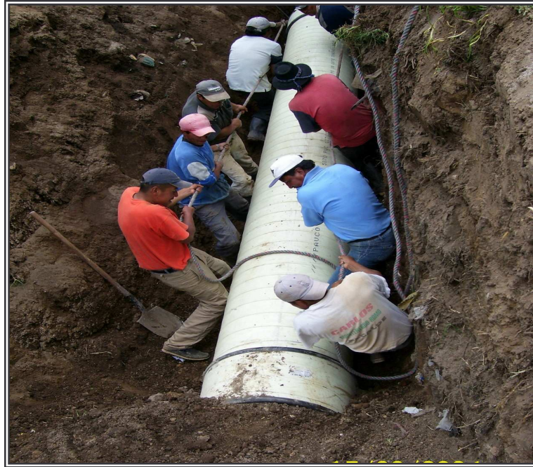
Figura 11. Secuencia de acople de la tubería NOVALOC
