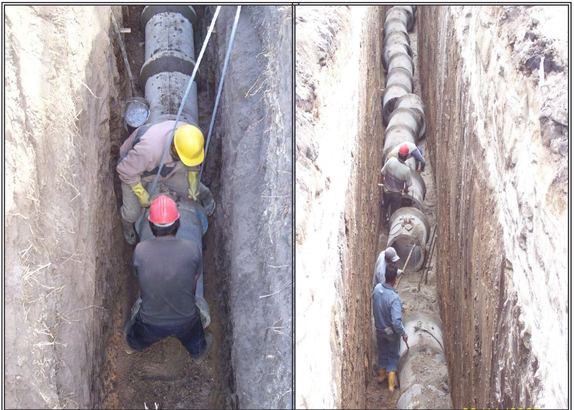
Figura 58. Instalación de tubería de cemento de 16 y 24 pulgadas de diámetro
