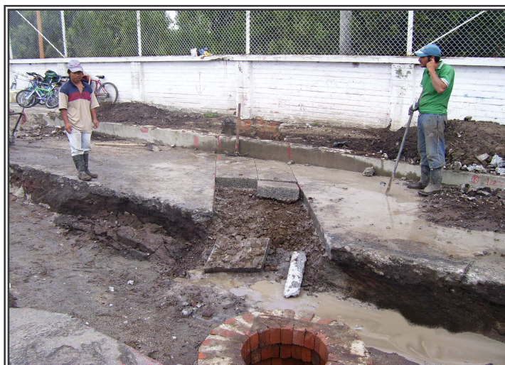
Figura 27. Retiro y demolición de pavimento hidráulico
