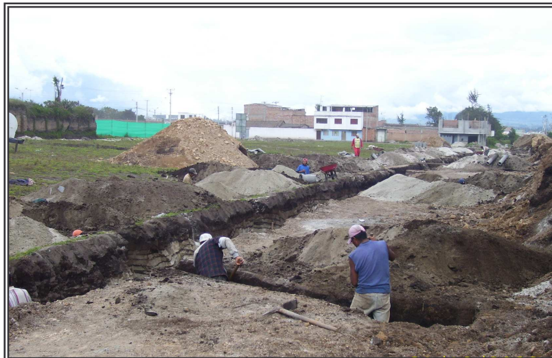
Figura 54. Excavación manual
