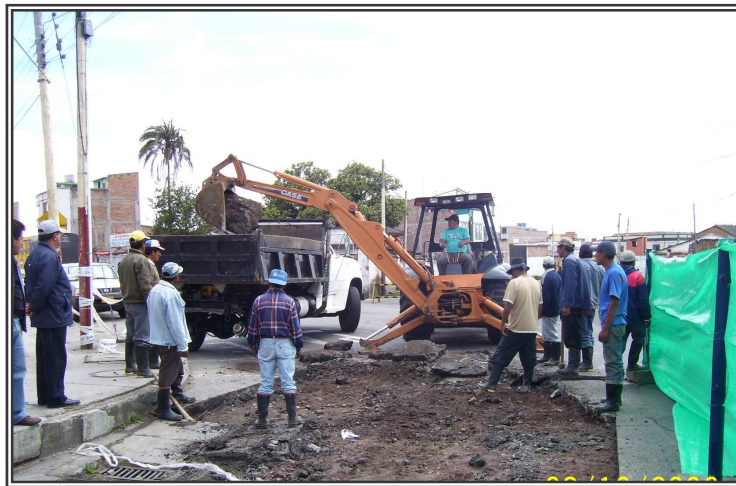
Figura 27. Retiro y demolición de pavimento hidráulico
