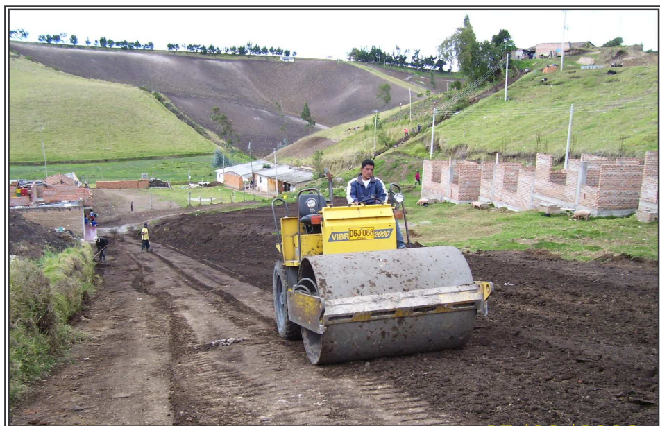
Figura 21. Compactación final con vibrocompactador de rodillo.
