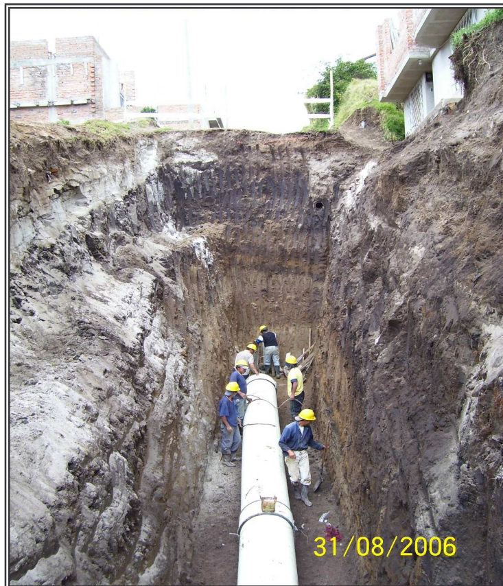
Figura 23. Uso de casco para seguridad del trabajador
