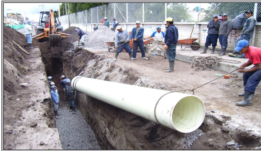
Figura 39. Secuencia de acople de la tubería NOVALOC y NOVAFORT
