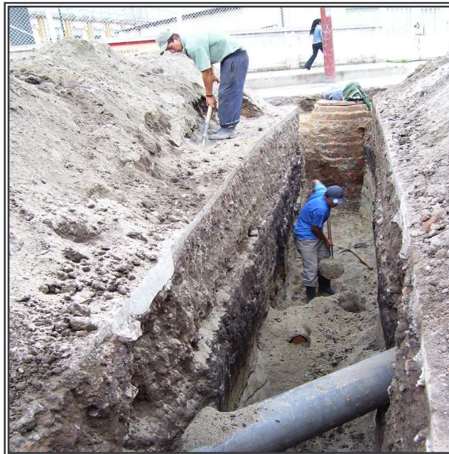
Figura 28. Excavación manual
