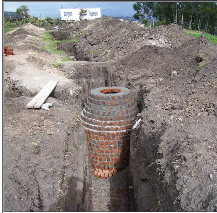
Figura 60.- Cámara de inspección terminada
