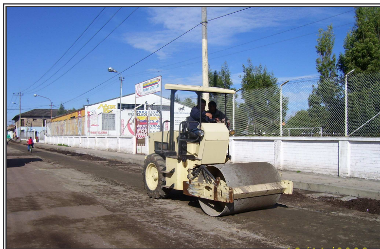
Figura 47. Compactación final con vibro compactador de rodillo
