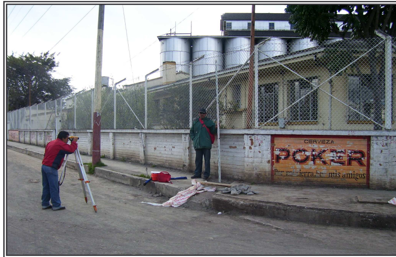
Figura 68. Localización y replanteo
