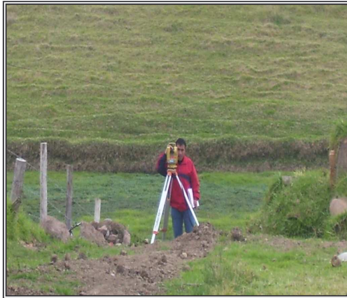
Figura 1. Localización y replanteo
