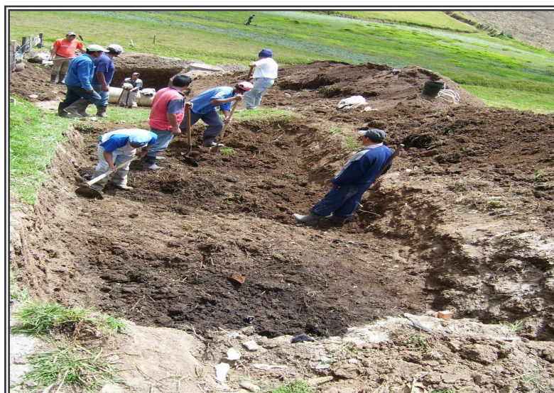
Figura 2. Excavación manual
