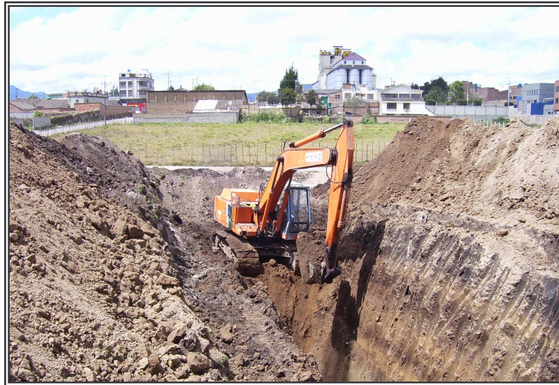
Figura 4. Excavación a máquina (retroexcavadora pajarita)
