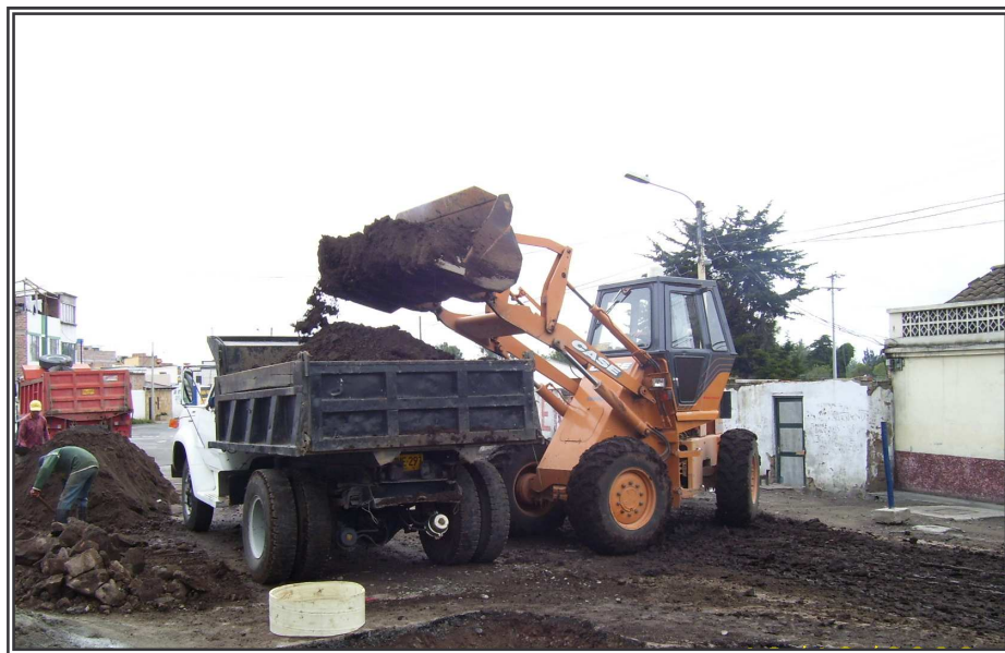
Figura 48. Maquinaria usada en el retiro y desalojo de sobrantes
