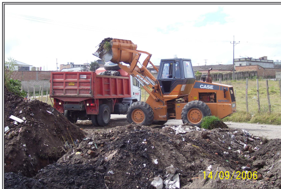
Figura 22. maquinaria usada en el retiro y desalojo de sobrantes
