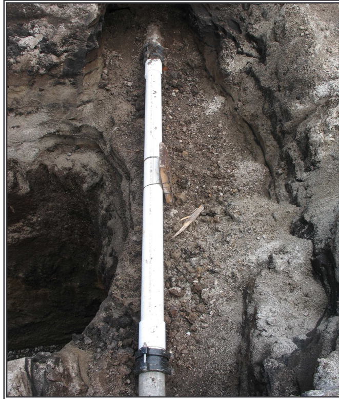
Figura 78. Reparación de la tubería de acueducto
