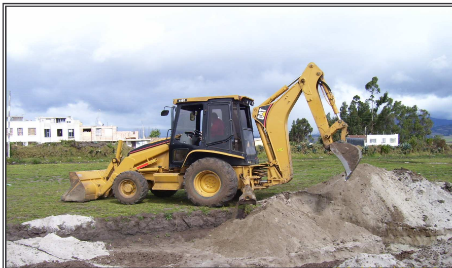
Figura 63. Uso de maquinaria para relleno final
