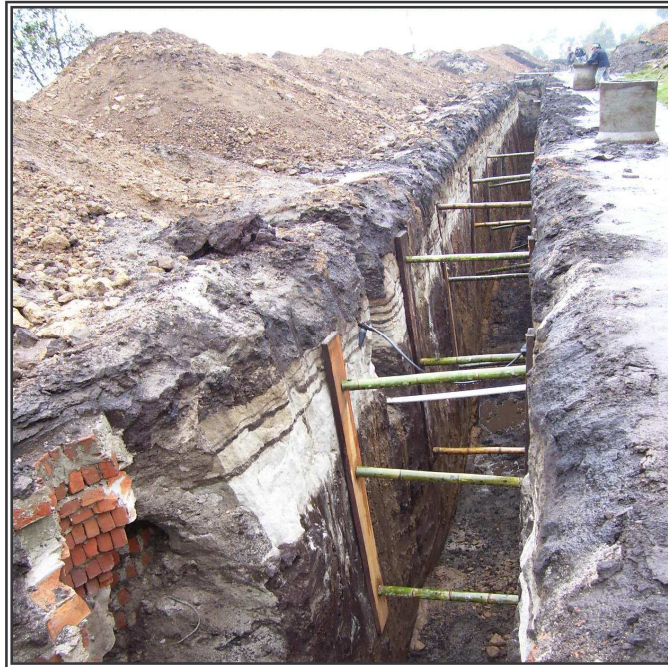
Figura 66. Entibado de chamba
