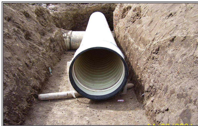
Figura 5. Suelo de cimentación para la tubería de características muy adecuadas
