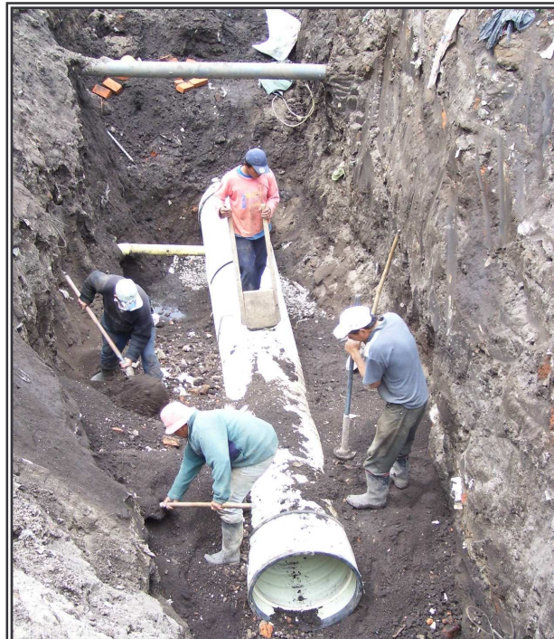
Figura 7. Atraque lateral y compactación
