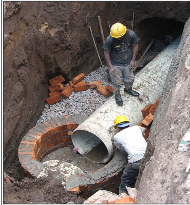
Figura 79. Construcción de cámara de inspección
