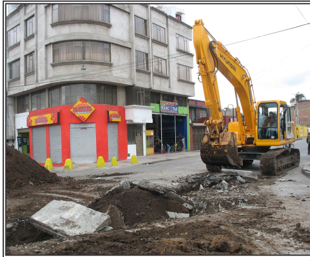
Figura 70. Retiro de cascote con retroexcavadora.
