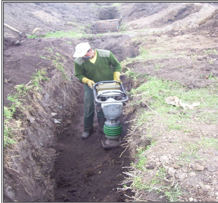
Figura 62. Compactación con apisonador mecánico o saltarín
