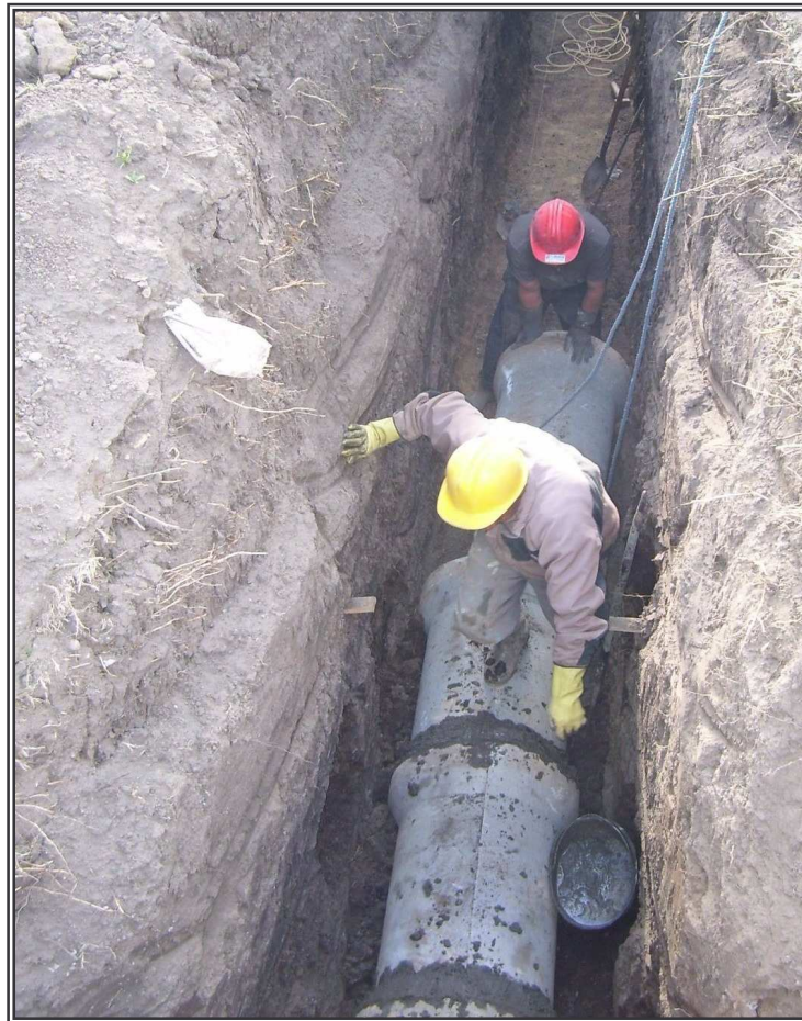
Figura 65. Uso de casco para seguridad del trabajador
