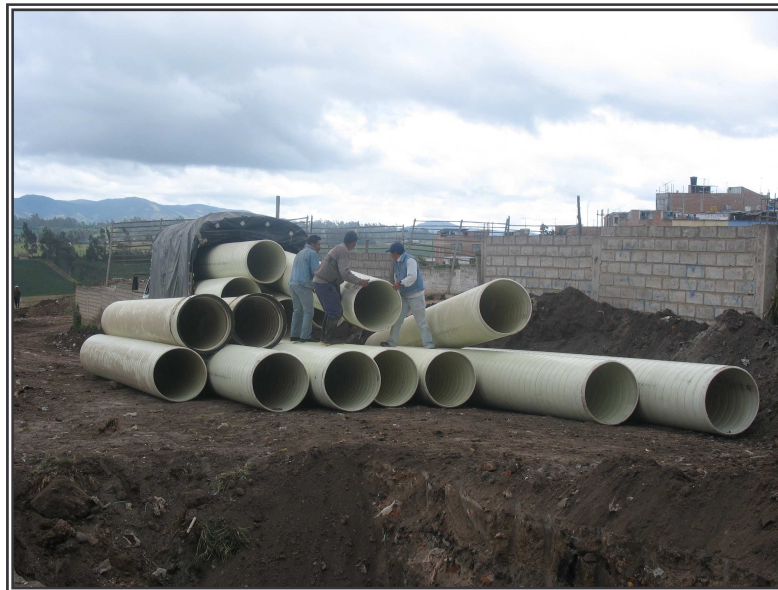
Figura 76. Transporte y manipulación de la tubería NOVALOC de 27 pulgadas de diámetro
