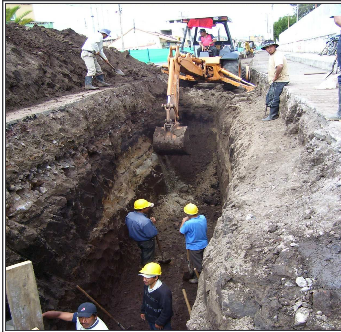
Figura 30. Excavación a máquina (implementación de dos retroexcavadoras tipo pajarita)
