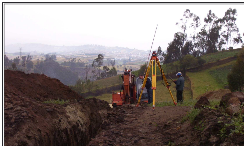
Figura 53. Localización y replanteo.
