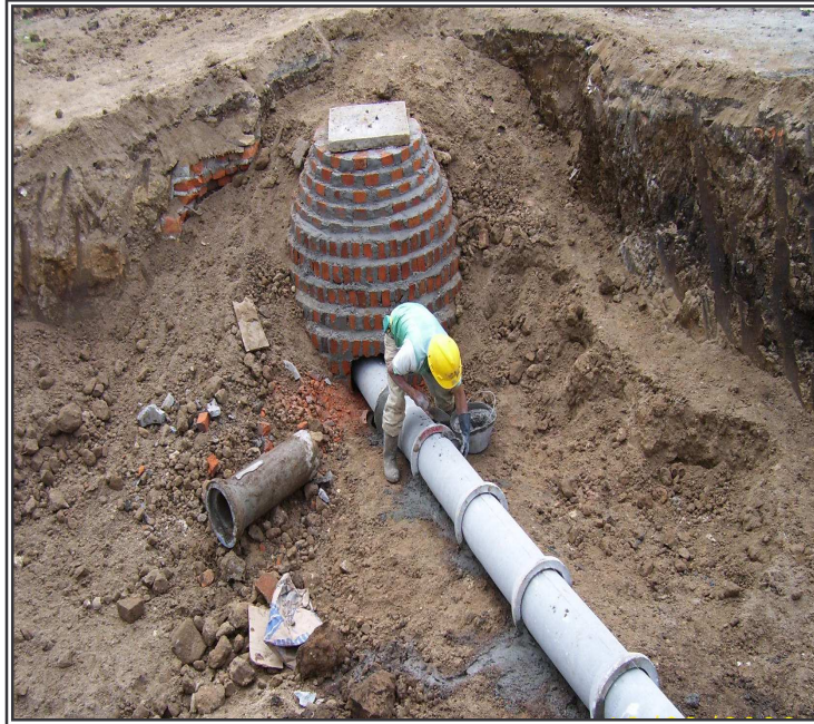
Figura 12. Conexión de redes al colector
