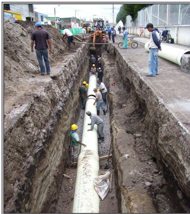
Figura 39. Secuencia de acople de la tubería NOVALOC y NOVAFORT
