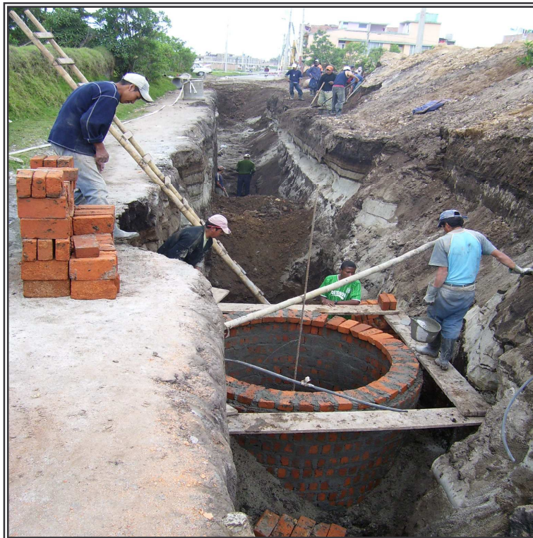
Figura 59. Construcción de cámara de inspección
