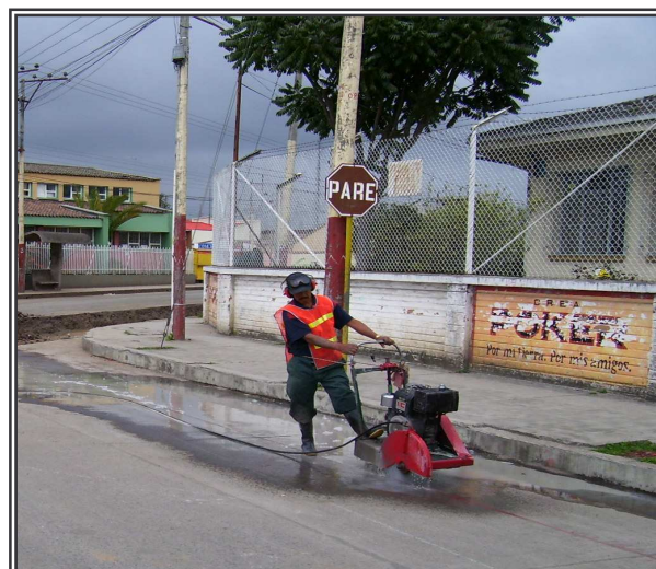
Figura 69. Corte de pavimento hidráulico
