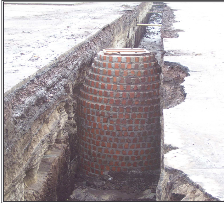
Figura 43. Cámara de inspección terminada
