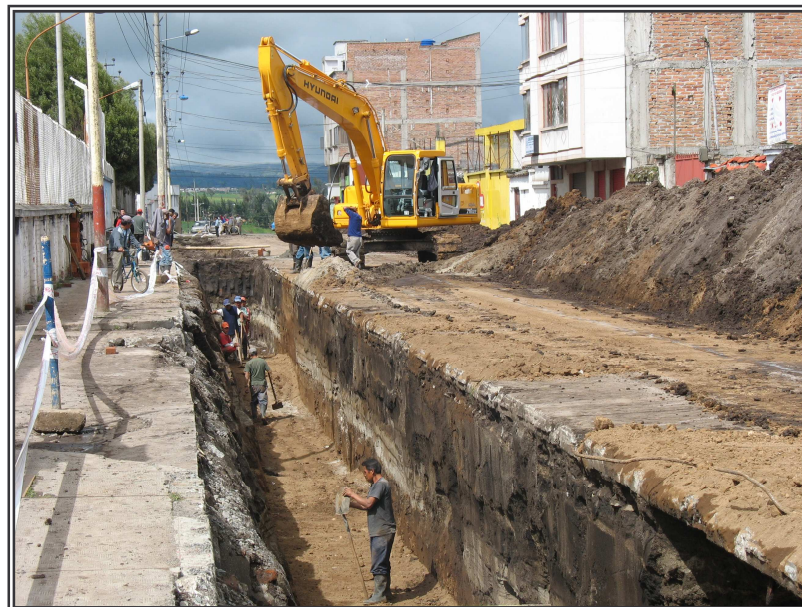
Figura 83. Uso de maquinaria para relleno final de la chamba
