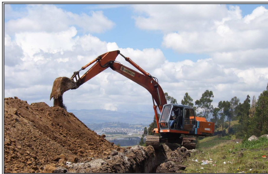
Figura 56. Excavación a máquina (retroexcavadora tipo oruga)
