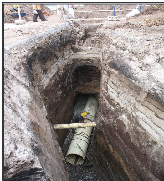
Figura 71. Excavación manual de túneles para paso de la tubería
