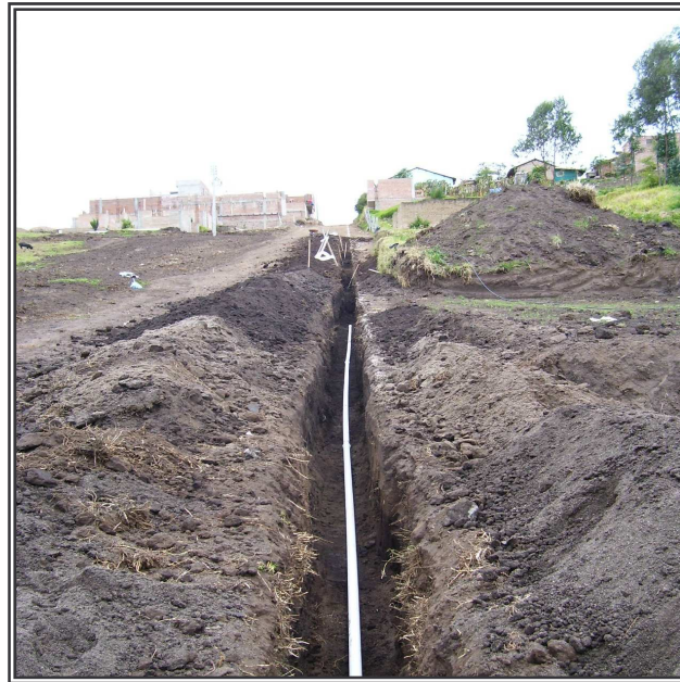
Figura 15. Instalación de tubería de acueducto.
