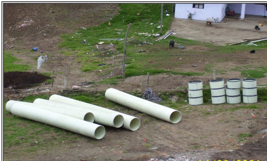
Figura 8. Tubería NOVALOC de diámetro 27 pulgadas y uniones para la misma
