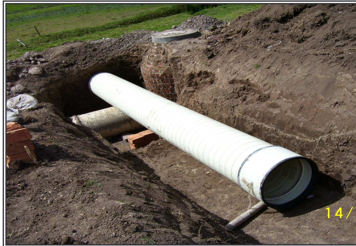
Figura 9. Tubería y unión NOVALOC debidamente ensamblada
