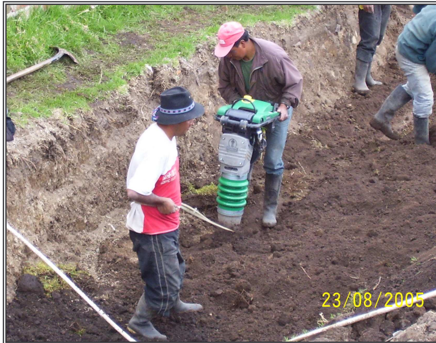
Figura 20. Compactación con apisonador mecánico o saltarín
