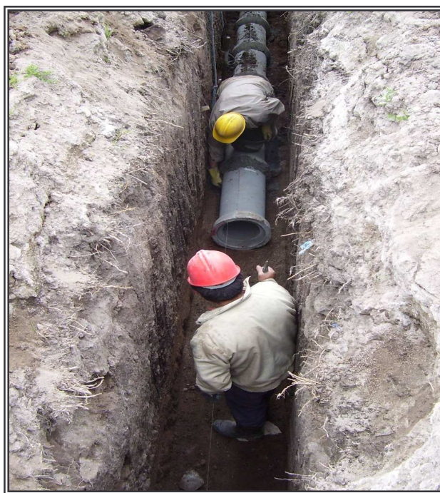
Figura 57. Instalación de tubería de cemento de 10 pulgadas de diámetro
