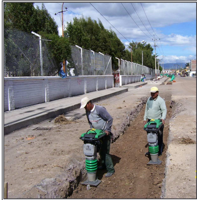
Figura 47. Compactación final con vibro compactador de rodillo
