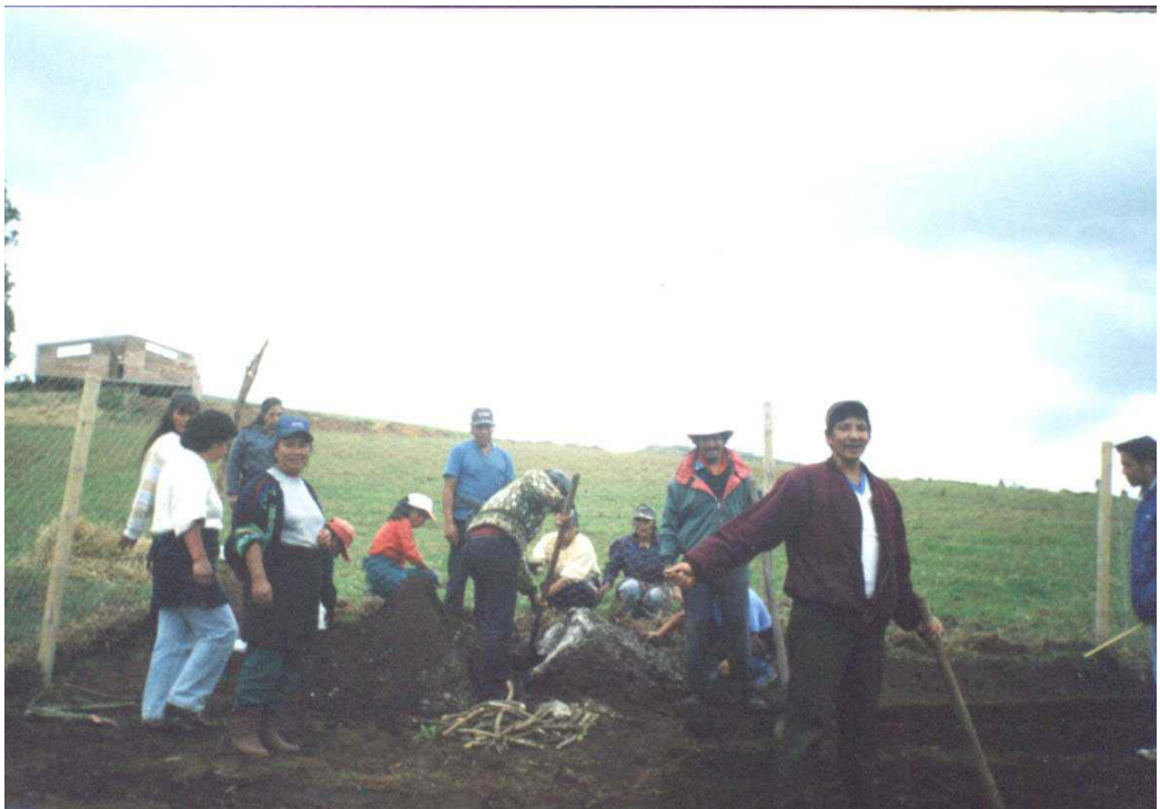
Figura 13. Construcción de viveros.
