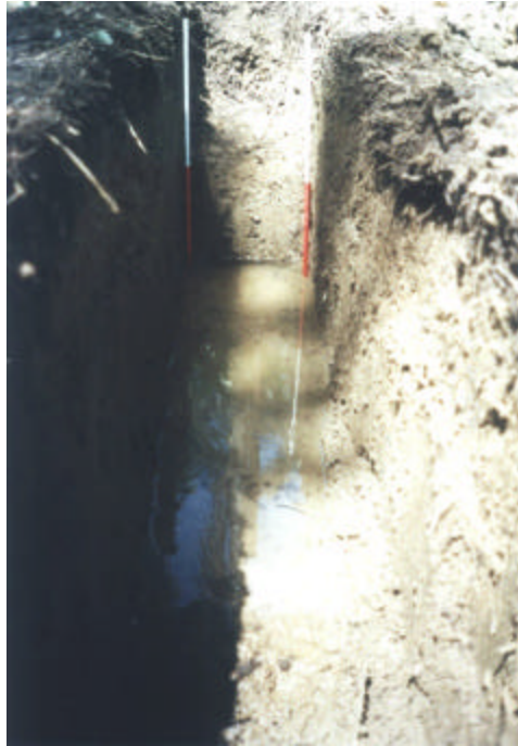
Figura 15. Presencia del nivel freático alto.
