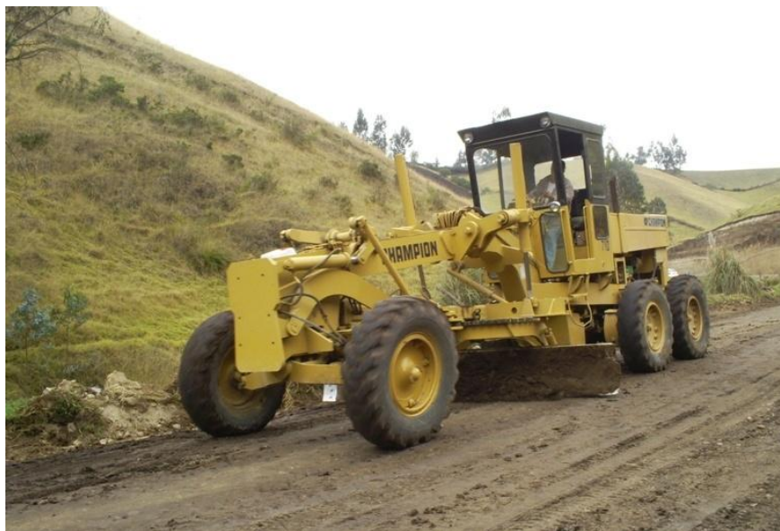
Figura 68. Conformación calzada existente
