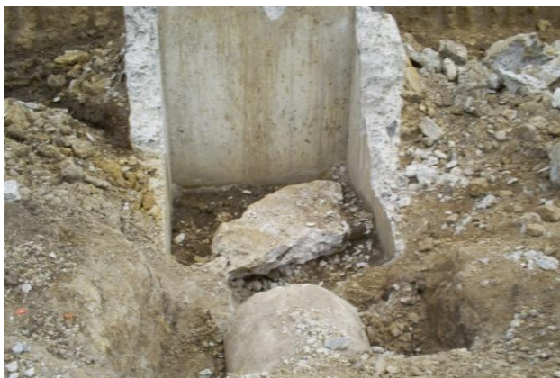
Figura 40. Demolición manual de los cabezotes de alcantarilla
