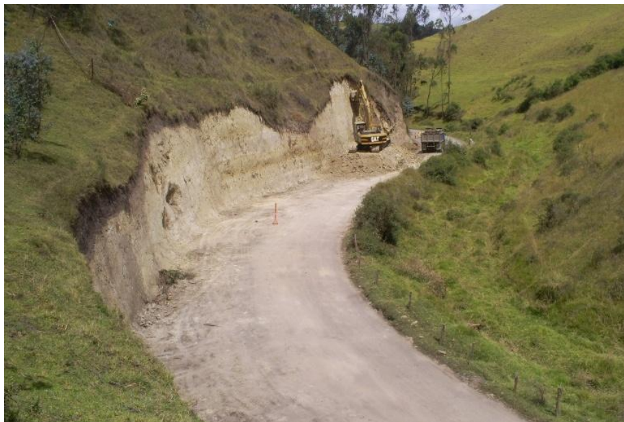
Figura 14. Excavación de la explanación abscisa K0+720 a K0+800
