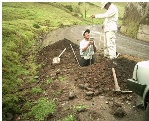
Figura 2. Apique N° 1 - K0+340.73 Lado derecho
