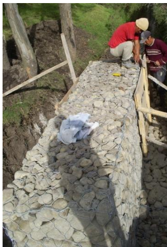
Figura 35. Costura del gavión y retiro de formaleta
