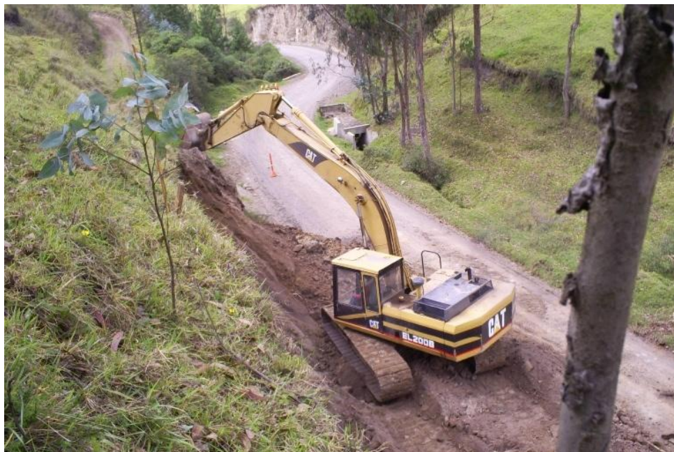
Figura 15. Excavación de la explanación abscisa K0+800 a K0+900
