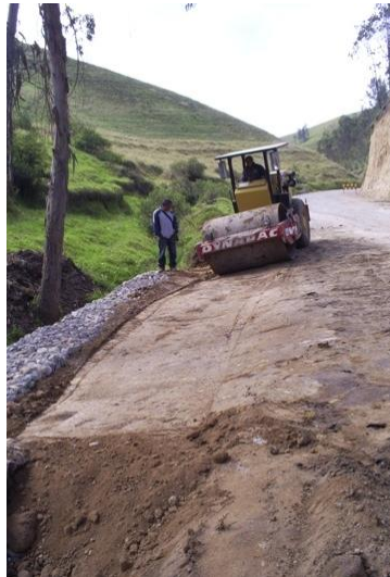
Figura 39. Compactación con vibrocompactador
