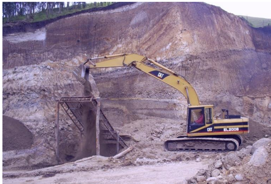
Figura 74. Selección material de subbase y base
