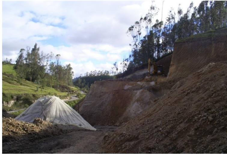
Figura 73. Acopio material explotado
