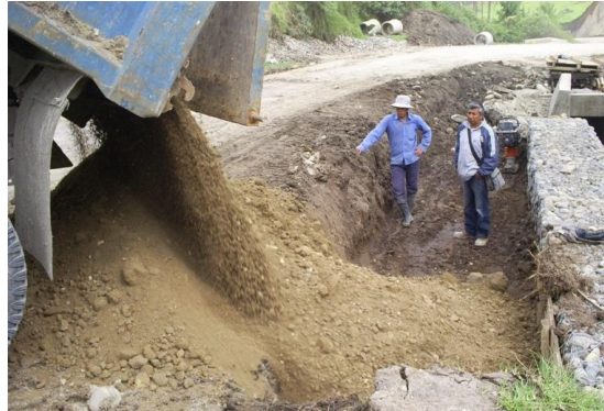
Figura 37. Relleno de material seleccionado entre gavión y vía
