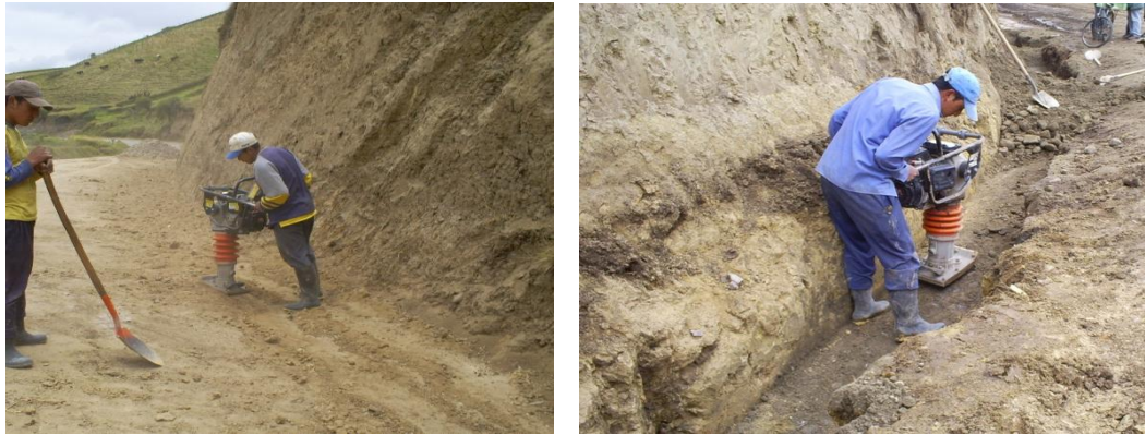
Figura 28. Compactación del filtro
