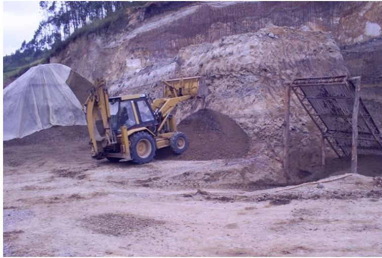
Figura 76. Mezclado para base en cantera
