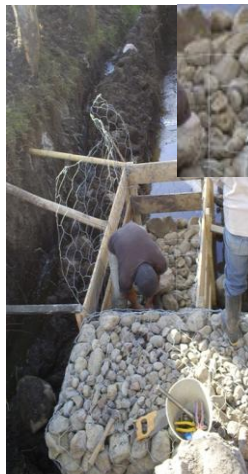
Figura 34. Colocación del material de relleno y tensores
