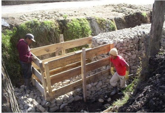
Figura 33. Instalación de las canastas del gavión
