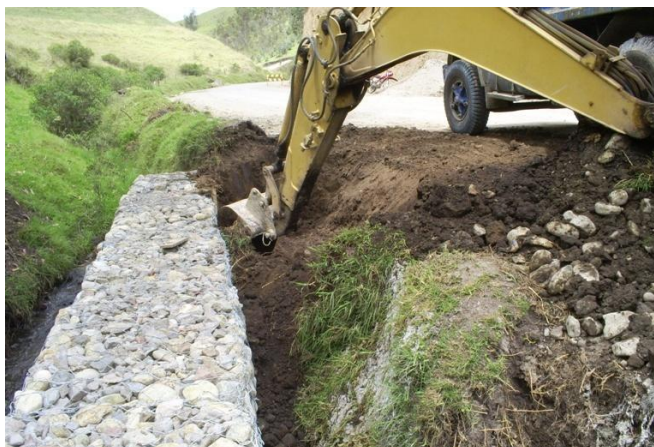
Figura 36. Retiro de material entre gavión y vía
