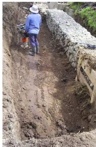
Figura 38. Compactación de material con saltarín
