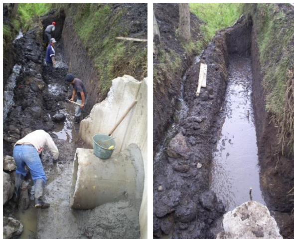
Figura 30. Excavación a mano
