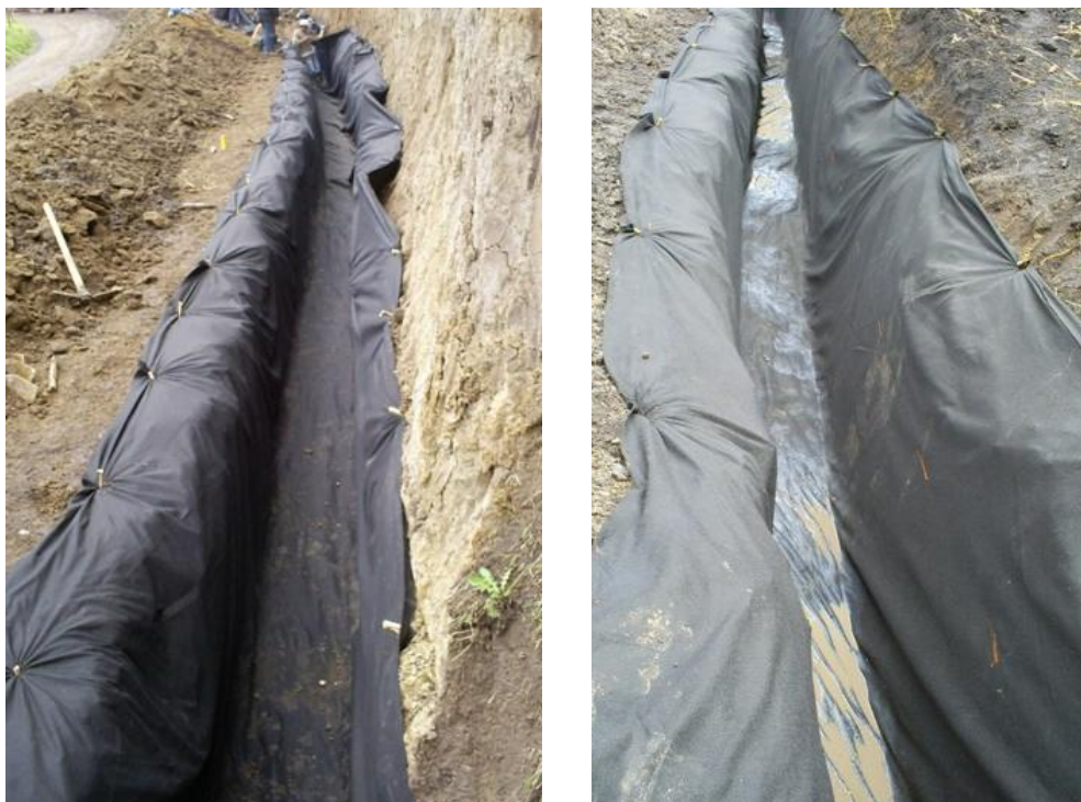
Figura 22. Colocación de geotextil
