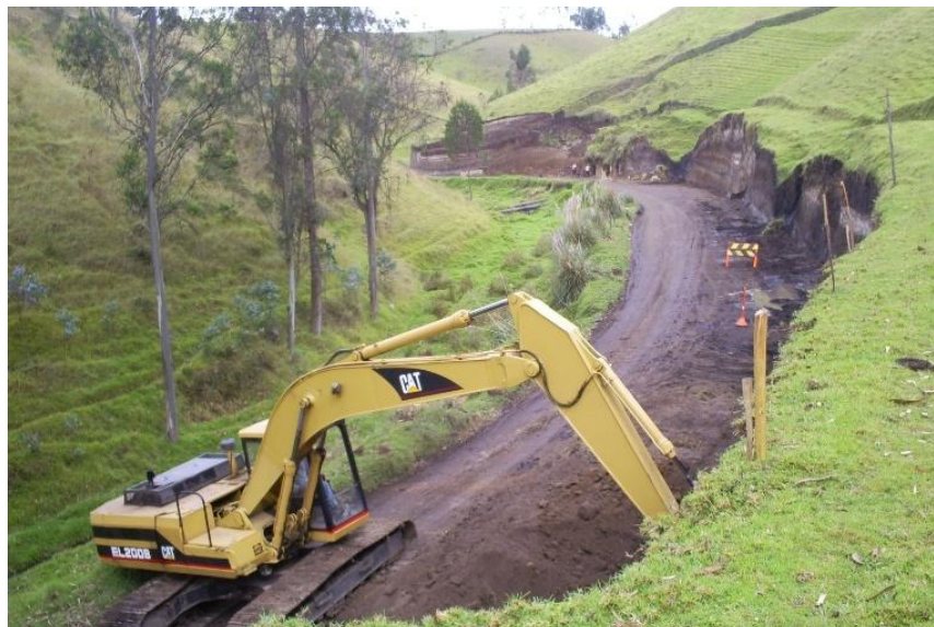
Figura 12. Excavación de la explanación abscisa K0+330 a K0+450
