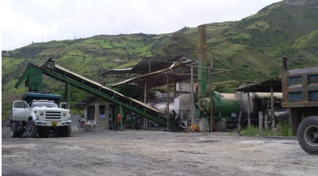
Figura 93. Planta de asfalto Pilcuan
