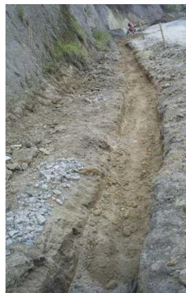
Figura 27. Cobertura del filtro con material seleccionado
