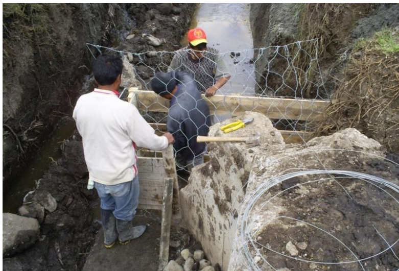
Figura 31. Preparación de la malla
