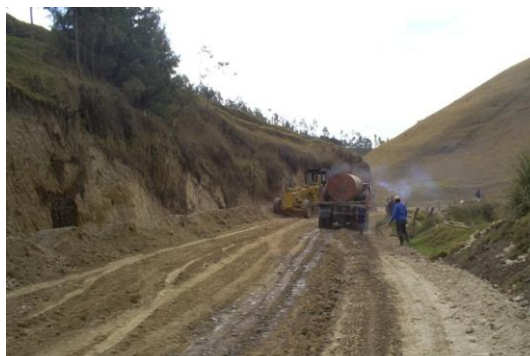
Figura 80. Distribución y humedecimiento del material subbase
