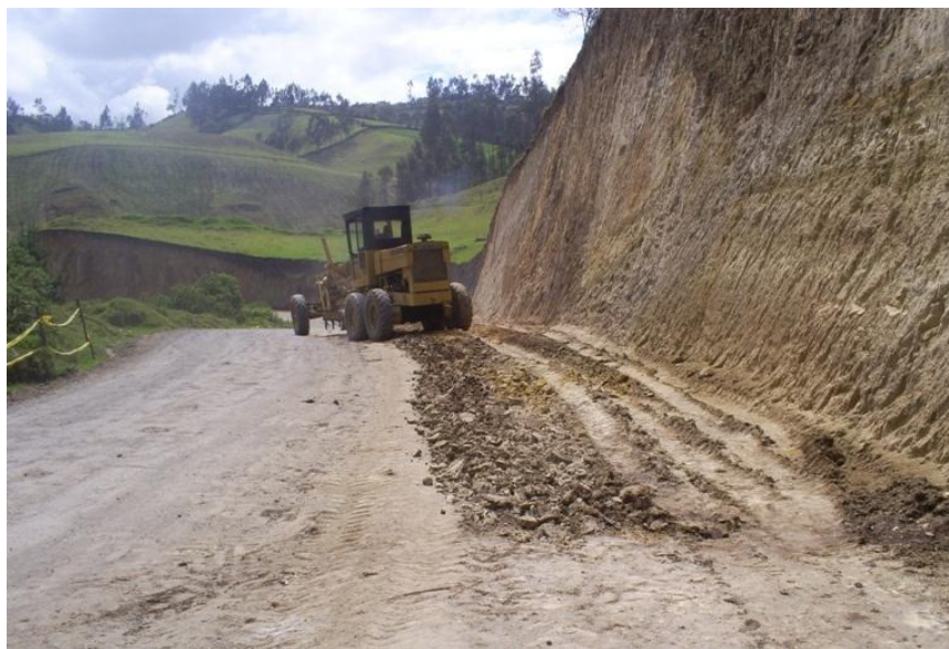
Figura 67. Escarificación calzada existente
