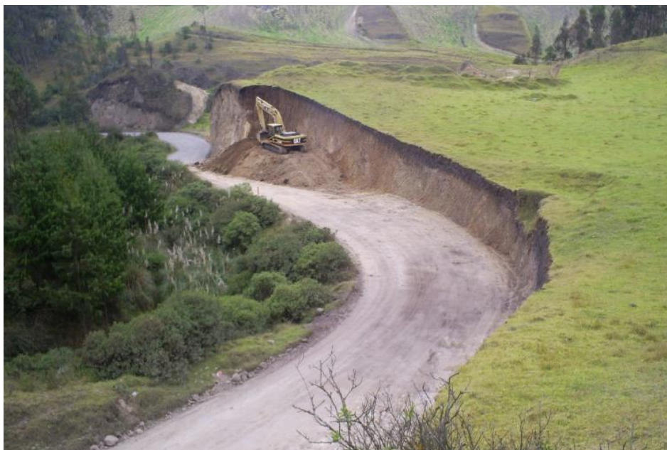
Figura 16. Excavación de la explanación abscisa K0+925 a K1+080
