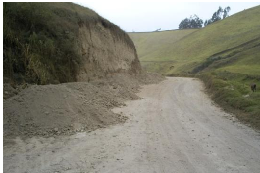
Figura 79. Acordonamiento material subbase
