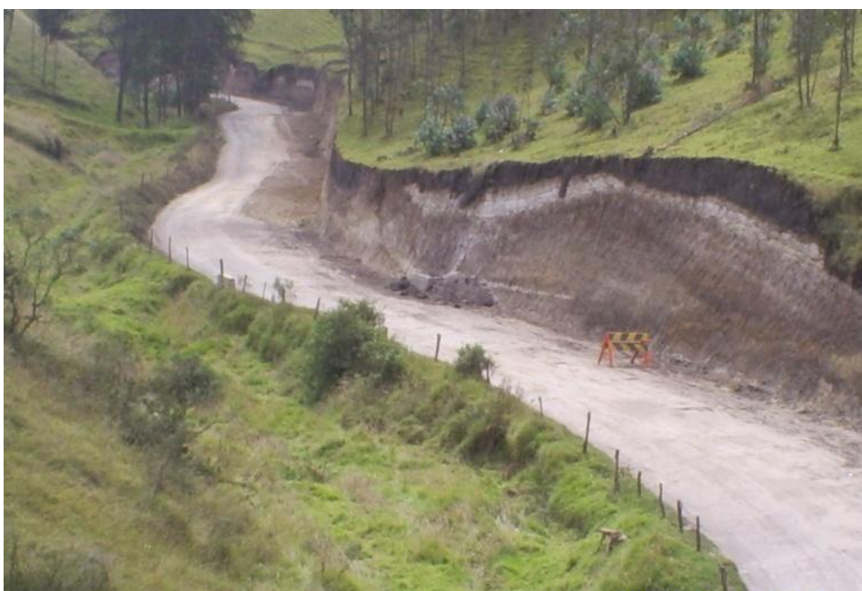
Figura 13. Excavación de la explanación abscisa K0+450 a K0+720
