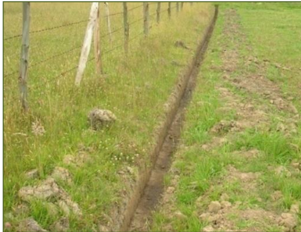
Figura 16. Zanjas para la infiltración de agua.
