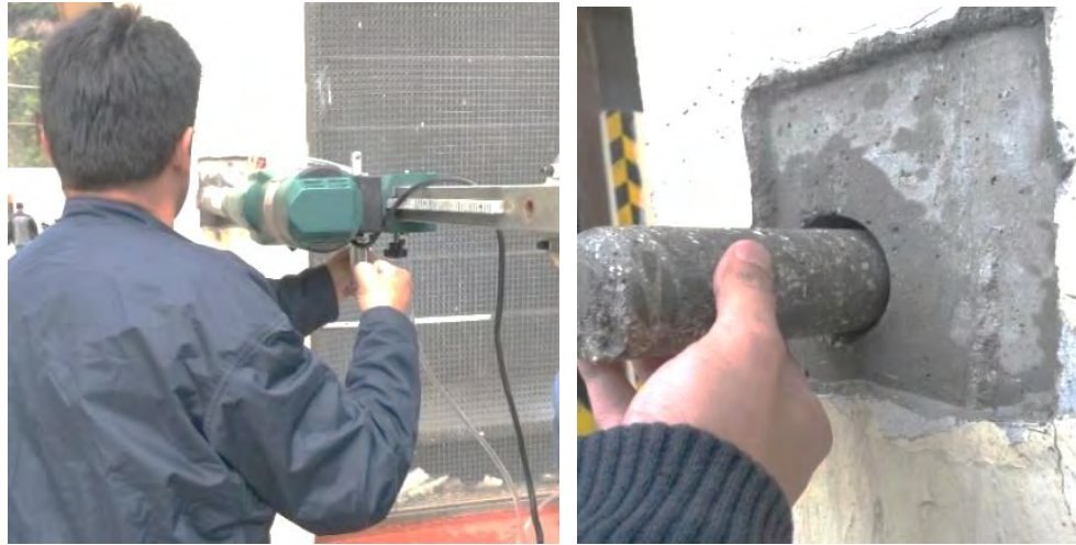
Figura 6. Extracción de núcleo en la columna de ejes A-1
