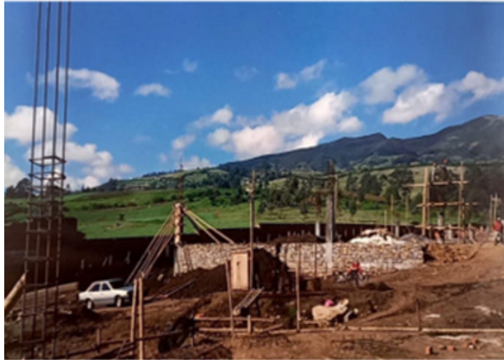
Figura 130. Proceso Constructivo Nuevas Oficinas Puyo S.A.
