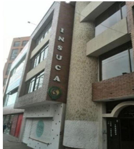
Figura 172. Entrada Instituto INSUCA
