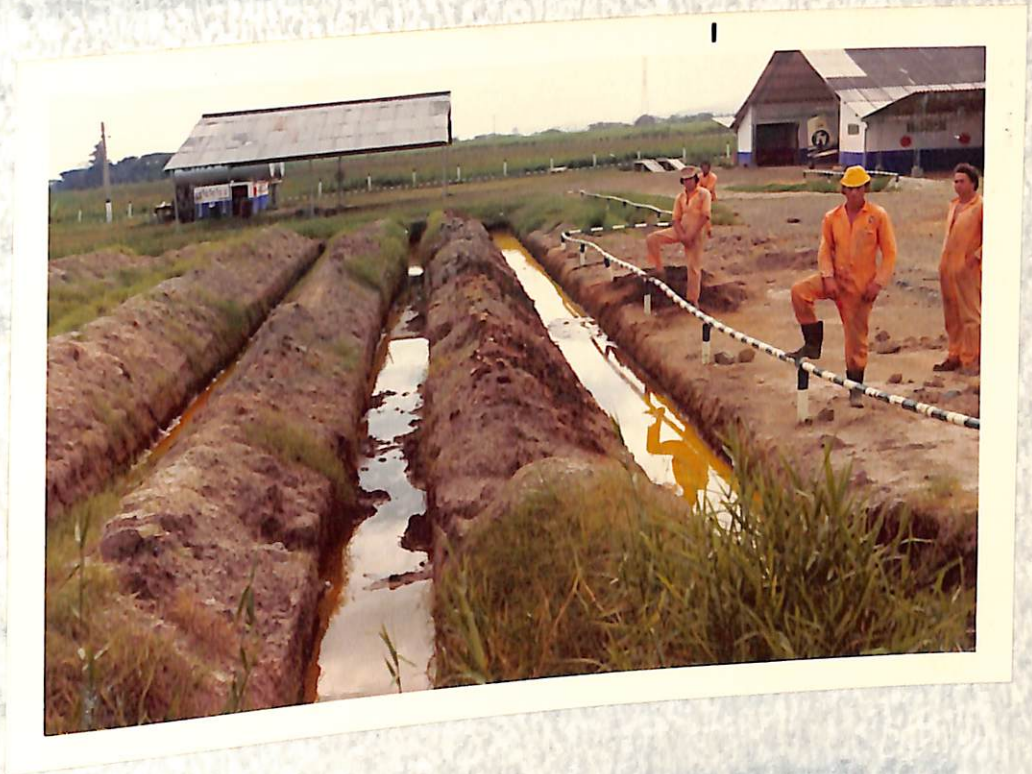
Figura 8. Zanjas paralelas y comunicadas entre sí, utilizadas en las pistas de aprovisionamiento para eliminar desperdicios de pesticidas.
