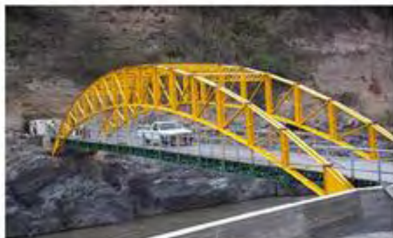
Estructuras metálicas en Pasto, Colombia
