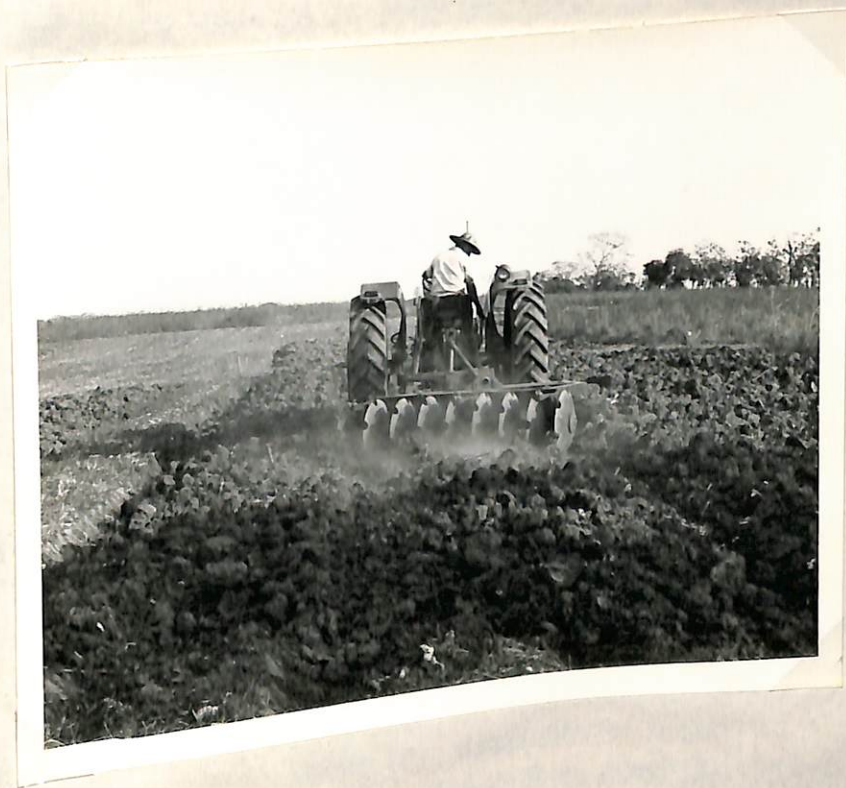
Figura 4. En esta labor se utilizó rastrillo de disco hidráulico de 16 discos de 24 pulgadas.
