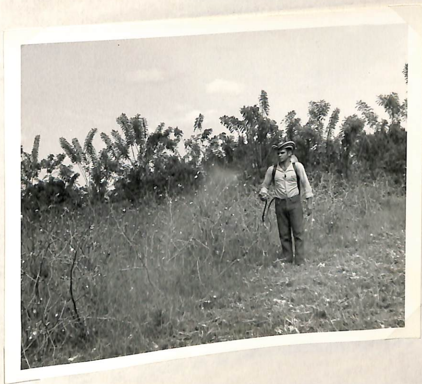
Figura 7. Aplicación de herbicida sobre seca en pia con bomba de espalda Kallmax de 10 Kgrs. por \text{cm}^2 de presión. Foto: Pedro Vergara
