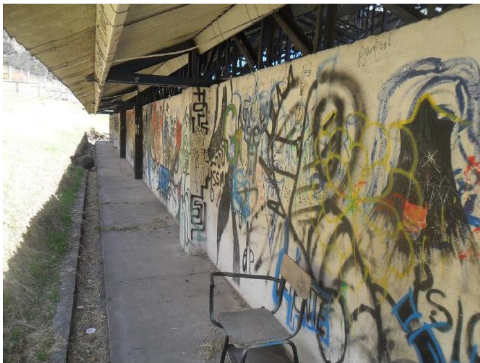
Figura 27. Vista exterior zona posterior del Coliseo Adriana Benítez Fuente: Elaboración propia
