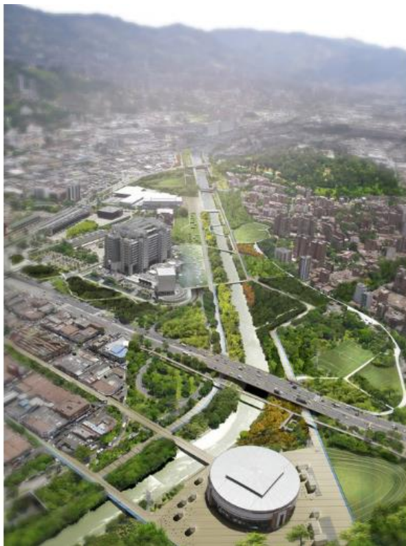
Figura 9. Vista aérea Río Medellín Fuente: Tomado de https://www.archdaily.co/co
