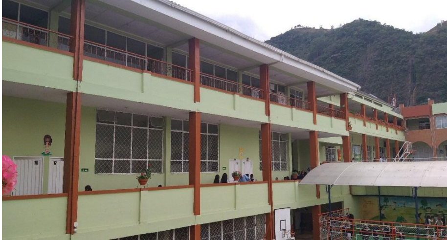
Imagen 5. Seguridad en los muros de la institución
