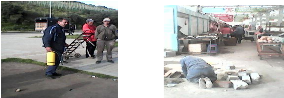
Figura 19. Adecuación de Extintores y Adecuación de cañerías Zonas de carnes
