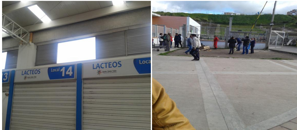
Figura 18. Adecuación de ventilación y Trabajo de prueba de Extintores
