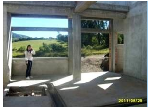
Área de despacho
