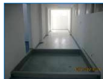
Pasillo 1er piso
