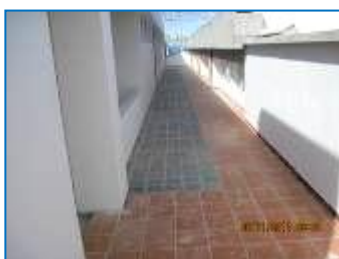
Pasillo 2do piso
