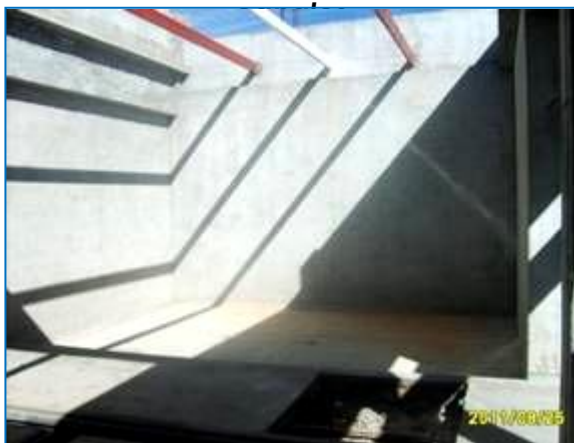
Cuarto de golpe de frío y de sostenimiento
