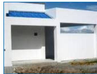
Área de lavado y almacenamiento de canastillas
