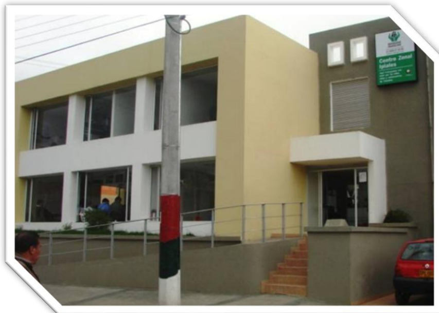
Figura 1. Instalaciones ICBF Centro Zonal Ipiales
