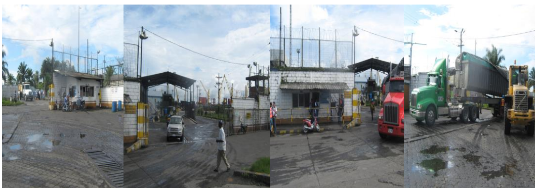
Imagen 23. Vista frontal y trasera de la entrada a muelle 13 GP Buenaventura
