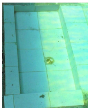
Figura 184. Poseta de desinfección
