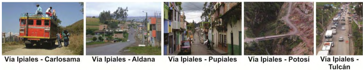
FIGURA 9. Fotografías del estado actual de algunas de las principales vías
