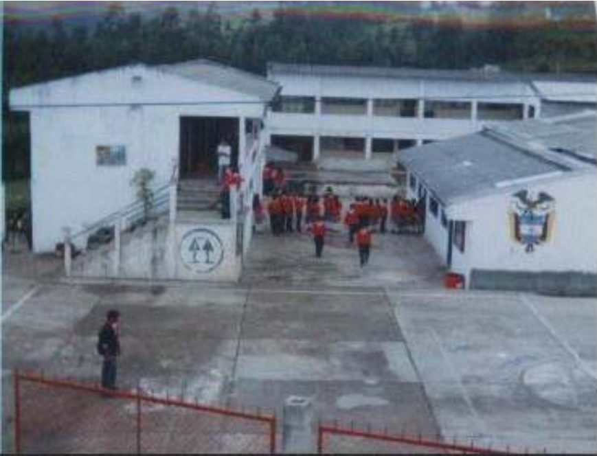
Anexo F. Foto infraestructura de la institución.
