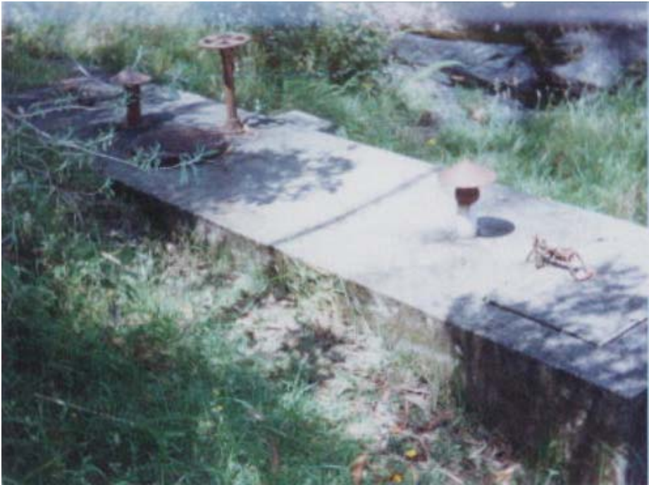
Foto 5. Tanque del acueducto
