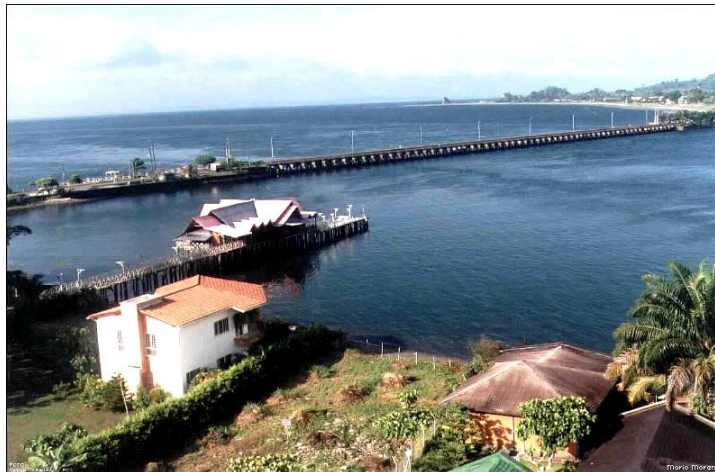
Figura 2. Puente del morro municipio de Tumaco.
