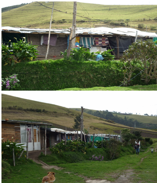
FOTO 6: Fachada de Vivienda, se observa la precaria infraestructura
