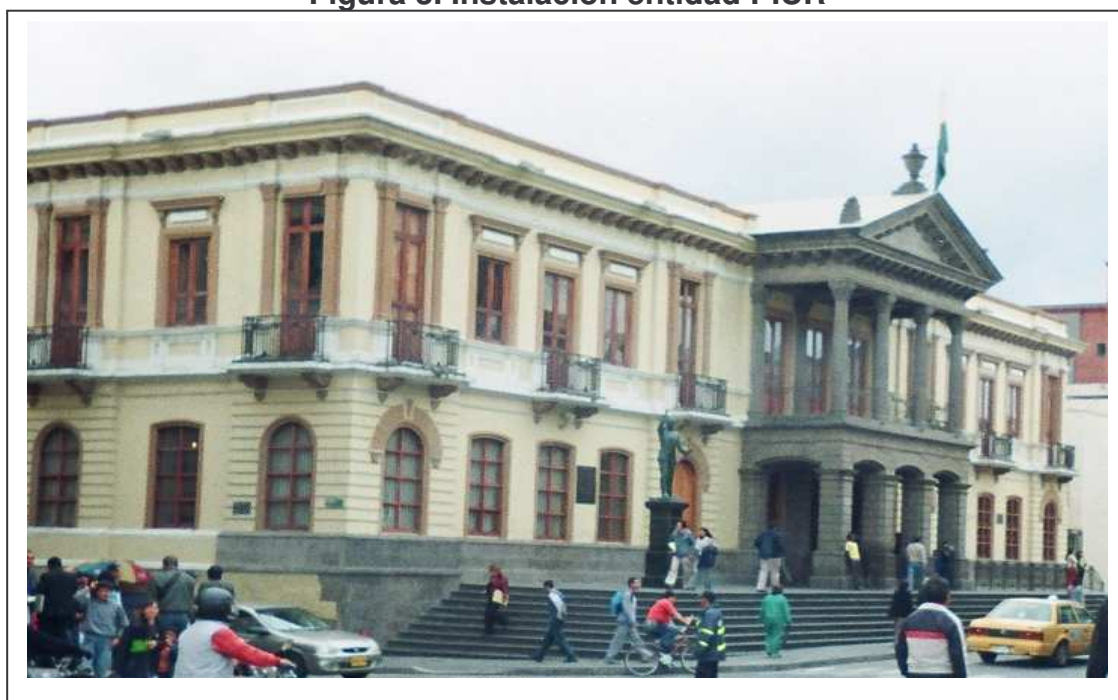
Figura 3. Instalación entidad PIUR
