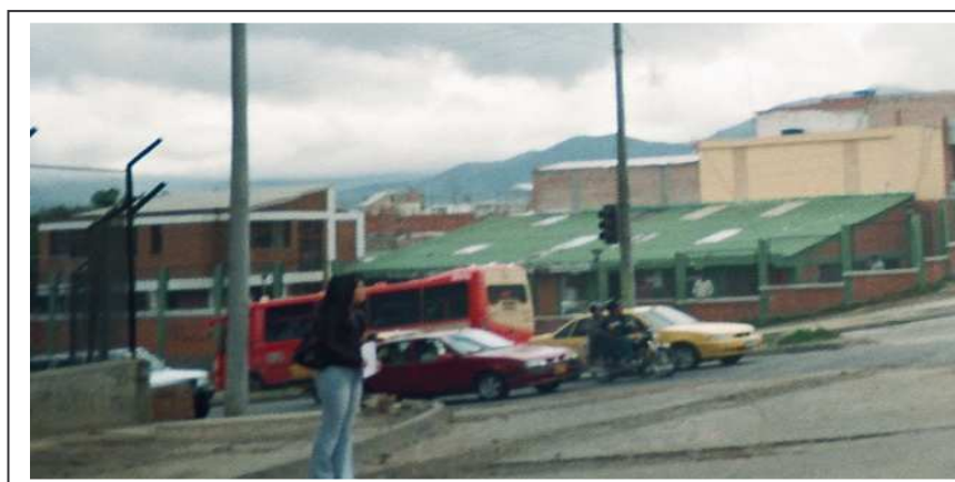
Figura 2. Instalación entidad UAO
