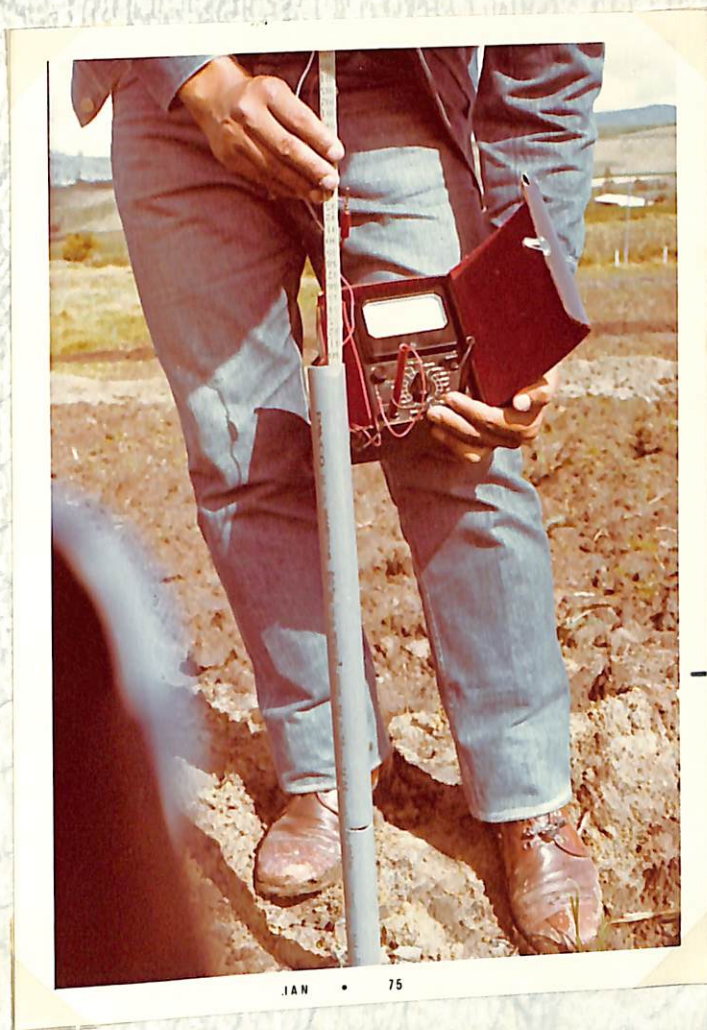
FIGURA 4. Lectura en los pozos de observación
