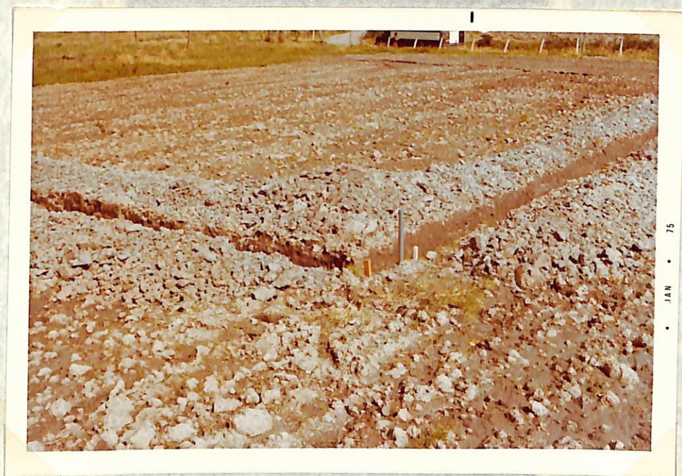
FIGURA 38. Excavación de un dren colector
