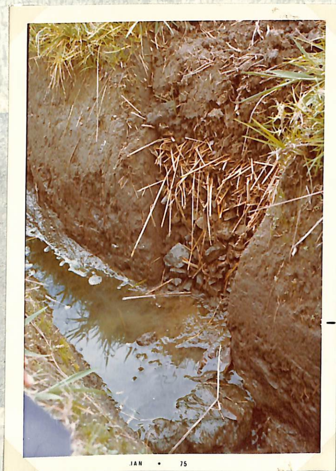
FIGURA 39. Colocación del material filtrante, la paja y la tierra en un dren cerrado
