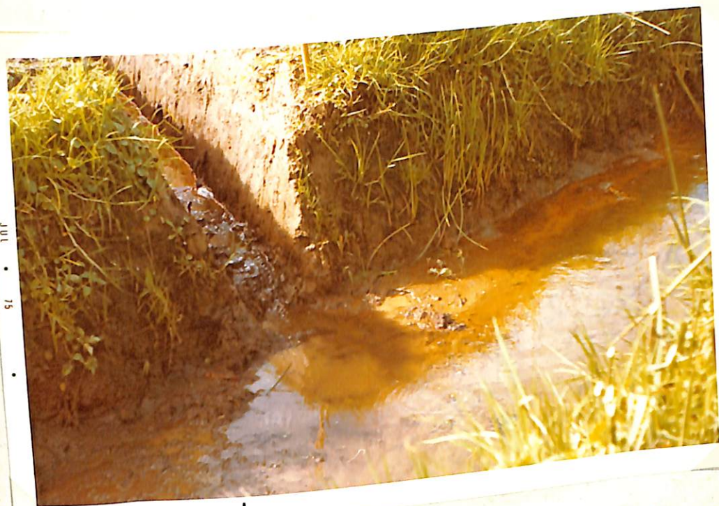
Figura 20. Obsérvese la diferencia de nivel entre el dren y el canal de descarga
