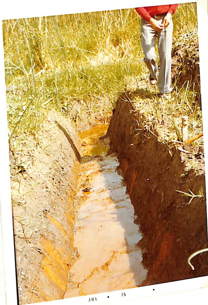
Figura 19. Descarga del dren en el canal colector. Obsérvese la posición del nivel freático en el talud.
