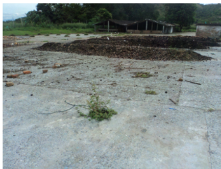
Figura 2 Área en concreto donde se depositan los residuos sólidos.
