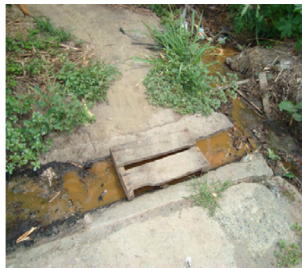
Figura 23. Lixiviado con destino quebrada
