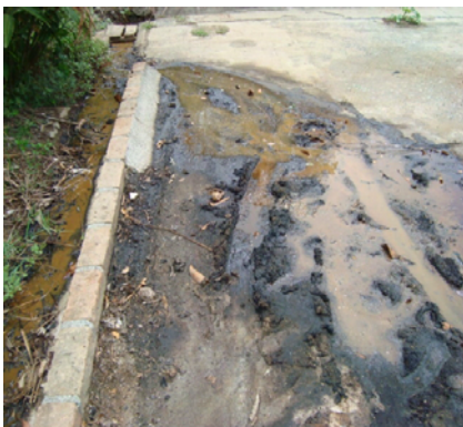
Figura 22. Afluente de lixiviado. quebrada
