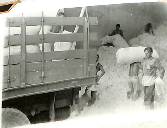
Figura 76 El algodón semilla es bajado y vaciado en las bodegas donde llegan los tubos de succión de la desmotadora.
