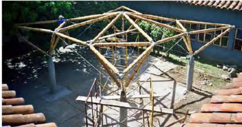
Figura 105 – Proceso constructivo de la estructura
