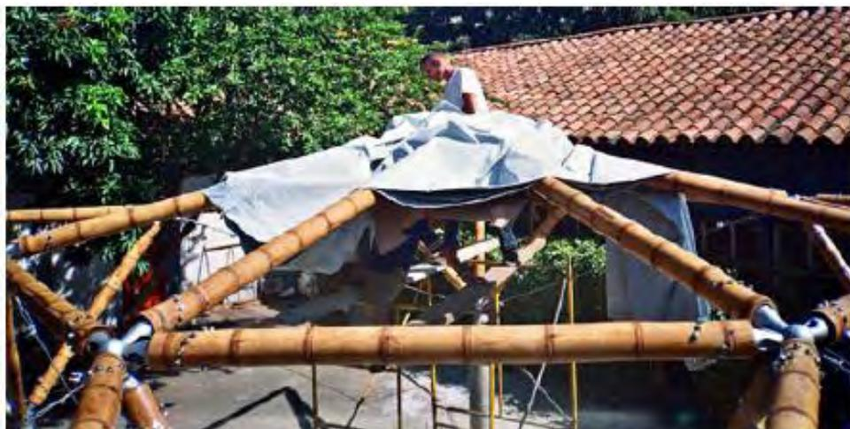
Figura 107 – Proceso constructivo para las lonas
