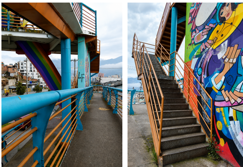
Figura 4 Puente del Arcoíris. Ingreso por rampa y escaleras.
