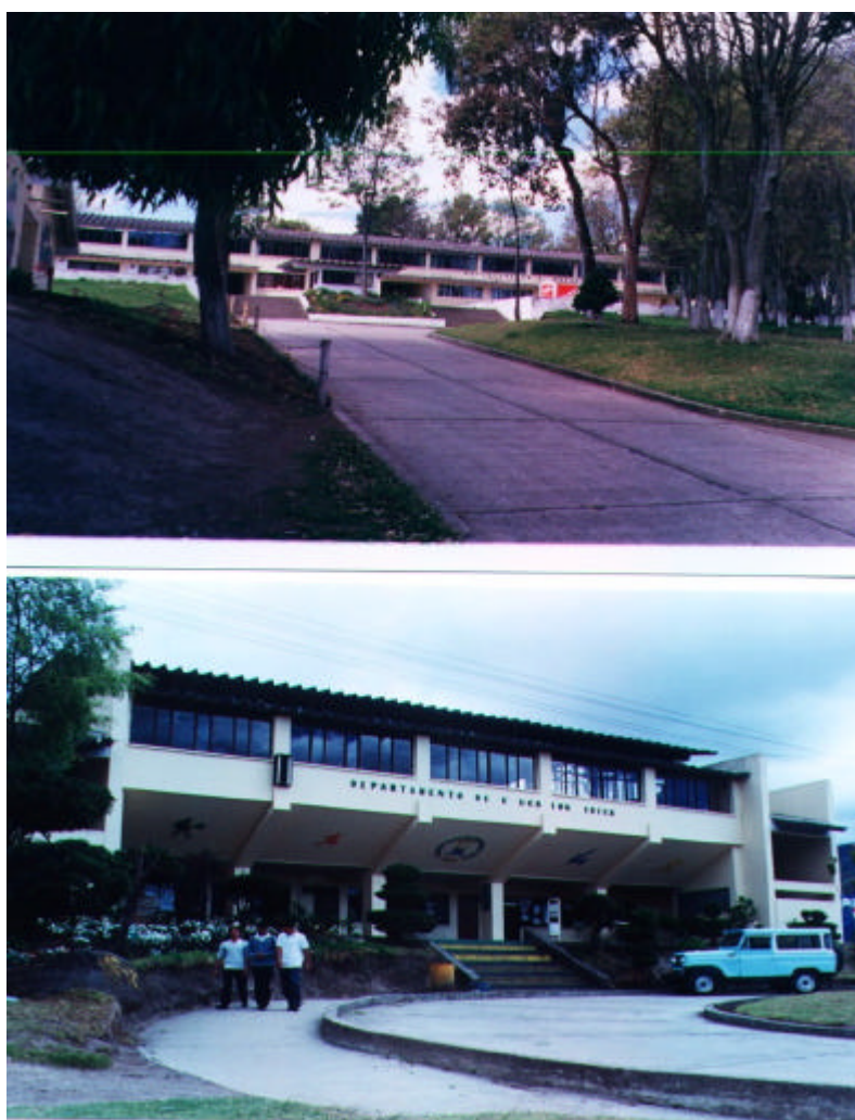
Figura 23. Espacios físicos del INEM
