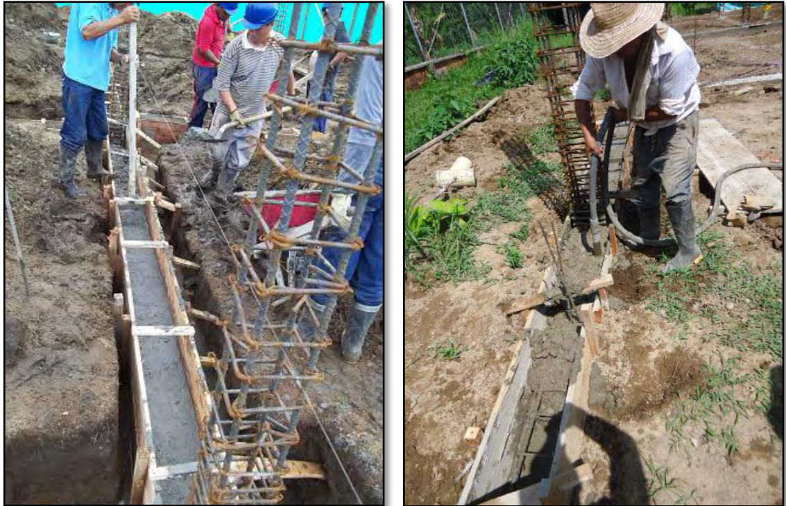
Figura 13. Construcción de vigas de cimentación
