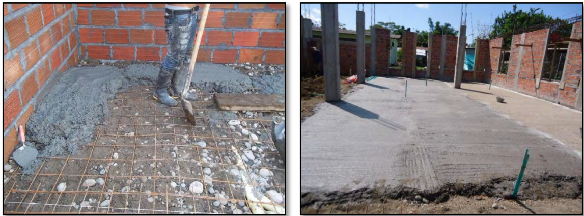
Figura 22. Construcción losa de piso
