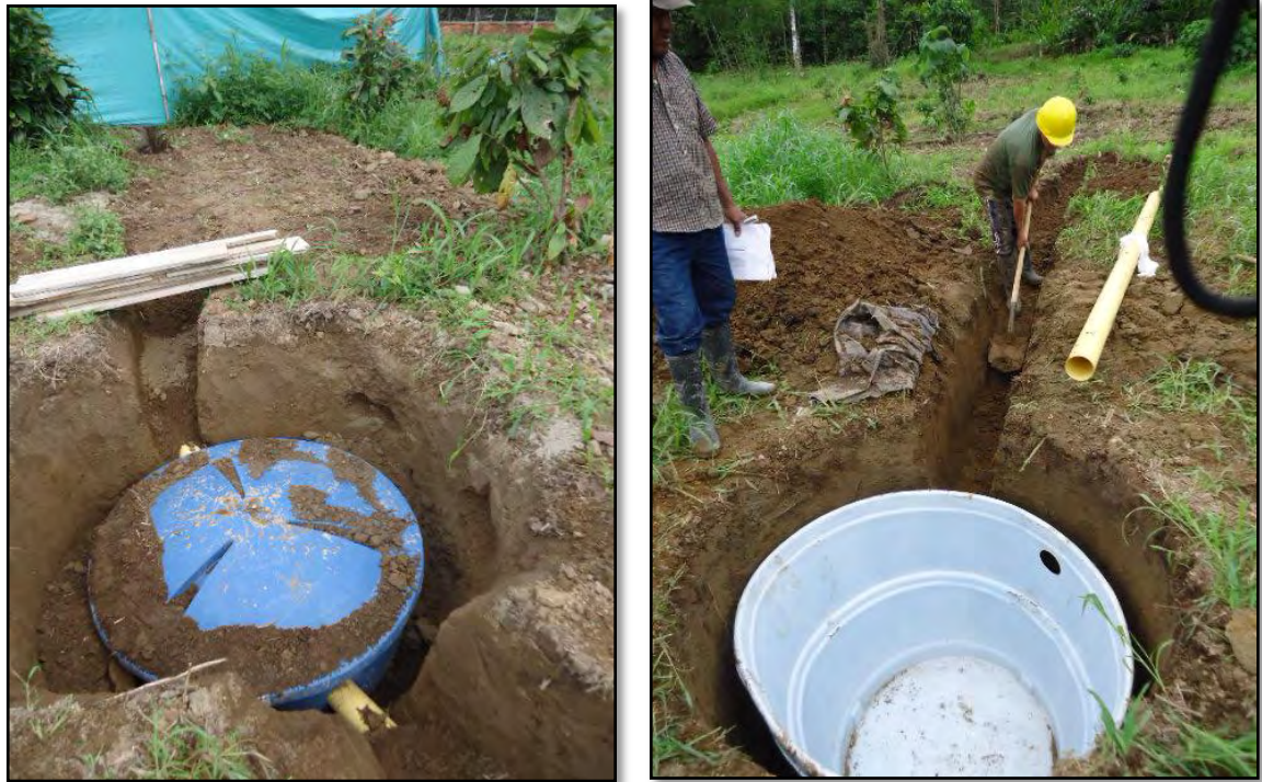
Figura 20. Construcción sistema de tratamiento de aguas servidas
