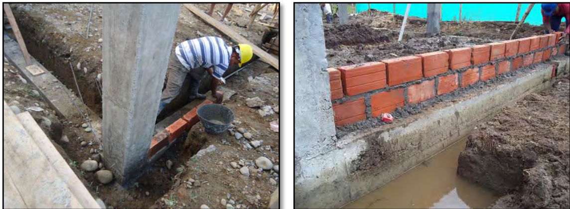
Figura 15. Construcción de sobre cimiento
