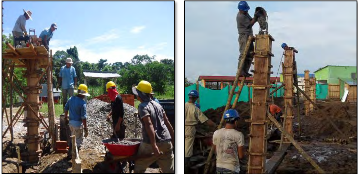
Figura 14. Construcción de columnas
