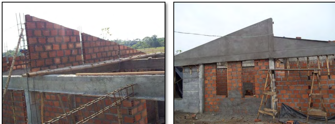
Figura 27. Construcción de tímpanos
