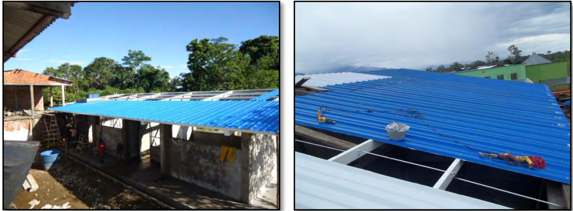
Figura 29. Instalación de cubierta
