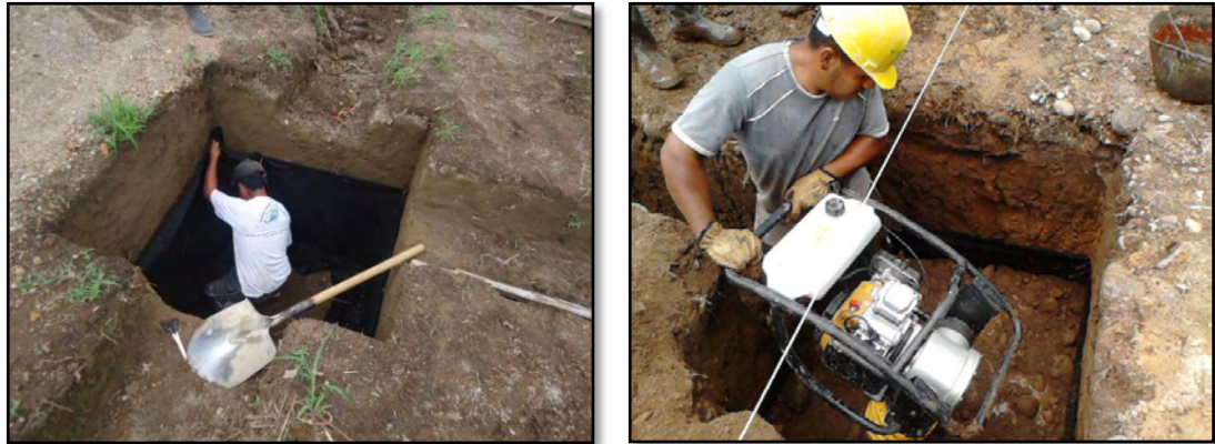
Figura 11. Mejoramiento de suelo
