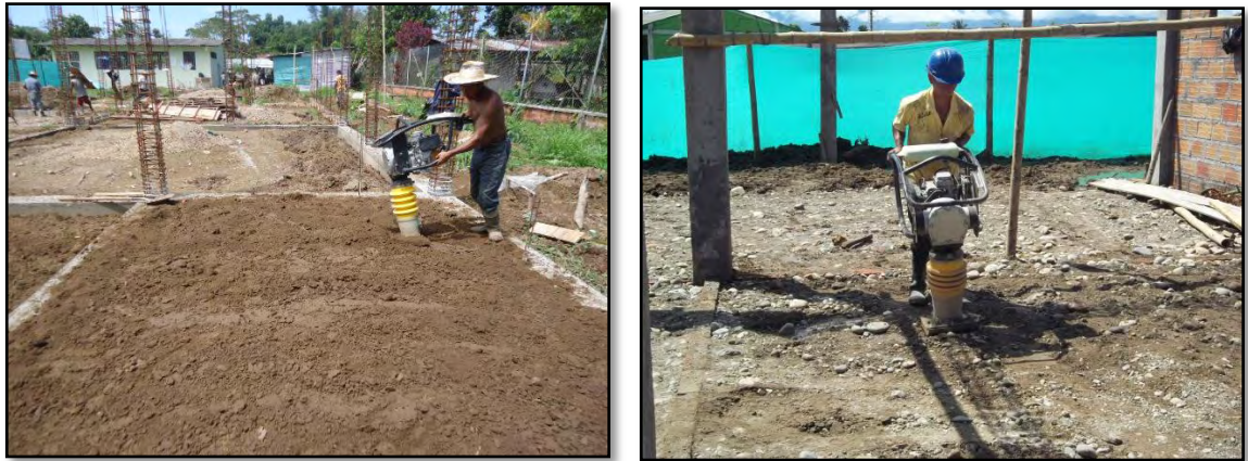
Figura 16. Relleno en recebo compactado
