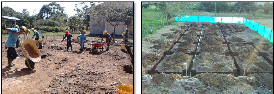
Figura 8. Excavaciones para cimentación
