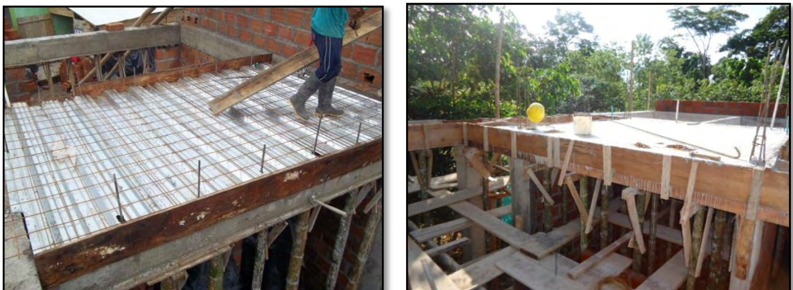
Figura 25. Construcción losa de tanques
