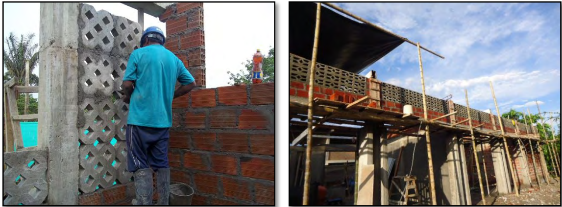
Figura 26. Instalación de calados de concreto
