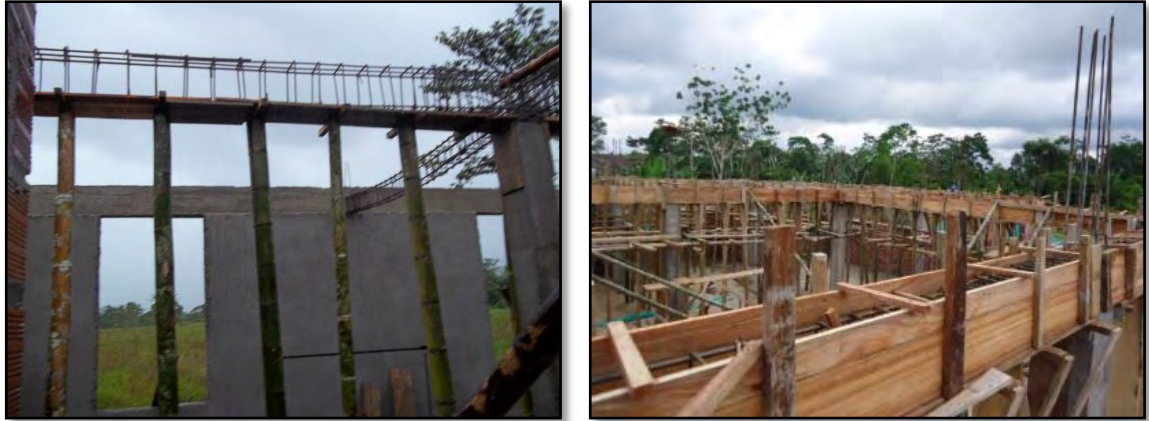
Figura 23. Construcción de vigas aéreas
