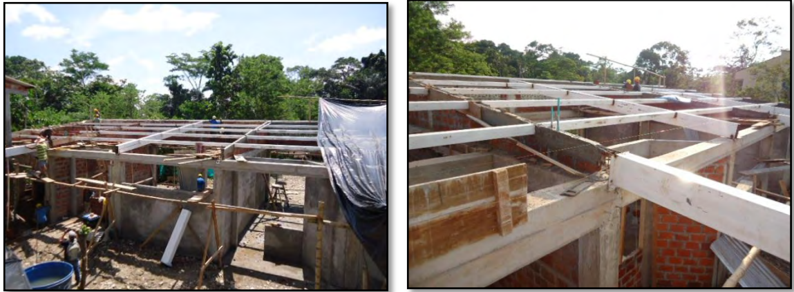
Figura 28. Instalación de estructura metálica de cubierta
