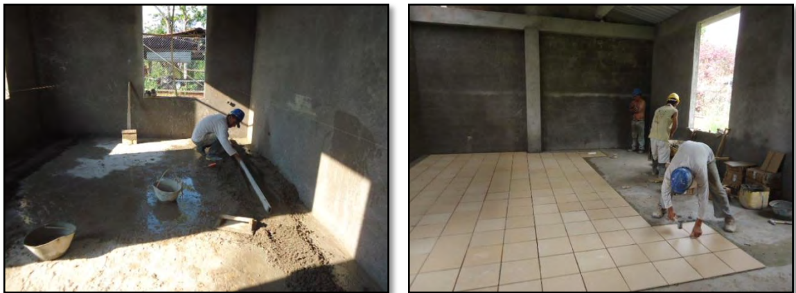
Figura 32. Instalación de pisos
