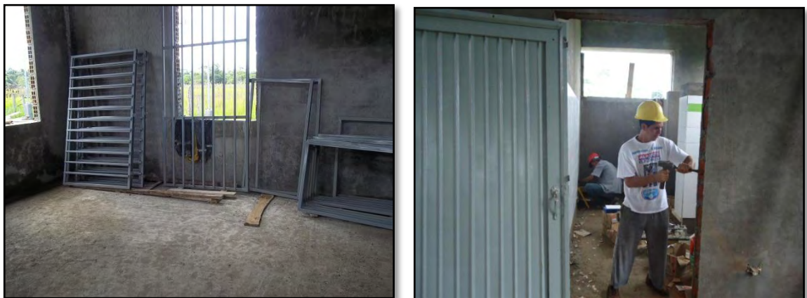
Figura 30. Instalación de puertas y ventanas
