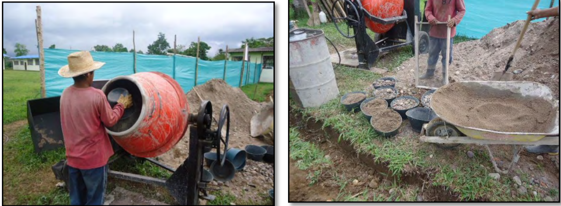
Figura 10. Elaboración de concreto
