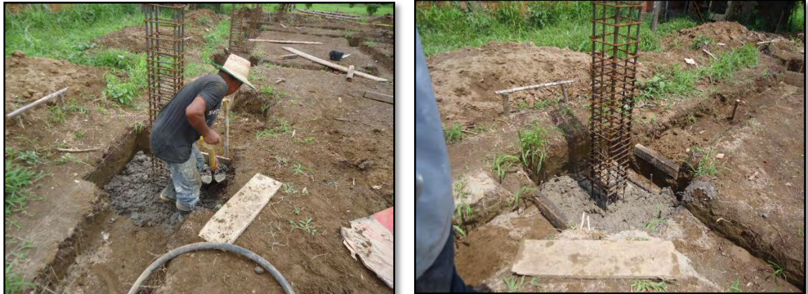
Figura 12. Construcción de zapatas
