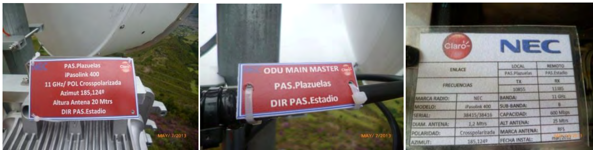
Figura 16 Fotografía 8. Marquillas instaladas
