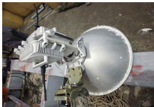
Figura10. Antena de 0.6 con ODUS e HIBRIDO. Fuente: propia de este trabajo
