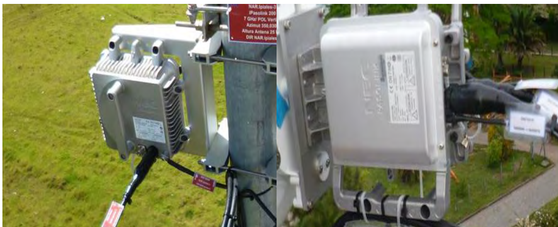
Figura4. ODU IPASOLINK, derecha frecuencias mayores a 11 GHz, izquierda frecuencias de 6 a 11 GHz. Fuente: propia de este trabajo.
