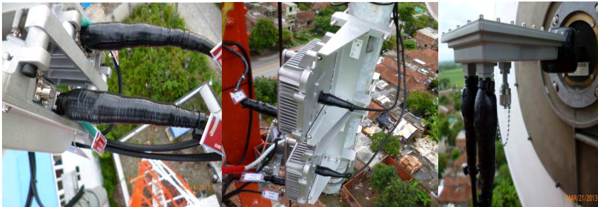
Figura23. Encintados en ODUS e HIBRIDO. Fuente: propia de este trabajo
