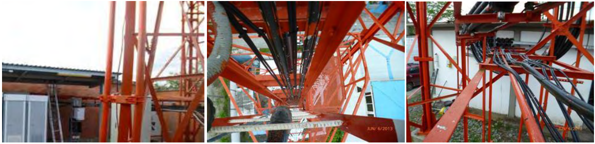
Figura 13. Fotografía Recorrido del cable IF RG8.
