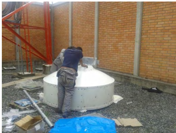
Figura12. Antena de 1.8 metros en etapa de ensamble. Fuente: propia de este trabajo
