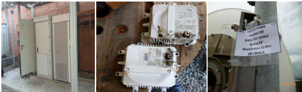
Figura 21. Fotografías telefónica movistar: Izquierda: rack La Unión, centro: ODUS remplazadas, derecha: marquilla puerto tejada
