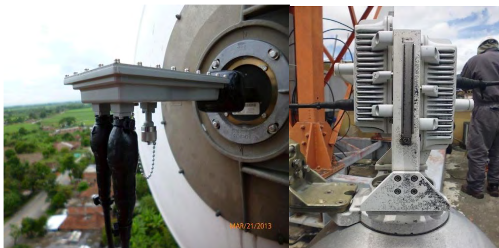
Figura5. Hibrido Ipasolink, derecha frecuencias mayores a 11 GHz, izquierdas frecuencias de 6 a 11 GHz. Fuente: propia de este trabajo.
