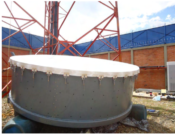
Figura14. Antena de 3.7 metros en ensamble. Fuente: propia de este trabajo
