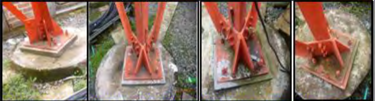
* Panorámica de la torre con la ubicación de antenas, desde diferentes ángulos, si es de montaje a reubicación indicar antena(x)
