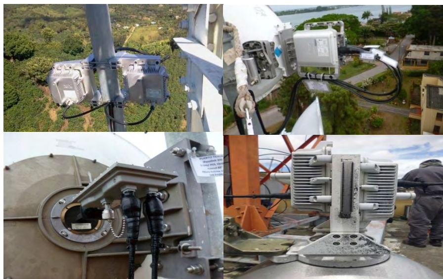
Figura18. Izquierda: ODU'S e HIBRIDO con jumper, derecha: ODUS e HIBRIDO unidos directamente a la antena. Fuente: propia de este trabajo
