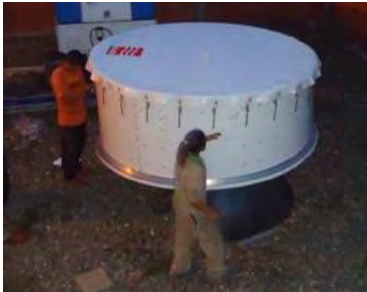
Figura13. Antena de 2.4 en finalizando su ensamble. Fuente: propia de este trabajo
