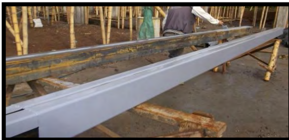
Imagen 105. Aplicación de anticorrosivo correa PHR 160x60x2.5 mm cajón.
