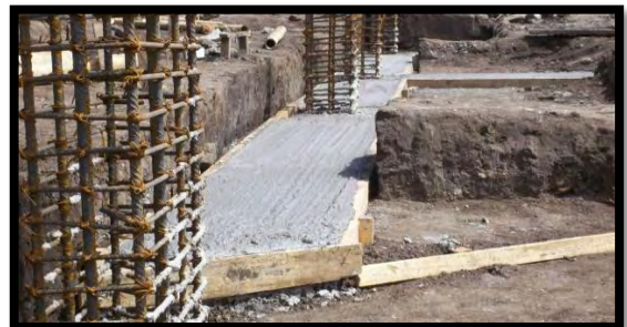
Imagen 78. Solado de limpieza de vigas de cimentación.
