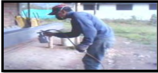
Imagen 107. Aplicación de anticorrosivo correa PHR 160x60x3mm sencillo.
