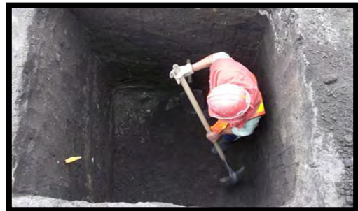
Imagen 68. Perfeccionamiento de las excavaciones.
