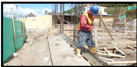
Imagen 81. Colocación del concreto y vibrado de vigas de cimentación.
