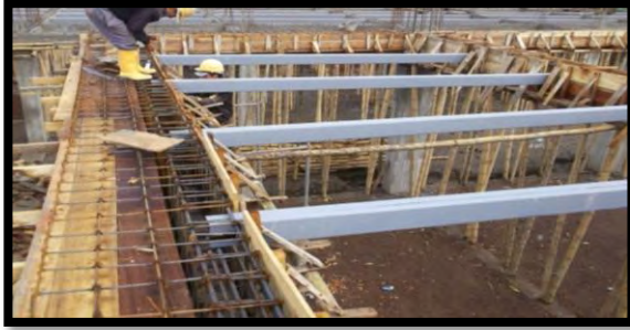
Imagen 101. Instalación del correa PHR 220x80x3mm cajón.
