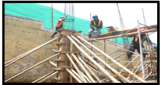
Imagen 84. Fundición de columnas.
