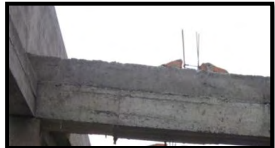
Imagen 86. Viga aérea desencofrada.
