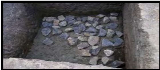
Imagen 95. Colocación del concreto ciclópeo.
