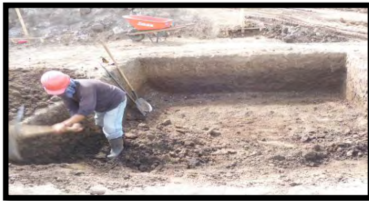
Imagen 67. Trabajos de excavación.
