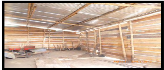
Imagen 64. Vista interior del campamento.
