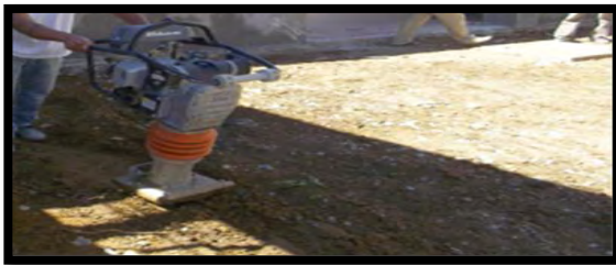
Imagen 93. Compactación de base para andenes.
