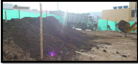
Imagen 61. Ingreso del cerramiento con polisombra y guadua.
