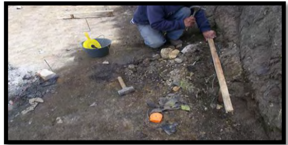
Imagen 60. Colocación de puentes de referencia.
