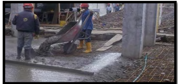
Imagen 90. Colocación de concreto para pisos.
