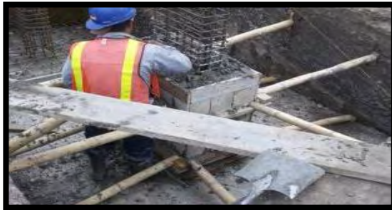
Imagen 83. Fundición de pedestales.
