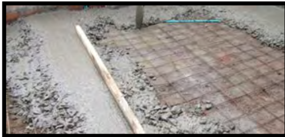
Imagen 89. Colocación de concreto para pisos.
