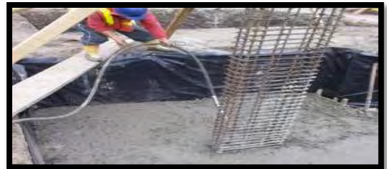
Imagen 80. Colocación y vibrado del concreto para zapatas.
