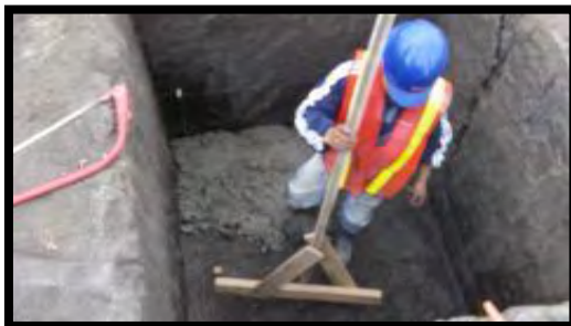
Imagen 77. Colocación del solado de limpieza en zapatas.
