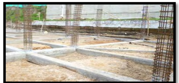
Imagen 82. Vigas de cimentación.
