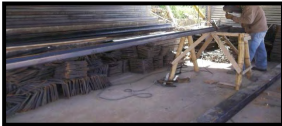
Imagen 109. Trabajo de soldadura para correa PHR 160x60x3mm.
