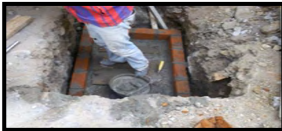
Imagen 115. Construcción trampa de grasas.
