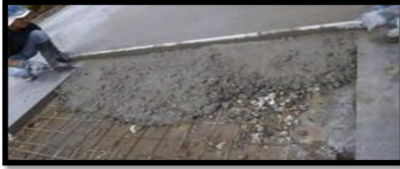
Imagen 91. Colocación de concreto para polideportivo.
