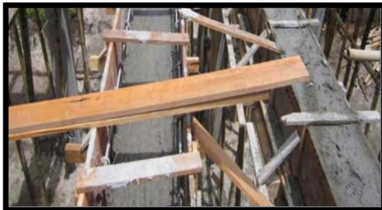
Imagen 85. Colocación de concreto para viga aérea.
