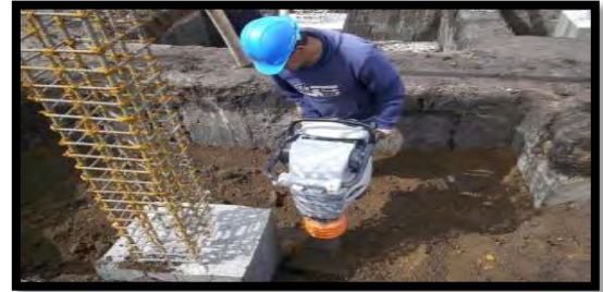
Imagen 76. Compactación de rellenos con material de sitio.
