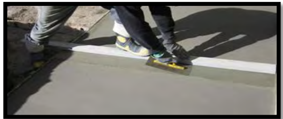
Imagen 94. Acabado superficial de andenes.
