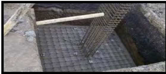
Imagen 79. Colocación del acero de refuerzo para zapatas.
