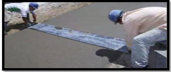
Imagen 92. Acabado del concreto para polideportivo.
