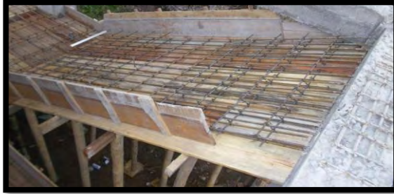
Imagen 87. Formaleta para escaleras.
