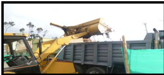
Imagen 69. Desalojo de material sobrante mediante maquinaria.
