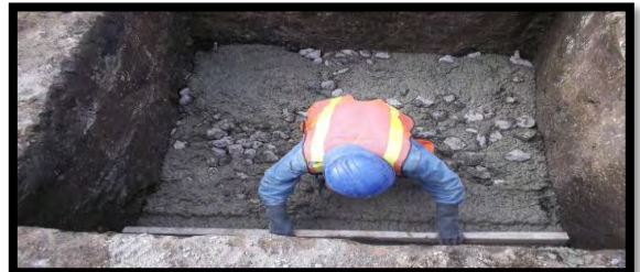
Imagen 96. Terminado del concreto ciclópeo.
