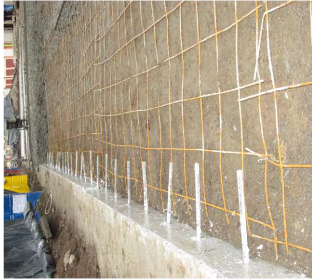
Fig. N° 41 Hierro de ½” para construcción de junta longitudinal
