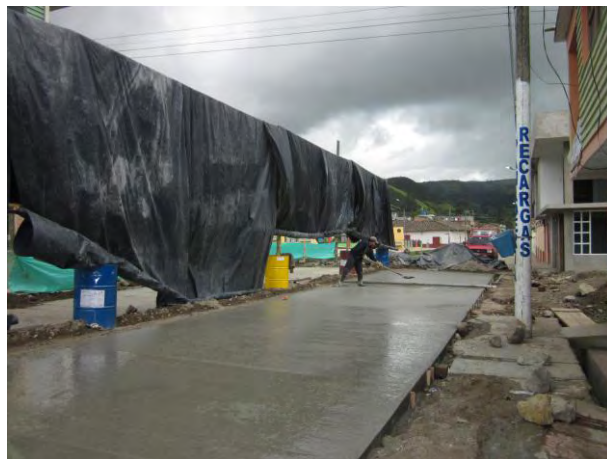
Fig. N° 44 Placa de concreto escobeadada.
