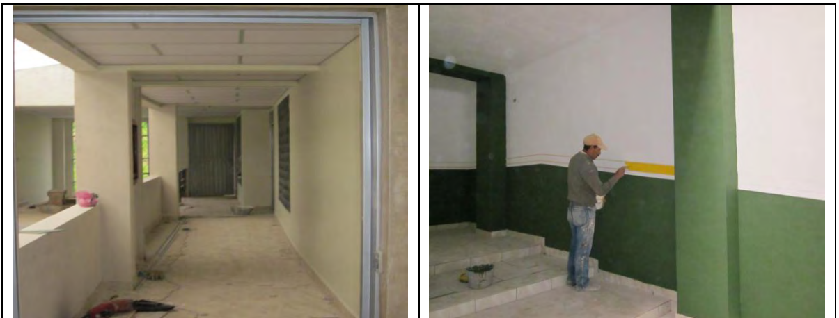
Fig. Nº 10 Acabado de la fachada, (imagen a y b indican terminado con pintura).
