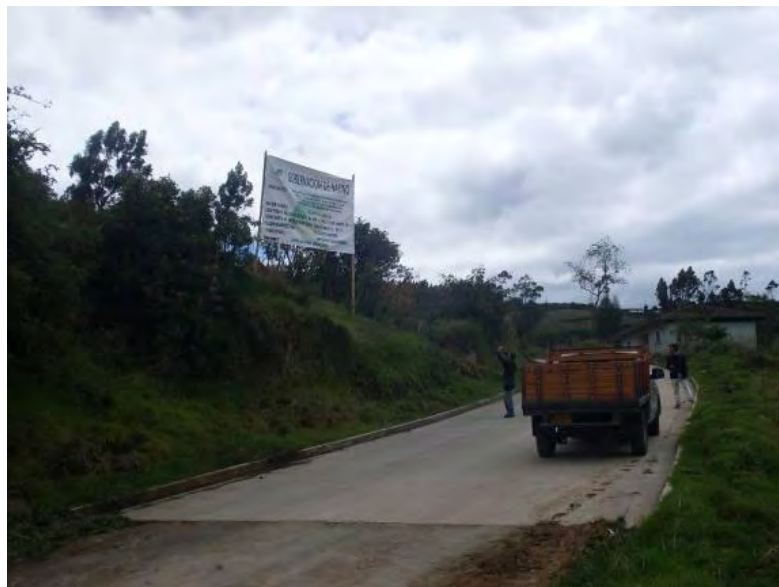
Fig. Nº 14 Colocación de valla informativa.
