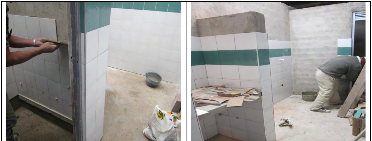
Fig. Nº 4 Acabado final de las escaleras, (imagen a indica repellido de las escaleras, imagen b indica acabado final de la escalera en cerámica).
