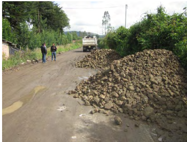
Fig. N° 53 Material de recebo acordonado en la vía
