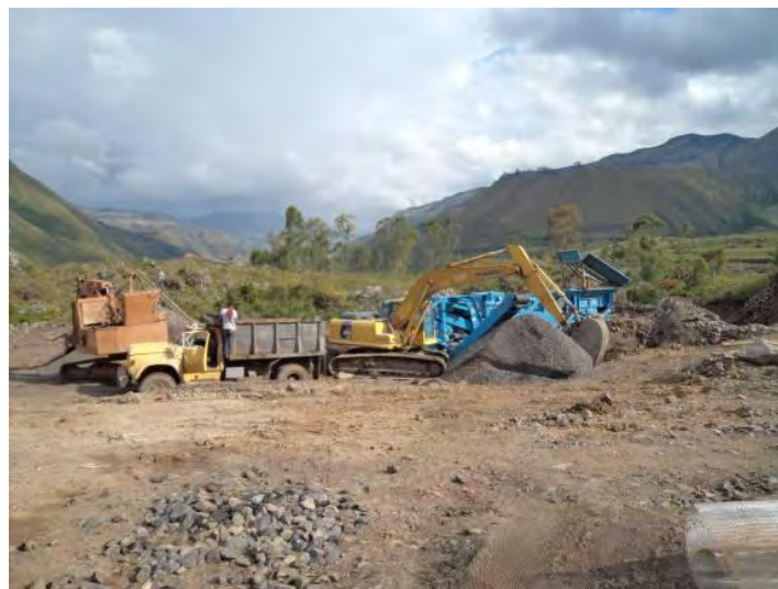
Fig. Nº 16 Canteras de material pétreo para concreto clase D MR 40 para losas
