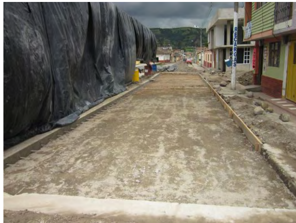
Fig. N° 37 Colocación de rieles para iniciar la reposición de los paños
