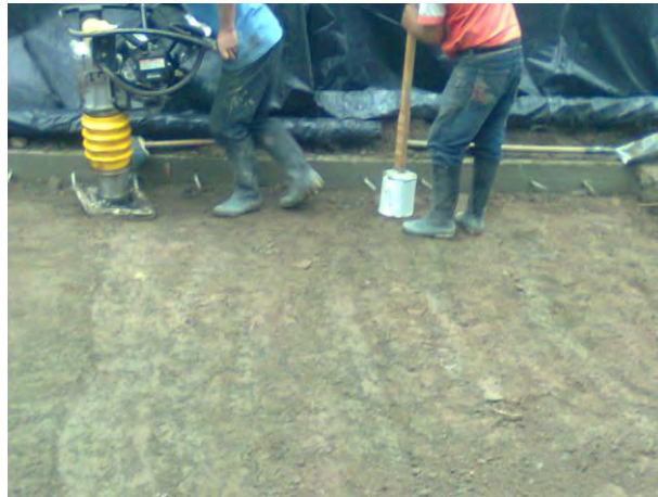
Fig. N° 36 Mejoramiento de la subbase
