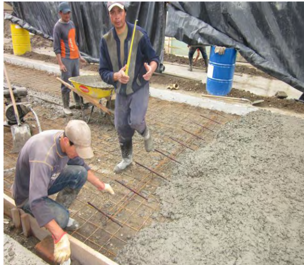
Fig. N° 42 Hierro de ¾” liso para construcción de junta transversal
