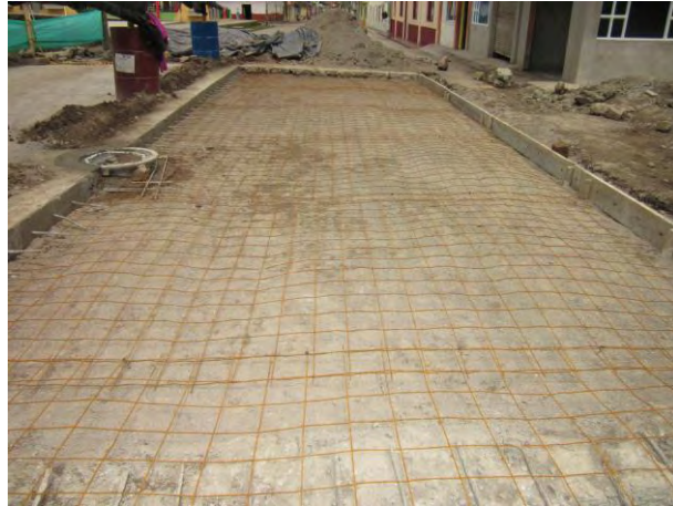
Fig. N° 38 Colocación de malla electrosoldada para iniciar la reposición de los paños
