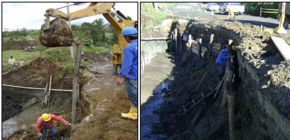
Figura 5. Entibación en excavación. Muro K 104+427 – K 104+490 parte 1 margen derecho.
