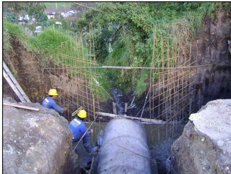
Figura 11. Instalación de acero de refuerzo. Unidad de salida alcantarilla K104+100.
