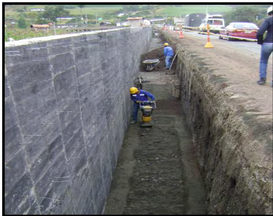
Relleno de muro. K103+893 margen derecho.
