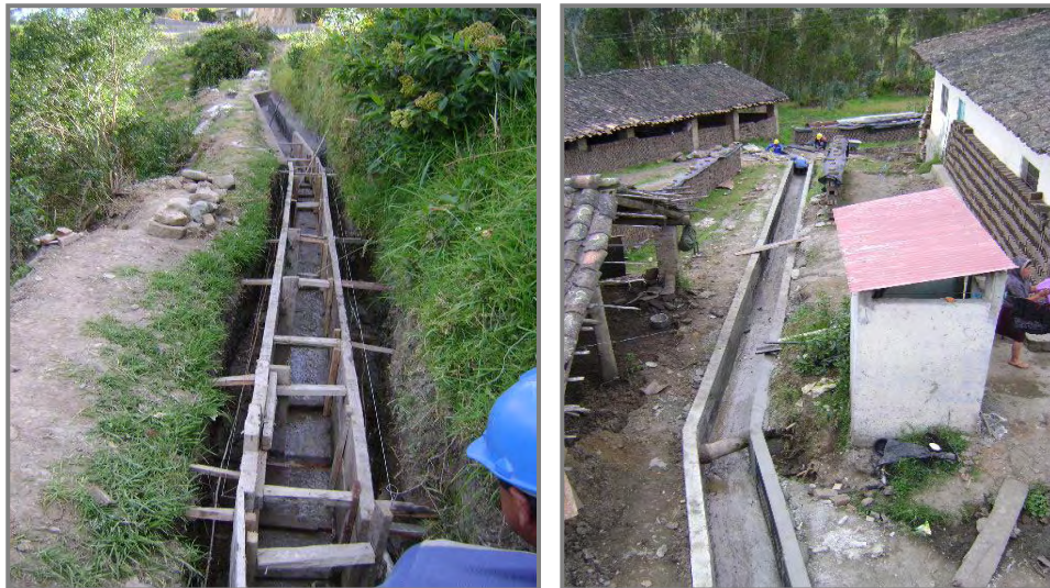
Figura 12. Construcción de obras complementarias. Canales K105+680 margen derecho.
