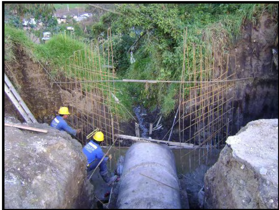
Instalación de acero de refuerzo. Unidad de salida alcantarilla K104+100.
