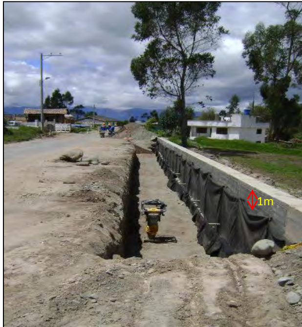
Figura 10. Relleno muro. Muro K104+988 margen derecho.
