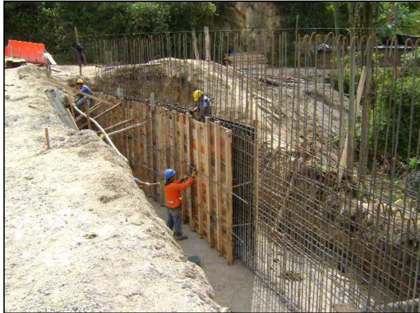
Figura 8. Encofrado estructuras. Muro K104+200 margen izquierdo.
