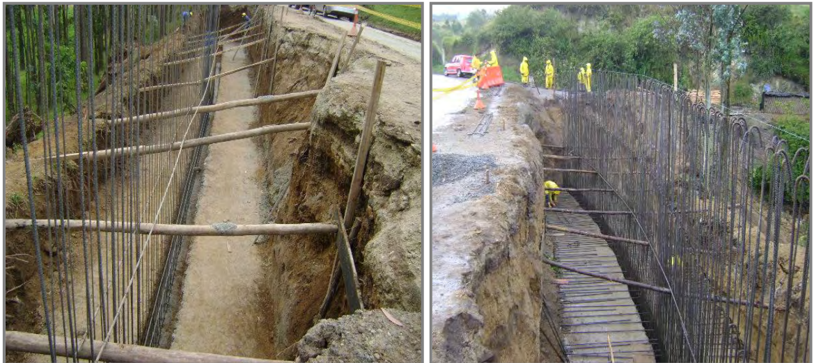
Figura 7. Instalación de acero de refuerzo. Muro K104+200 margen izquierdo.
