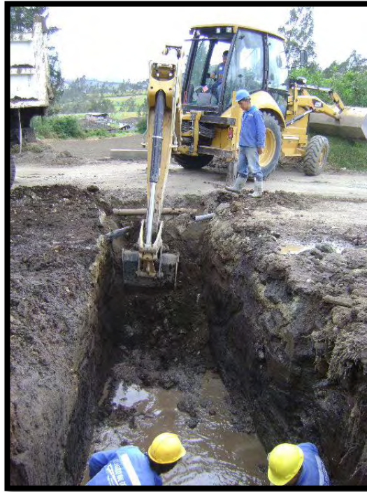
Excavación alcantarilla. Unidad de entrada alcantarilla K104+780
