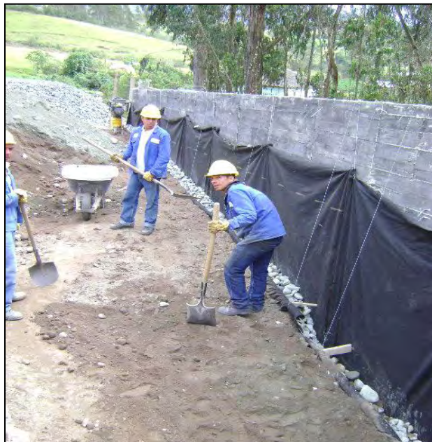
Figura 9. Relleno de muro y construcción de filtro. Muro K103+980 margen derecho.
