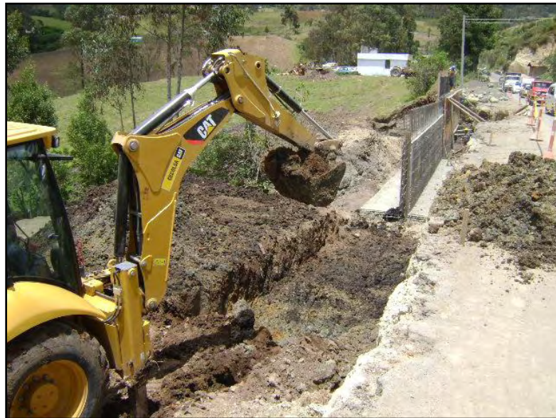
Figura 6. Excavación muro. Módulo II K104+427 - K104+490 margen derecho.
