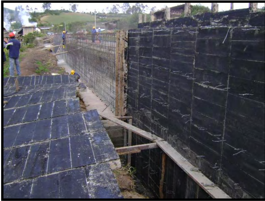
Desenfofrado de muro reforzado. Muro K103+793 margen derecho.
