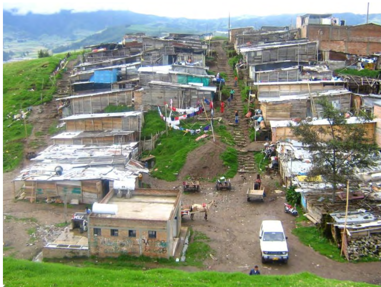
Figura 1. Sector La Cruz, antes de la construcción
