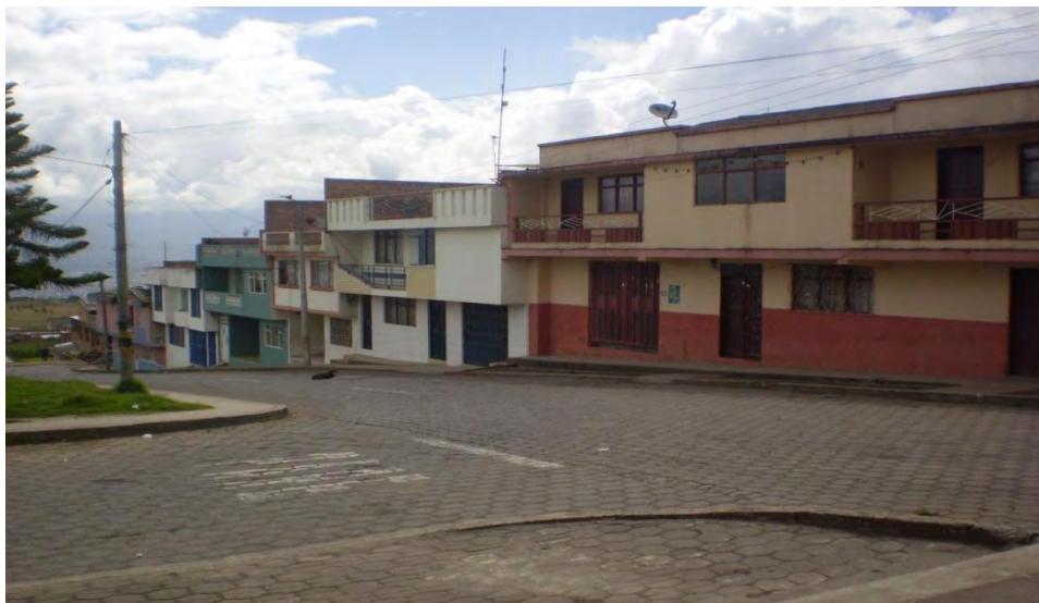
Figura 28. Unidades de viviendas
