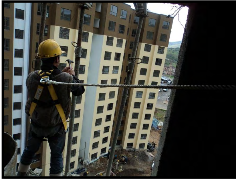
Ilustración 17. Elementos de protección y andamios para trabajos en altura (armado de bases para pluma grúa)
