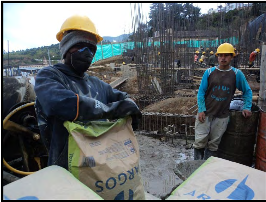
Ilustración 16. Elementos de protección para fundición de losa de transición
