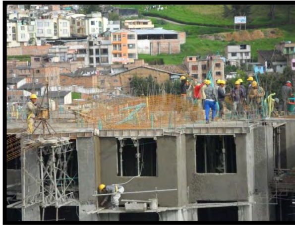
Ilustración 12. Armado de muros en concreto de apartamentos del primer piso
