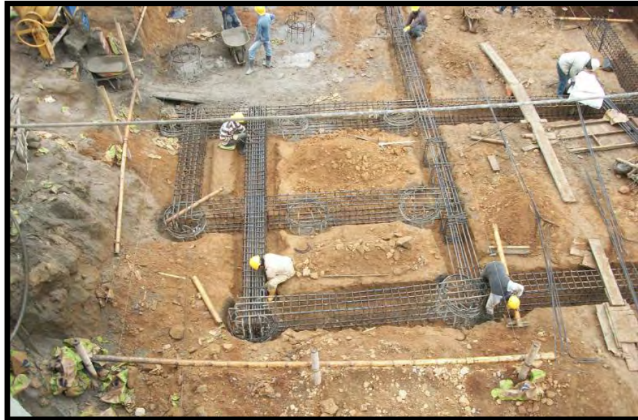
Ilustración 4. Armado de refuerzo de caissons y vigas de cimentación.
