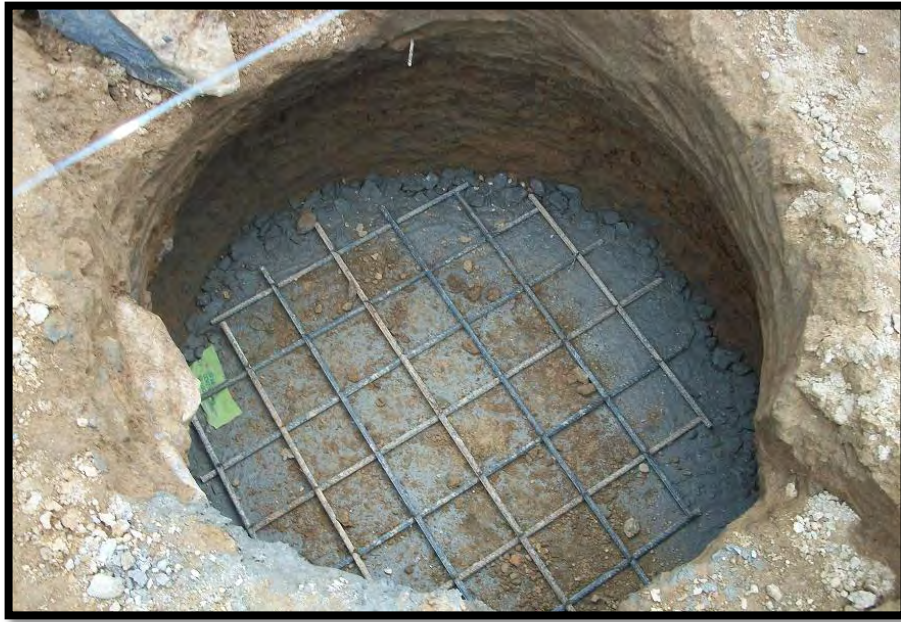
Ilustración 3. Proceso de Solado de Caissons.
