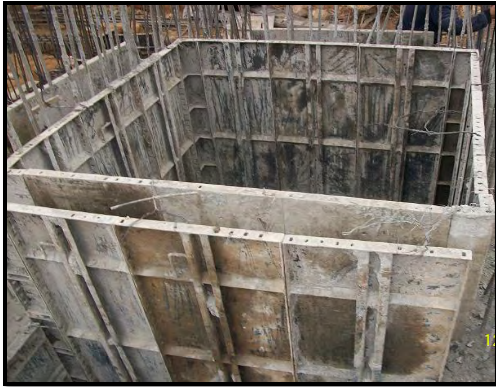
Ilustración 8. Armado de formaleta para muros y pantallas de Sótano y Semisótano.
