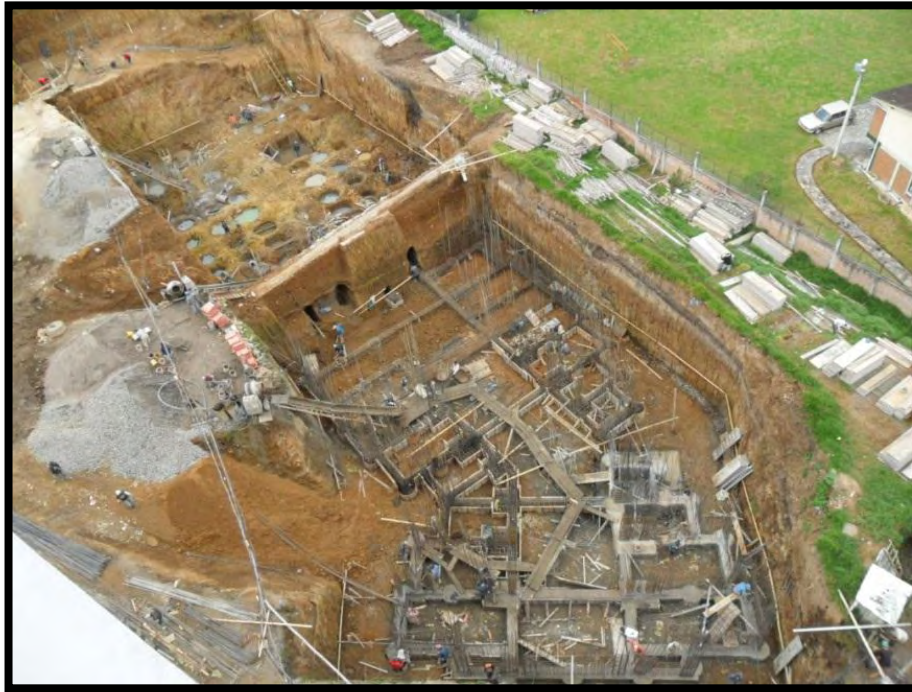
Ilustración 6. Excavación manual de caissons (Parte A) y Fundición de vigas de cimentación (Parte B).
