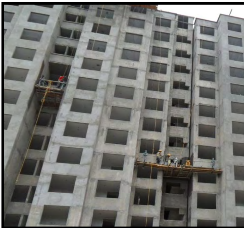
Ilustración 20. Verificación de armado y uso adecuados de andamios colgantes
