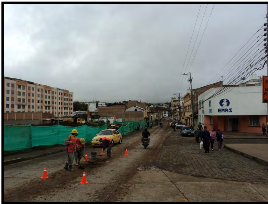
Ilustración 14. Elementos de protección y señalización para trabajos en la calle
