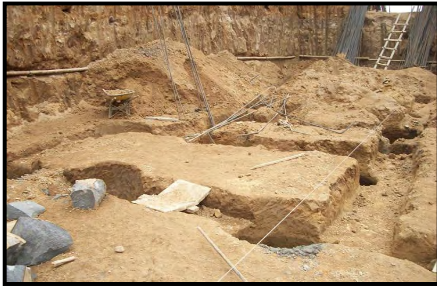
Ilustración 2 Excavación manual para Caissons y Vigas de Cimentación
