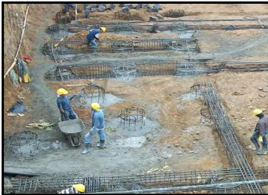
Ilustración 5. Proceso de fundición de Caissons.
