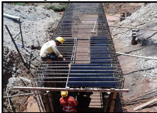
Figura 41. Acero de refuerzo y formaleta para box coulvert de. Tramo1 K 13+160 margen izquierdo sector La Dorada.
