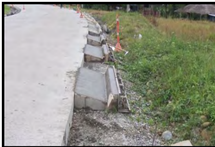
Figura 61. Fundición de cuneta, módulos iniciales - K 21+550 margen derecha sector Loro1
