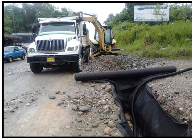
Figura 11. Excavación y extensión geotextil NT 4000 - K 22+780 margen derecha. Sector Loro 1
