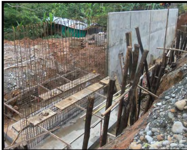
Figura 36. Fundición primer tramo de muro de contención - K 18+260 margen derecha, sector La Dorada.
