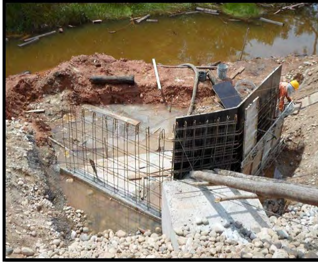
Figura 22. Armado acero cabezal. K 15+220 margen izquierda - sector La Dorada
