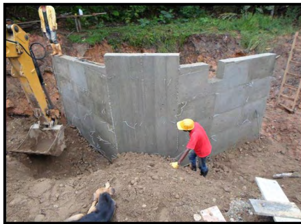
Figura 25. Cabezal de aletas en encofe de alcantarilla 36" - K 24+930 margen derecha sector La Hormiga.
