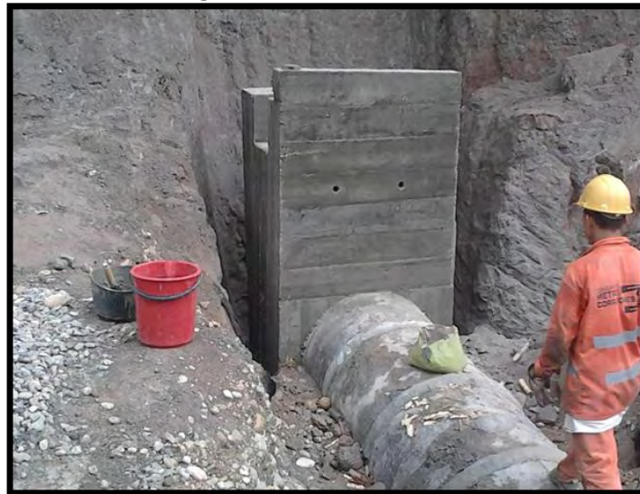
Figura 30. Fundición y retiro de formaleta para peseta de encole. Tramo 2 - K 13+860 margen derecha, sector La Dorada.
