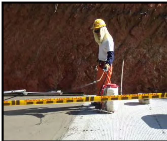
Figura 58. Aplicación de antisol - K 19+850 al K 20+000
