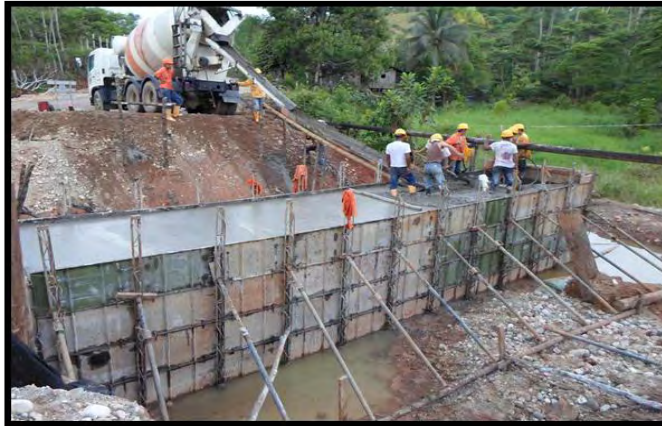
Figura 42. Fundición cuerpo de box coulvert, tramo 1
