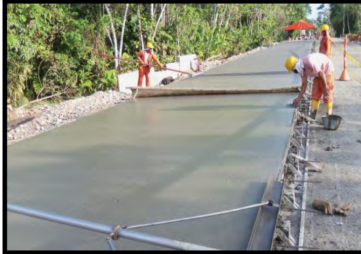
Figura 56. Microtexturizado - K 19+850 al K 20+000
