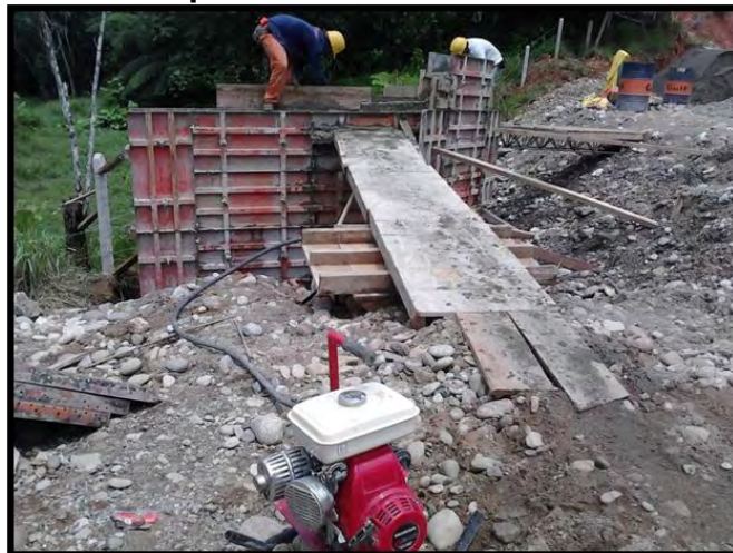
Figura 23. Formaleta metálica para cabezal de aletas - K 15+590 margen izquierda. sector la Dorada.
