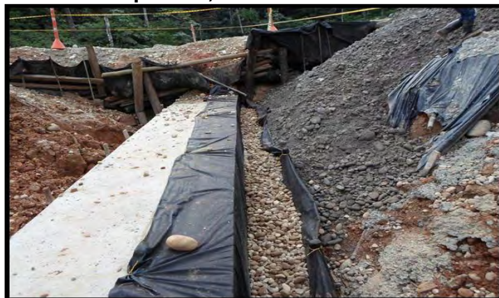
Figura 43. Construcción filtro para box coulvert tramo1 - K 13+160 margen izquierdo, sector La Dorada.
