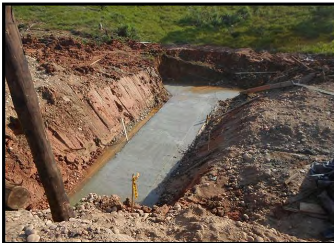
Figura 27. Excavación, mejoramiento y solado, tramo 2 - K 13+860 margen derecha, sector La Dorada.
