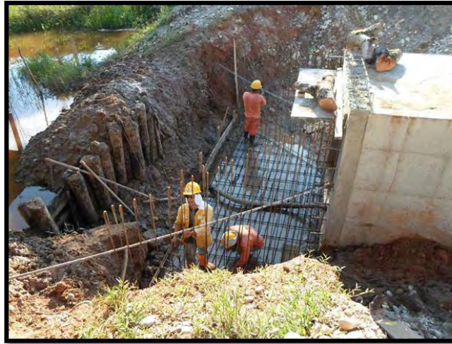
Figura 44. Construcción cabezal aletas para box coulvert tramo 1 - K 13+160 margen izquierdo, sector La Dorada.
