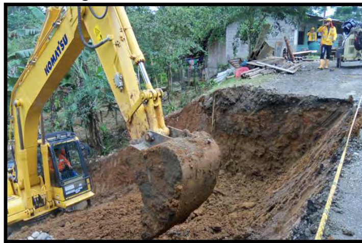
Figura 31. Excavación para cimentación muro de contención - K 18+260 margen derecha, sector La Dorada.
