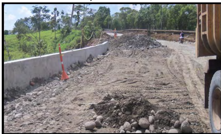
Figura 38. Lleno estructural para muro de contención - K 18+260 margen derecha, sector La Dorada
