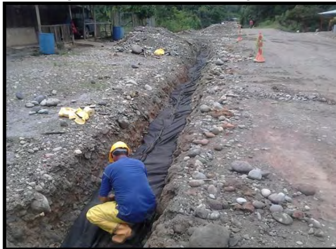
Figura 13. Costura de geotextil. K 22+780 margen derecha. sector Loro 1.
