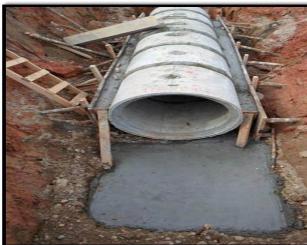
Figura 28. Instalación tubería y fundición atraque a medio tubo, tramo 2 - K 13+860 margen derecha, sector La Dorada.
