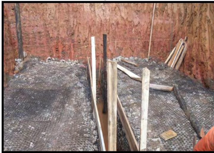
Figura 33. Extensión de geomalla triaxial y lleno con material aluvial para mejoramiento. K 18+260 margen derecha, sector La Dorada.
