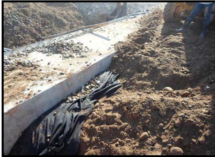
Figura 48. Construcción de filtro y Relleno para complemento de box coulvert tramo 2 - K 13+160 margen derecho, sector La Dorada
