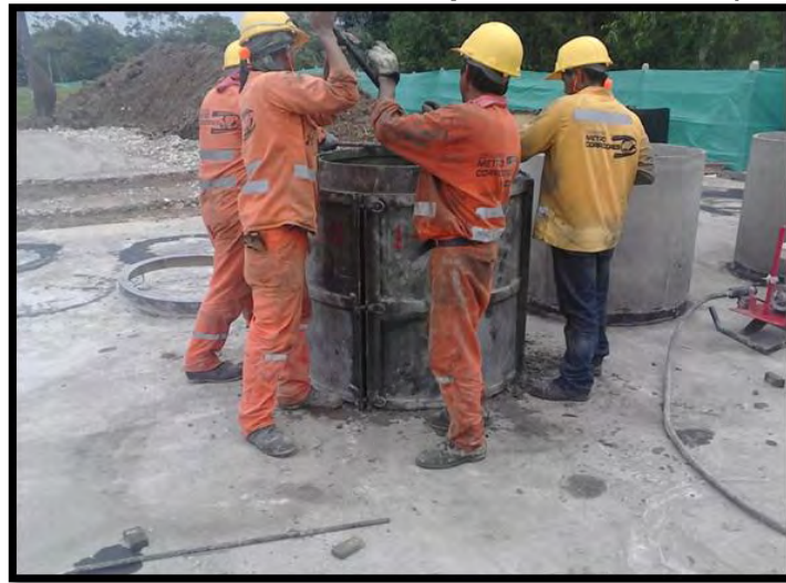
Figura 18. Retiro de formaleta para tubería 36" (900mm)
