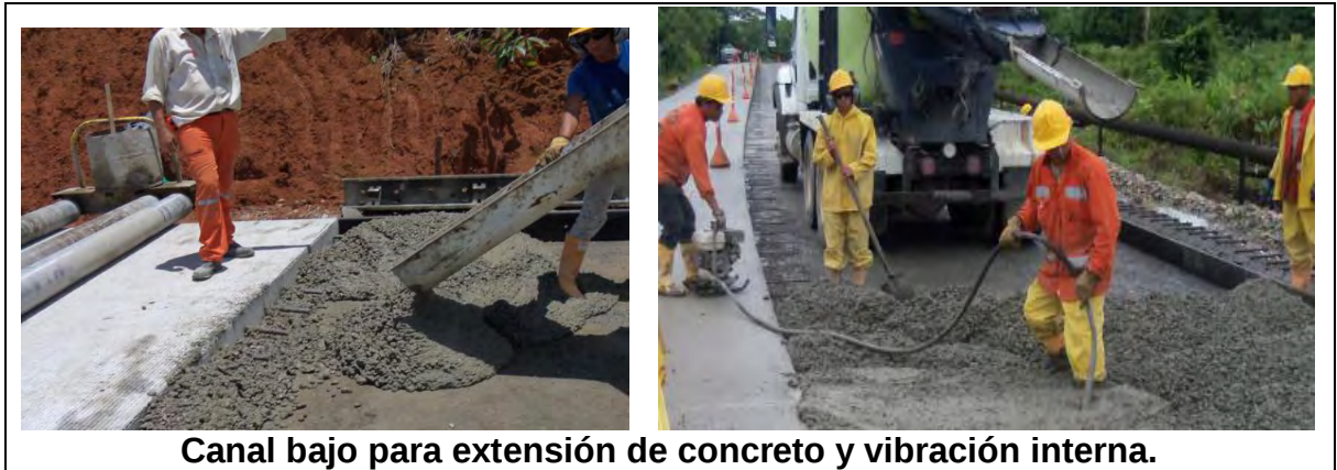
Figura 53. Extendido y vibrado de concreto para placa de pavimento - K 19+850 al K 20+000
