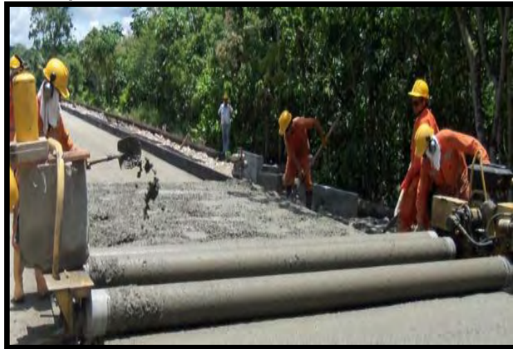
Figura 54. Acabado superficial con rodillo vibratorio - K 19+850 al K 20+000
