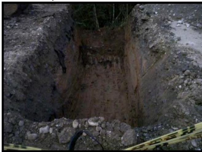
Figura 15. Excavación para tramo 1 de alcantarilla K 13+410 margen izquierda. sector La Dorada
