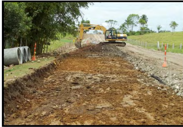
Figura 4. Cajeo media banca K14+650 margen derecha – sector La Dorada
