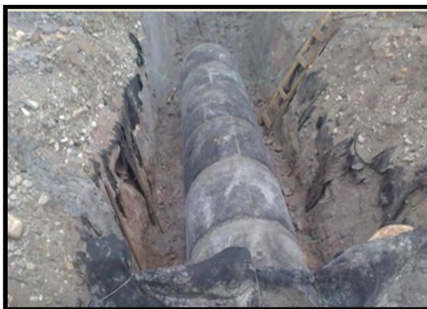
Figura 20. Instalación tubería 36" (900mm) Tramo 1 - K 19+480 margen derecha. sector Loro 1.
