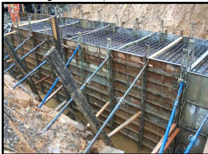
Figura 47. Armado de refuerzo y formaleta box coulvert tramo 2 - K 13+160 margen derecho, sector La Dorada
