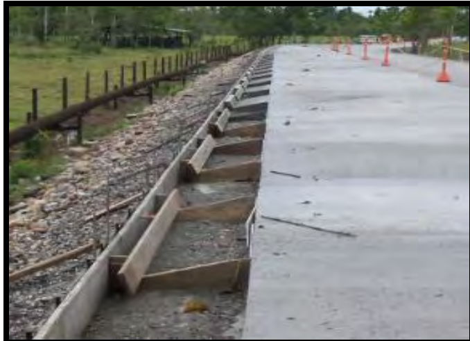
Figura 60. Formaleta para cuneta - K 21+550 margen derecha, sector Loro1
