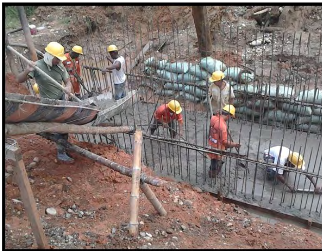
Figura 46. Fundición losa inferior box coulvert, tramo 2 - K 13+160 margen derecho sector La Dorada
