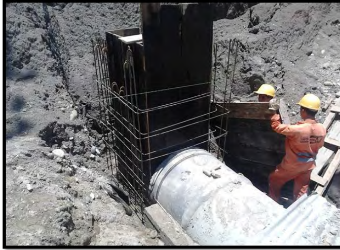
Figura 29. Armado acero cabezal y formaleta para poceta de encole - tramo 2. K 13+860 margen derecha, sector La Dorada.
