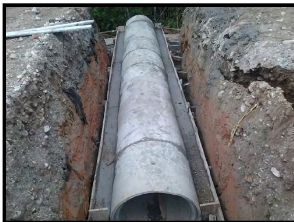
Figura 21. Formaleta y fundición atraque a medio tubo - K 13+860 margen derecha. sector La Dorada.
