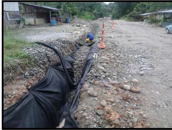
Figura 12. Extensión de tubería Perforada 4" y lleno con material filtrante K 22+780 margen derecha. Sector Loro 1
