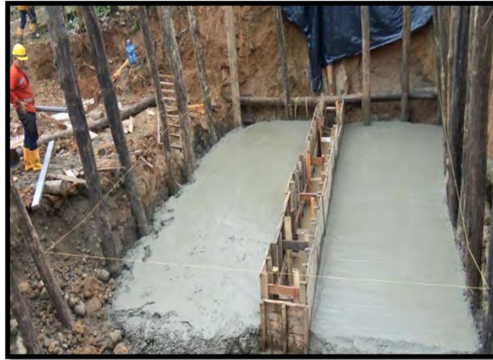
Figura 34. Solado para muro de contención - K 18+260 margen derecha, sector La Dorada.
