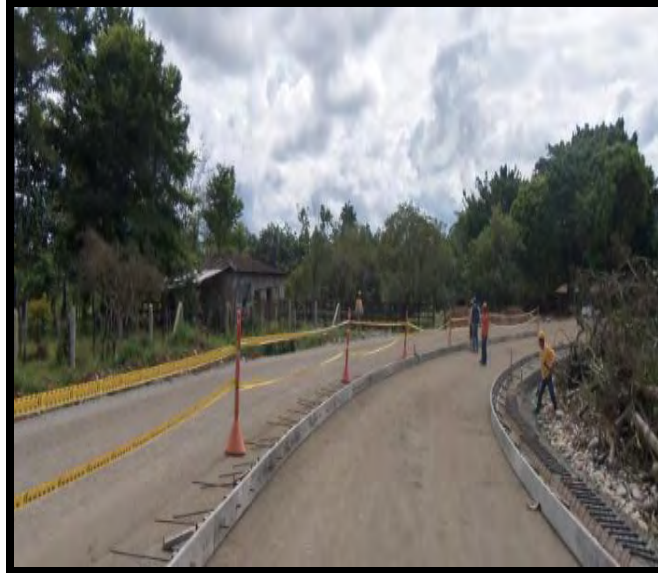
Figura 52. Instalación de formaleta para placas de pavimento - K 19+850 al K 20+000
