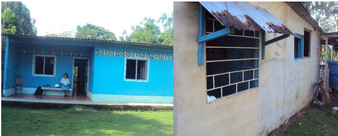
Figura 3. Registro fotográfico de estado de la vivienda
