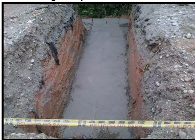
Figura 16. Solado para tubería y cabezal Tramo 1 concreto clase F - K 13 +410 margen izquierda. sector La Dorada
