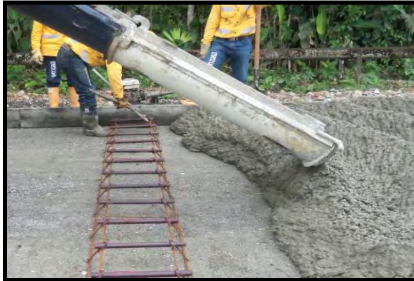
Figura 55. Instalación de junta transversal de contracción - K 19+850 al K 20+000
