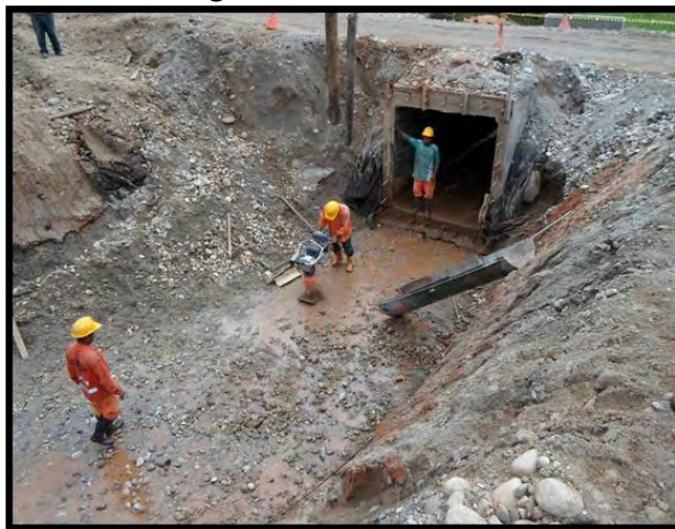
Figura 45. Excavación y compactación de material aluvial para mejoramiento K 13+160 margen derecho, sector La Dorada
