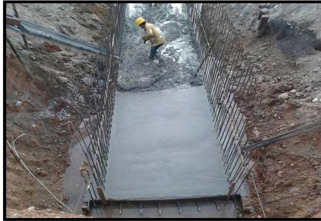
Figura 40. Fundición Losa inferior box coulvert - K 13+160 margen izquierda sector La Dorada.
