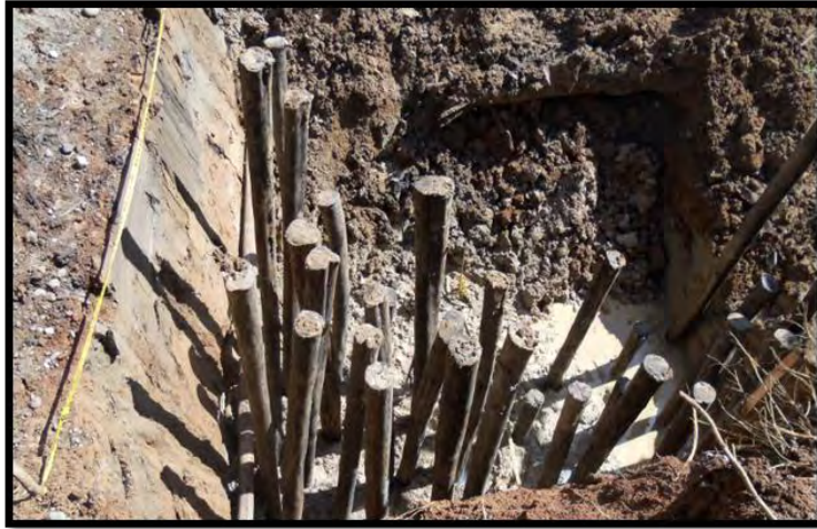
Figura 32. Pilotes en madera para cimentación de muro
