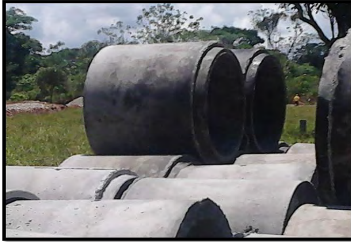
Figura 19. Acopio de tubería en concreto reforzado 36" (900mm).
