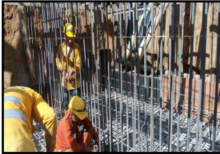
Figura 35. Armado acero para muro de contención - K 18+260 margen derecha, sector La Dorada.
