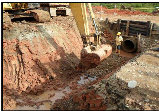
Figura 26. Excavación complemento alcantarilla 36" (900mm) tramo 2 - K 13+860 margen derecha sector La Dorada.
