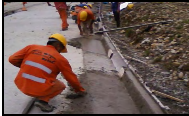
Figura 62. Fundición cuneta, módulos finales - K 21+550 margen derecha, sector Loro1
