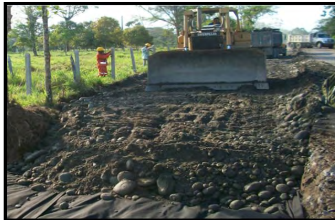
Figura 8. Lleno con material aluvial para mejoramiento - K 14+680 margen derecha. sector La Dorada.
