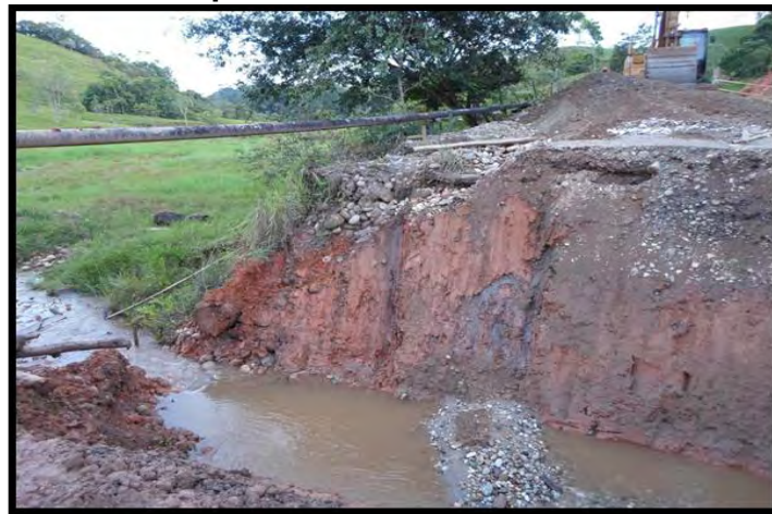
Figura 39. Excavación para box coulvert, tramo 1 - K13+160 margen izquierda, sector La Dorada
