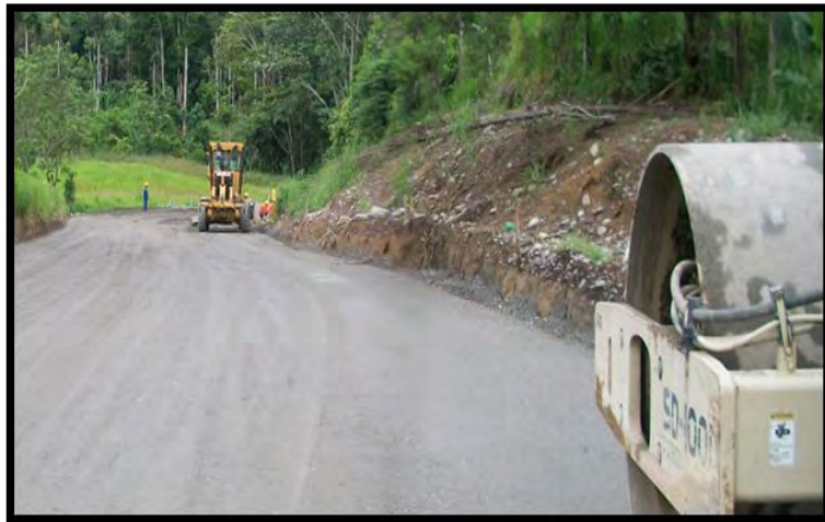
Figura 50. Compactación de base granular - K 18+080 al K 18+150, sector Loro 1
