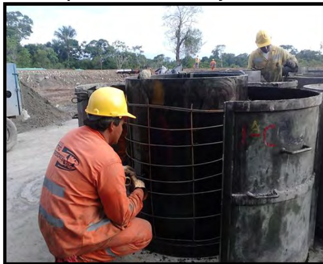
Figura 17. Preparación canastilla y formaleta de acero
