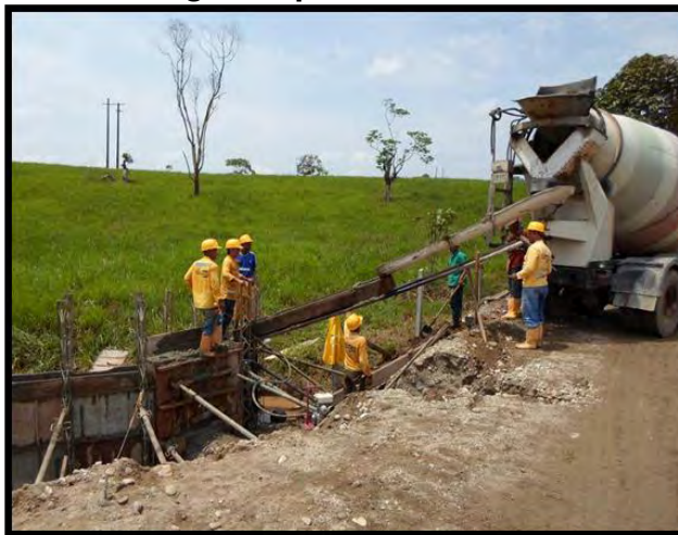
Figura 24. Vaciado de concreto premezclado para cabezal de aletas - K 13+860 margen izquierda. sector La Dorada
