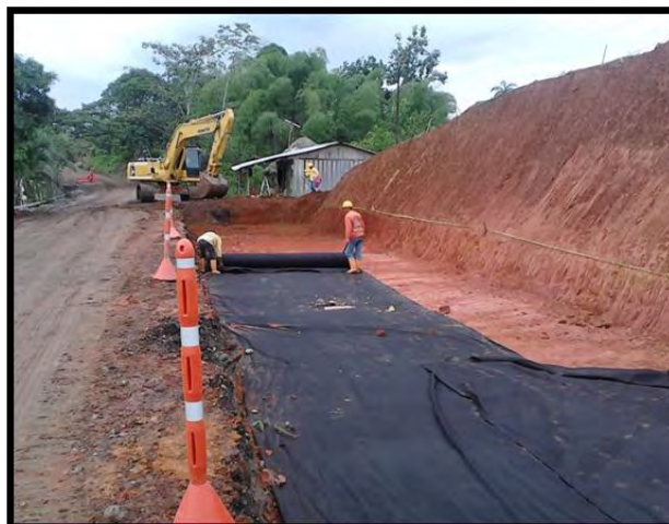
Figura 5. Extensión de geotextil NT 4000 PAVCO S.A. K 19+340 margen derecha - sector loro 1
