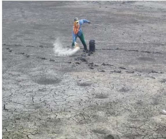
Figura 5. Adecuación de estanques.
